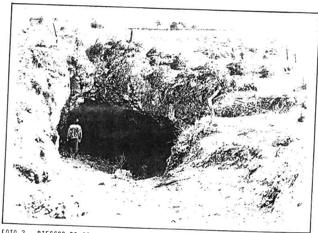
FOTO 2.- RIESGOS DE COLAPSO DE CAVIDADES KARSTICAS. CUEVA DEL CONEJAR
