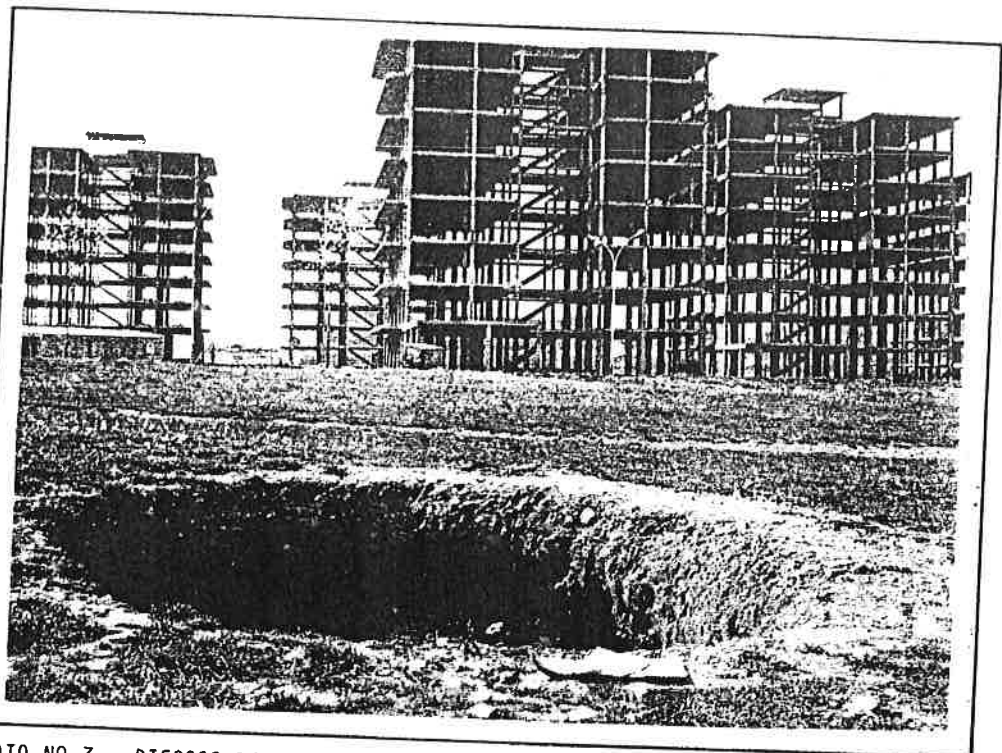
FOTO Nº 3.- RIESGOS DE COLAPSO DE SUELOS. HUNDIMIENTO EN UN SOLAR DE LA DEHESA DE LOS CABALLOS
