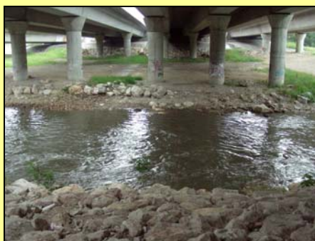
Izda.: río Jarama en el cruce de la M-50
