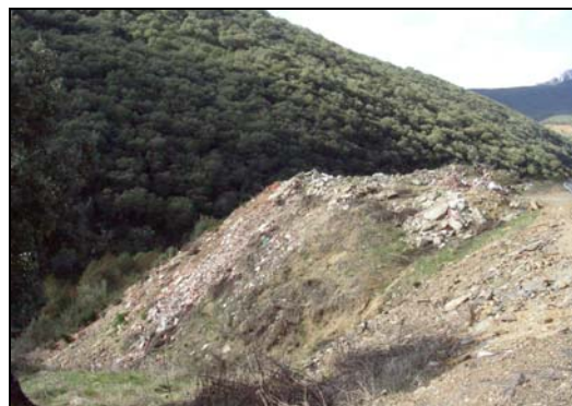
Vertedero sobre el talud de la carretera
