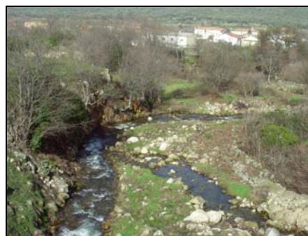
Taludes erosionados aguas abajo y núcleo urbano al fondo
