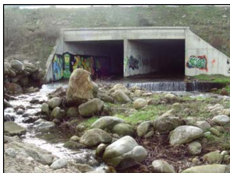
Paso bajo la Autovía A-66 Ruta de la Plata
