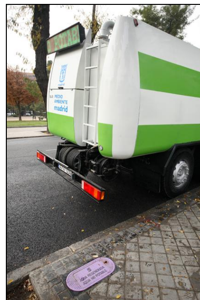
Figura 1. Hidrante de agua regenerada en una acera de Madrid. Fuente: Ayto. de Madrid.
