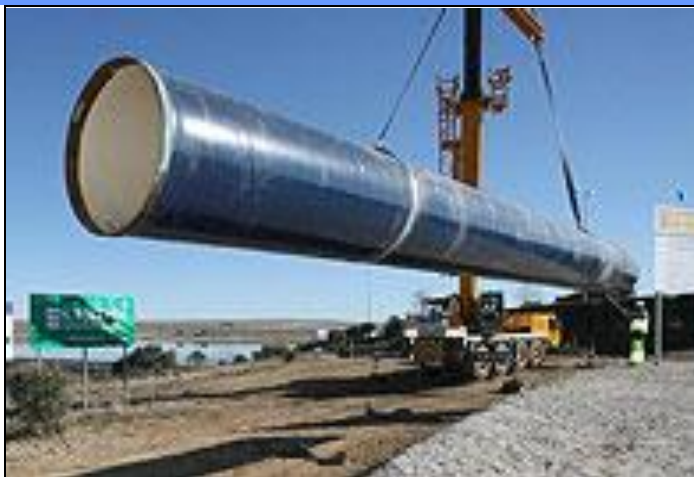
Figura 6. Instalación de tubería de la actuación "Conducción desde Portaje para el abastecimiento de Cáceres"
