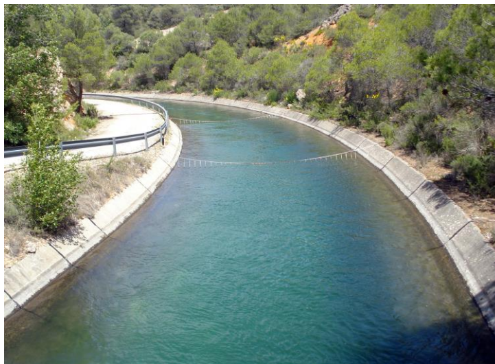
Acueducto del trasvase Tajo-Segura
