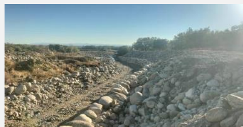
Estabilización del talud de margen derecha. Garganta de Santa María, TTMM Candeleda (Ávila)
