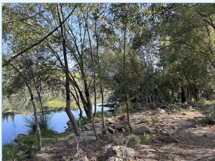
Resalveo y poda sanitaria de los pies, desbroce selectivo con eliminación de especies exóticas invasoras. Tramo río Alagón en el TTMM de Valdeobispo. Life Alnus Taejo, 2025.
