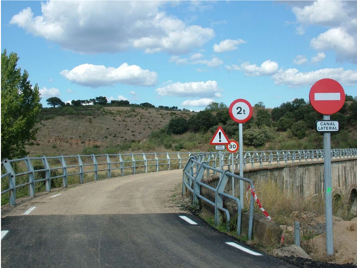
Acueducto canal III-A de los Riegos del Arrago
