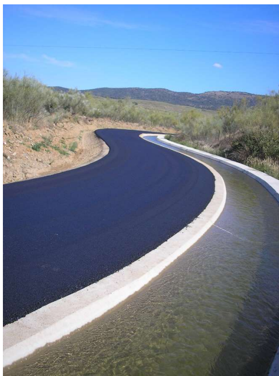
Canal y camino Sector IX de los Riegos del Alagón
