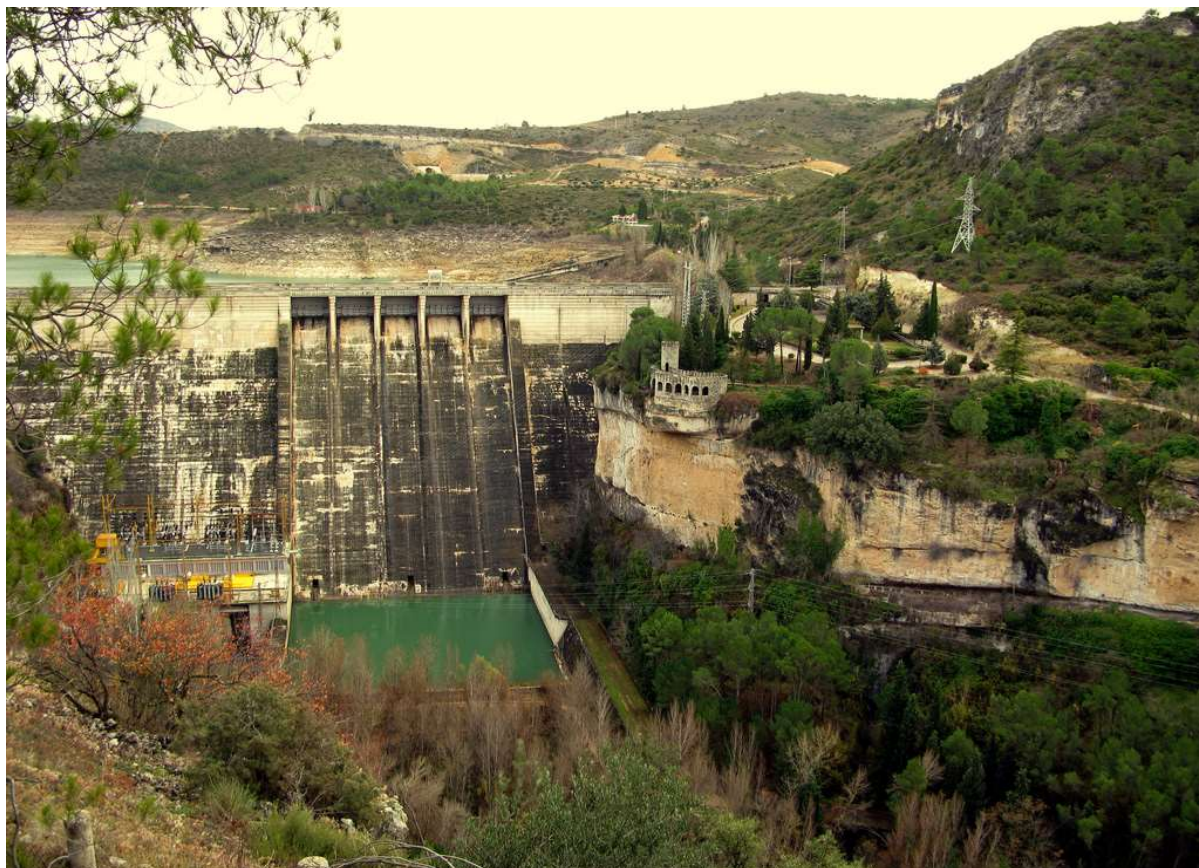
Presa de Entrepeñas
