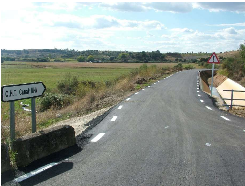
Inicio Canal III-A de los Riegos del Árrago
