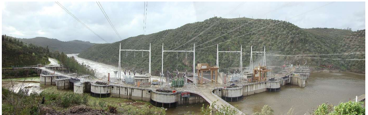
Presa de Cedillo
