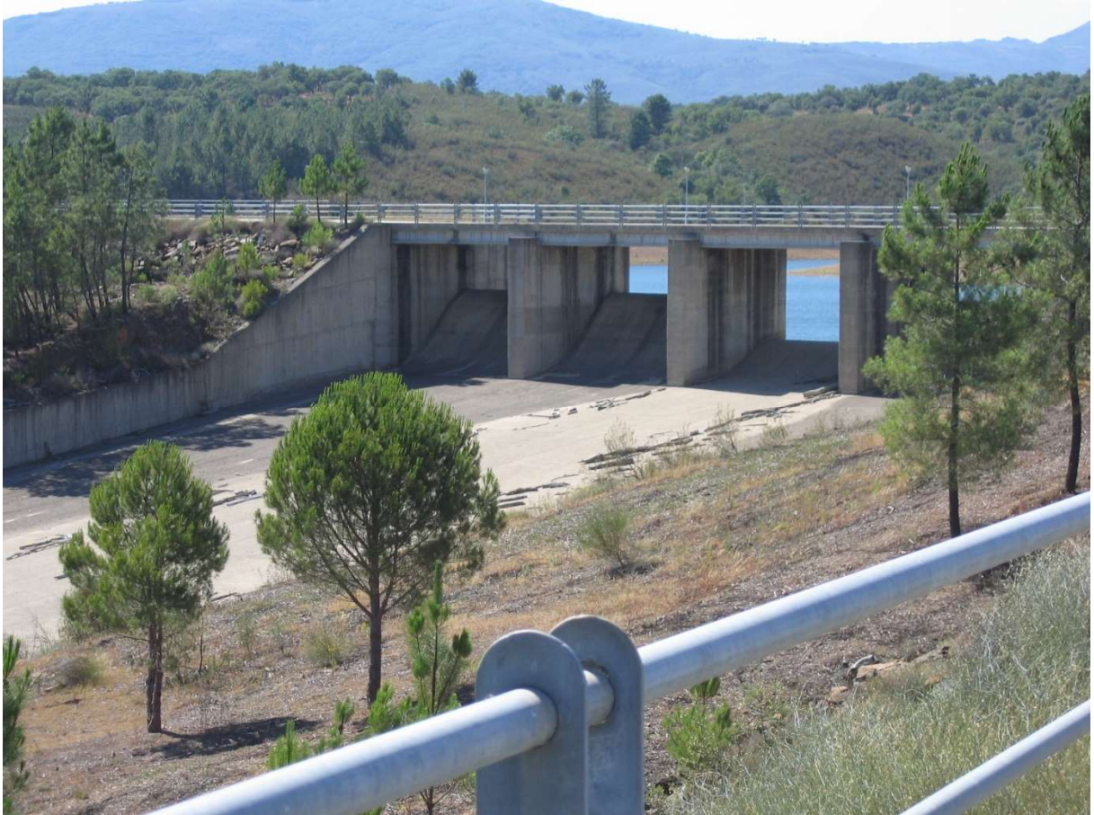
Aliviadero Presa de Rivera de Gata
