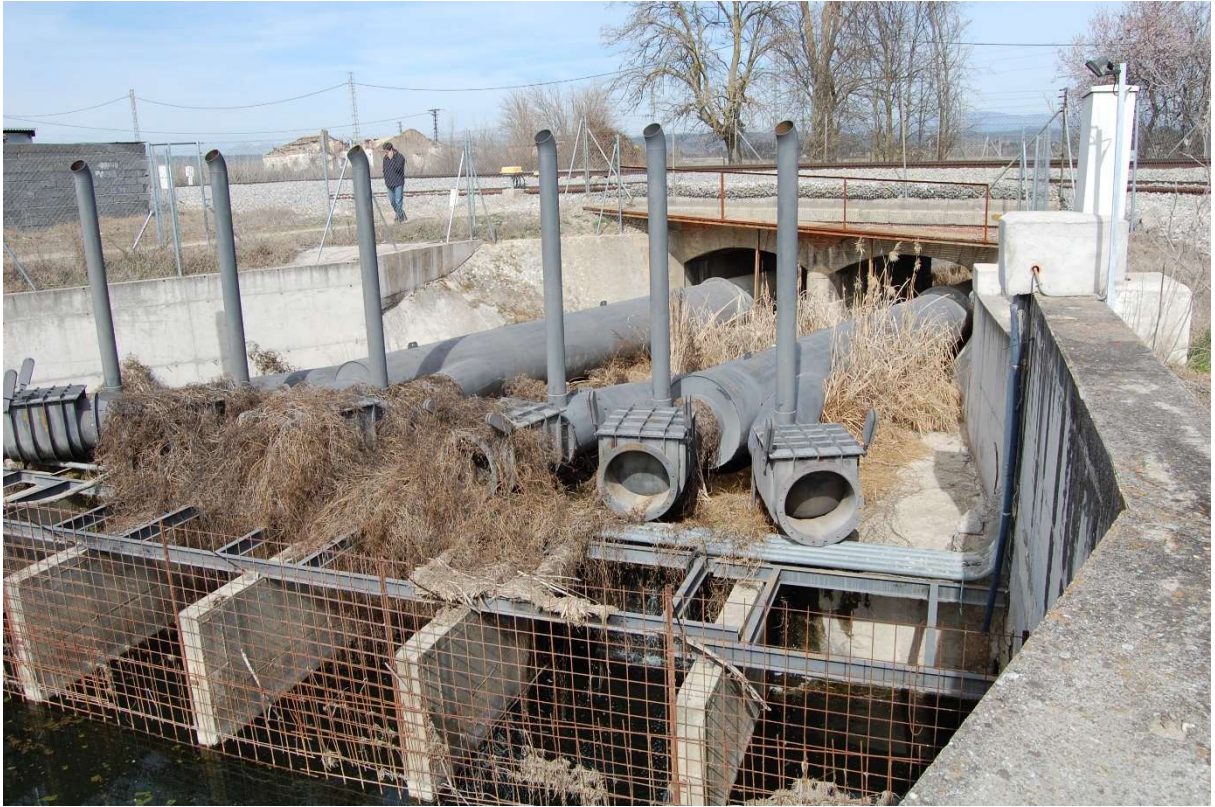
Elevación del río Tajo al Canal Bajo del Alberche en el arroyo de las Parras
