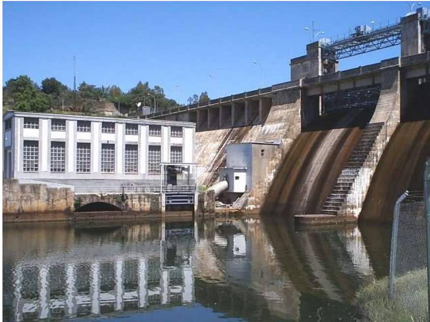
Presa de Borbollón
