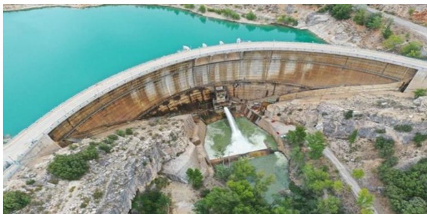
Presa de La Tajera
