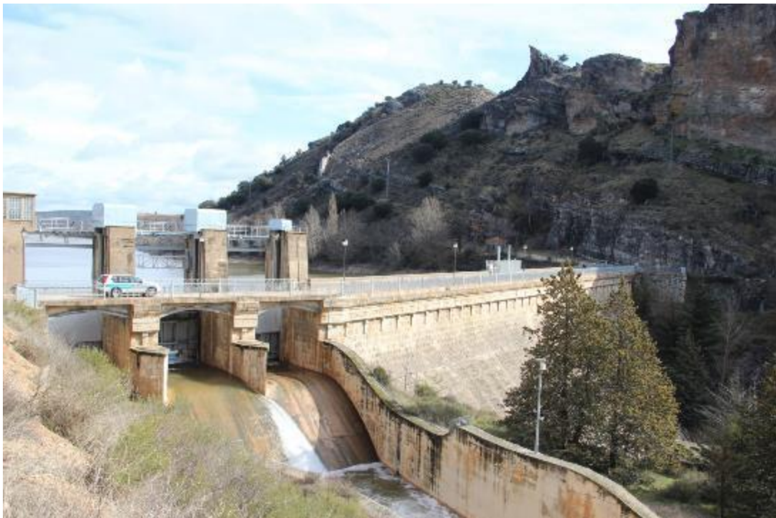
Presa de Pálmaces
