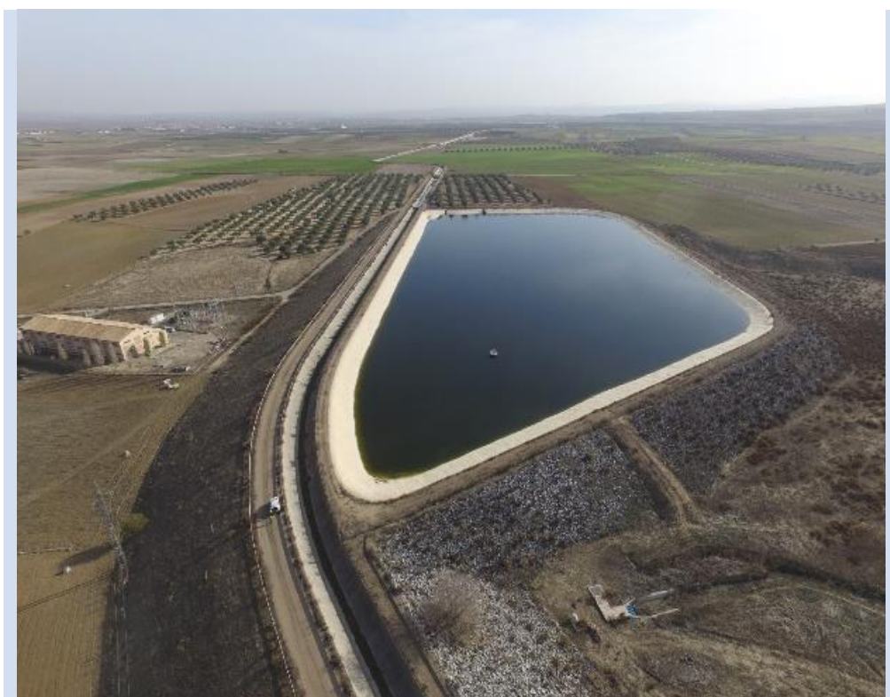
Balsa Sector II-A (balsa de Captación) y Estación de Bombeo
