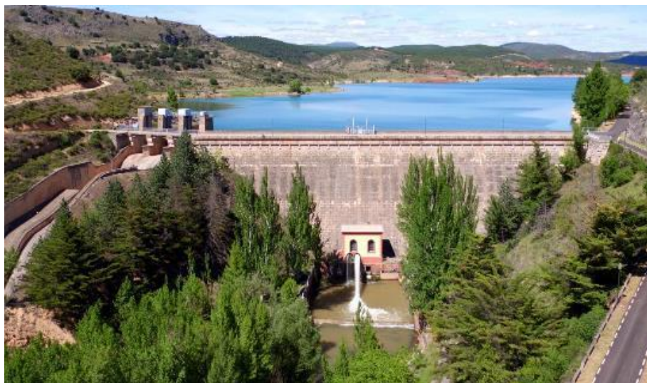
Presa de Pálmaces
