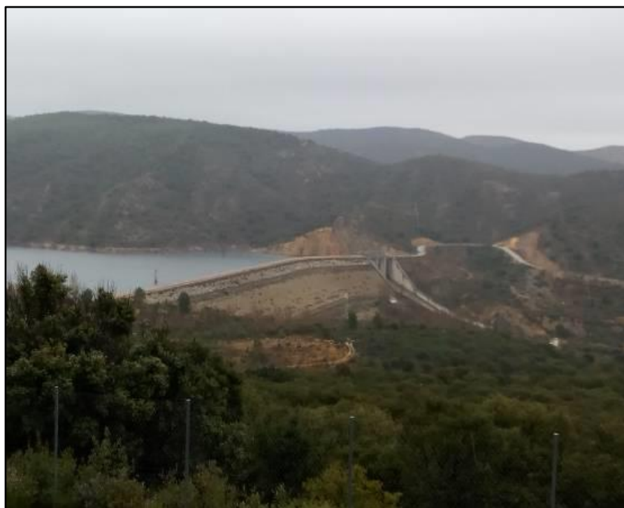
Presa de Beleña
