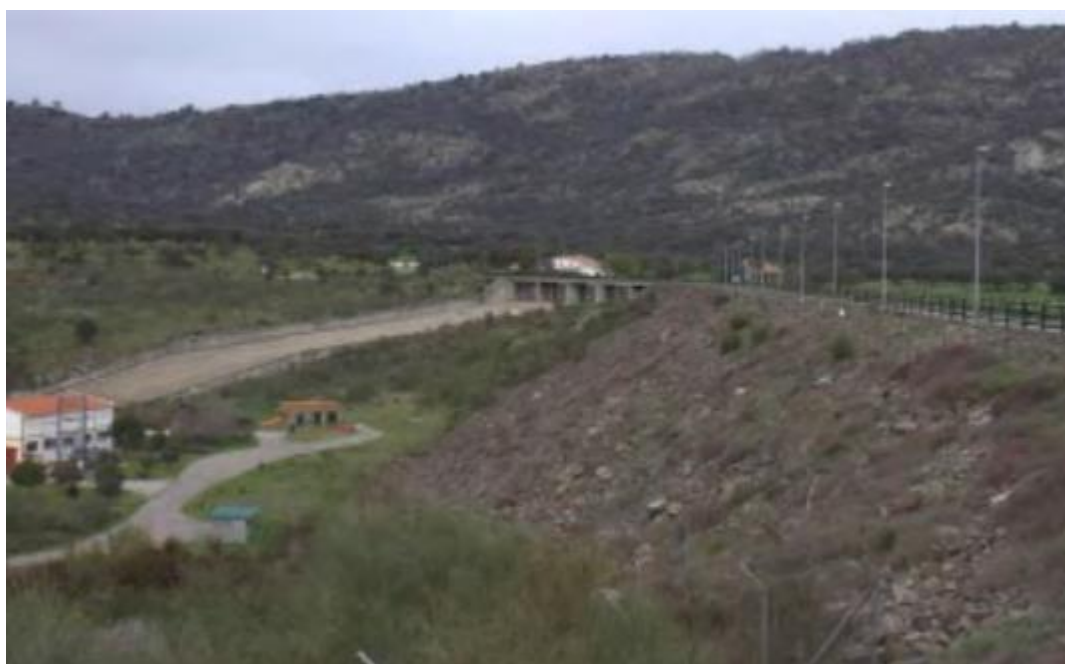
Aliviadero Presa del Jerte
