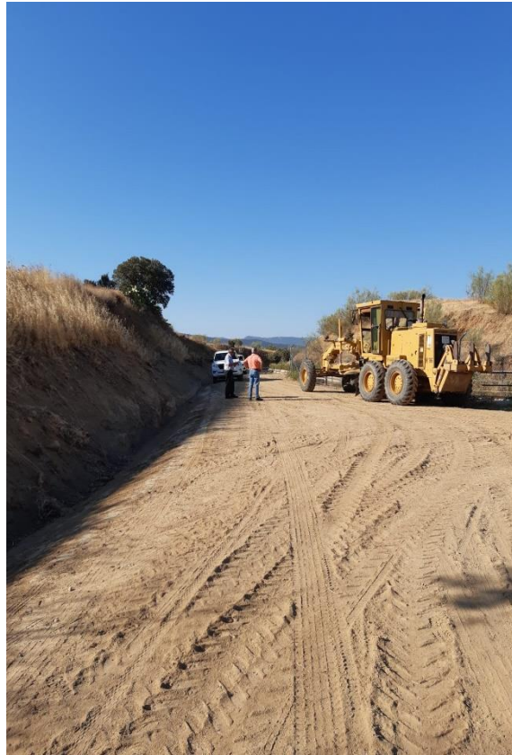
Trabajos de acondicionamiento de camino de servicio de la acequia XIII-46
