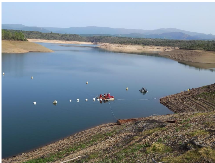
Obras de reparación de la toma de Rivera de Gata con buzos
