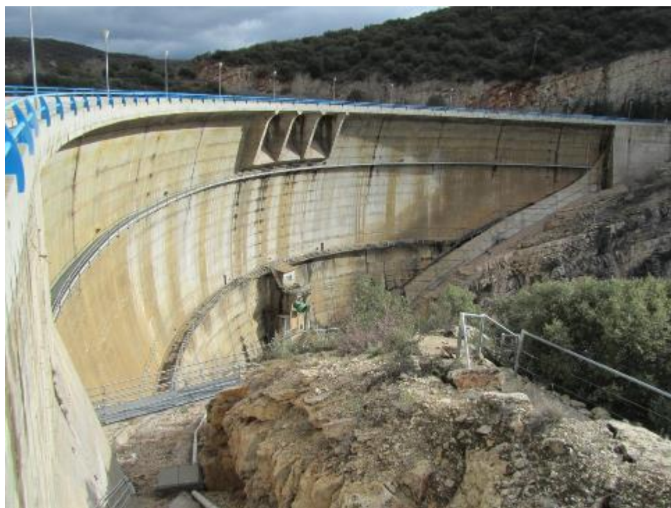
Presa de La Tajera
