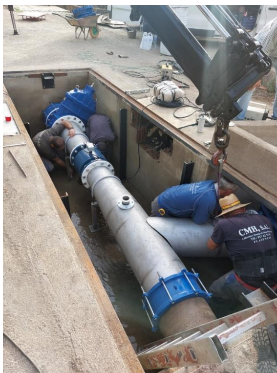
Obras de conexión de la mancomunidad con el desagüe de fondo de Rivera de Gata.
