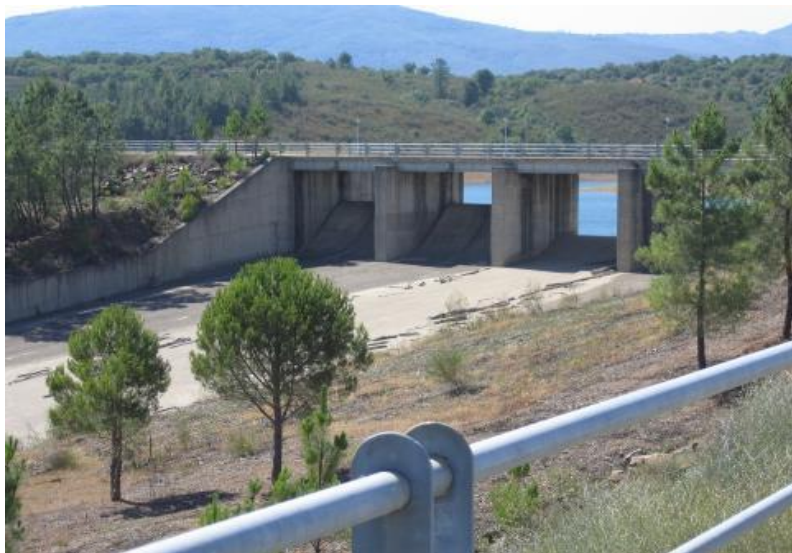
Aliviadero Presa de Rivera de Gata
