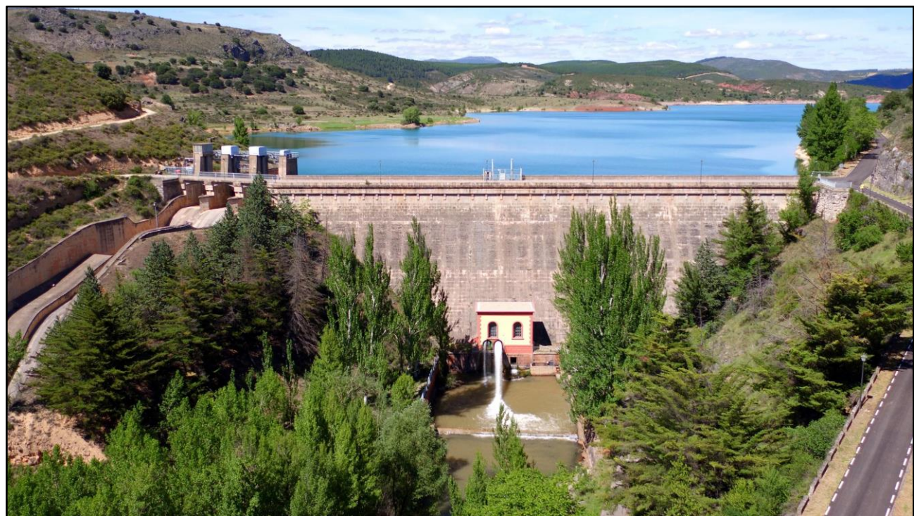
Presa de Pálmaces
