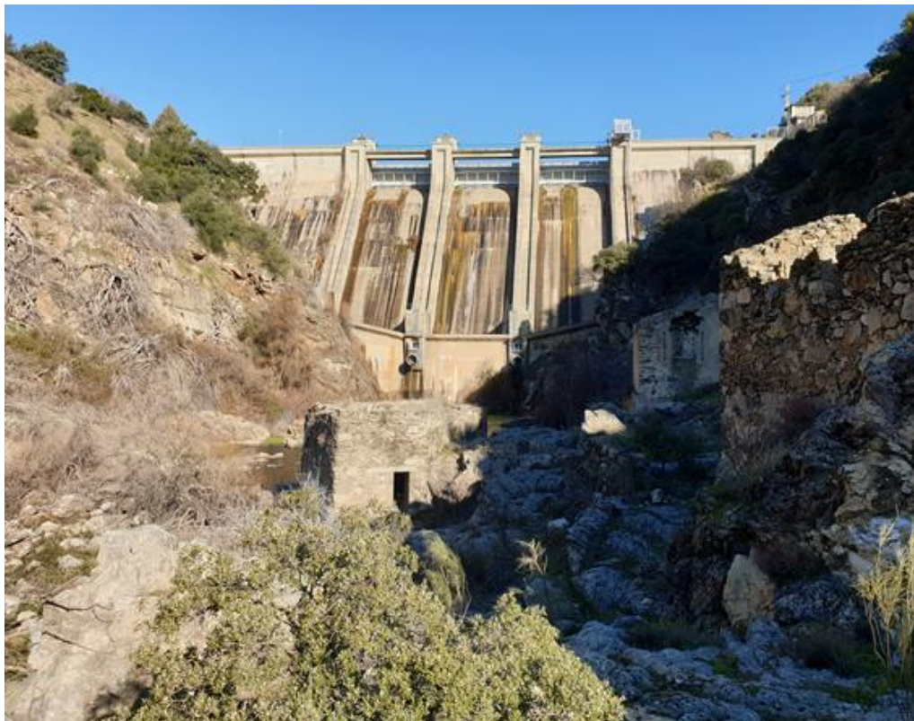
Presa de Picadas
