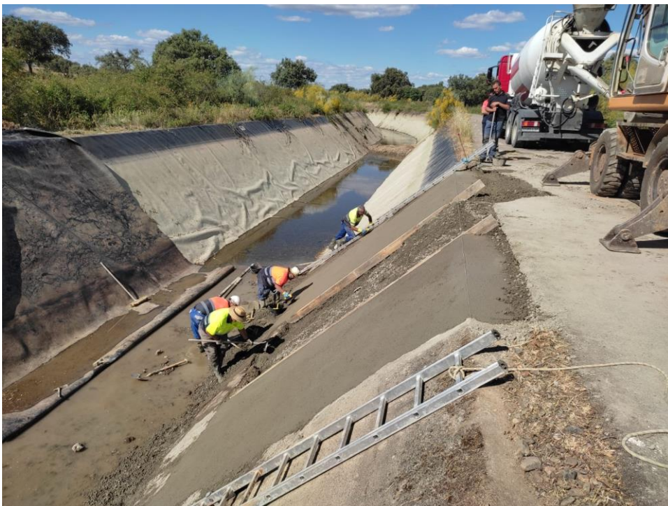
Trabajos de gunitado en el Canal Principal
