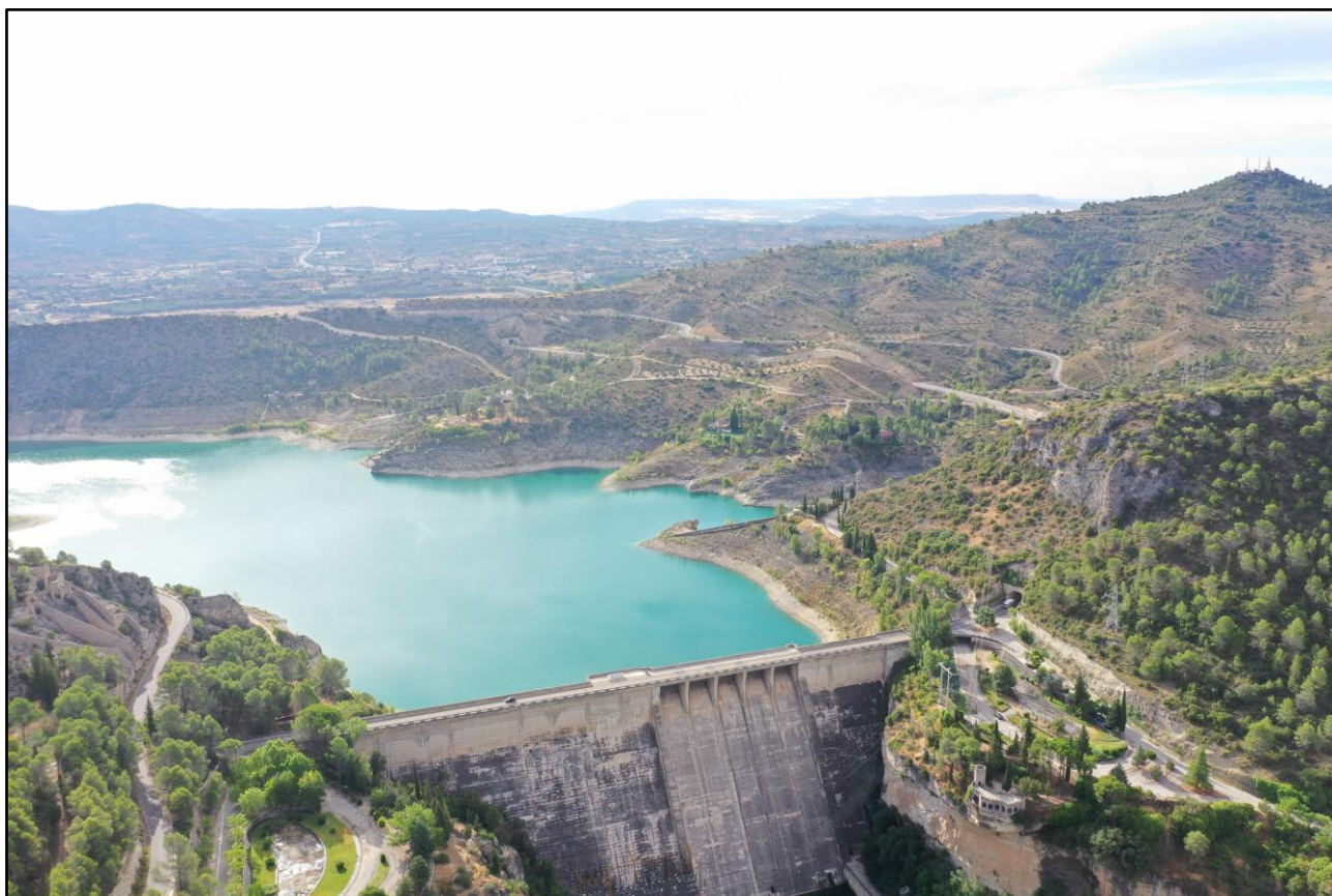
Presa de Entrepeñas
