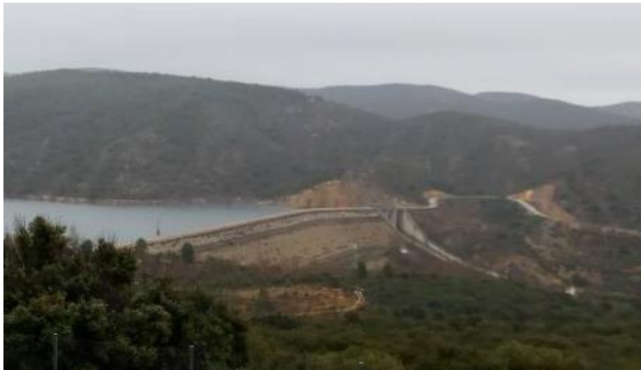
Presa de Beleña
