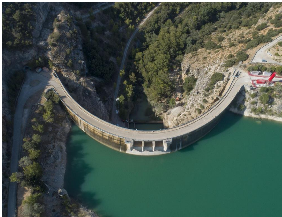
Presa de La Tajera
