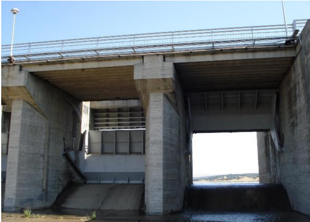
Aliviadero Pesa del Pardo
