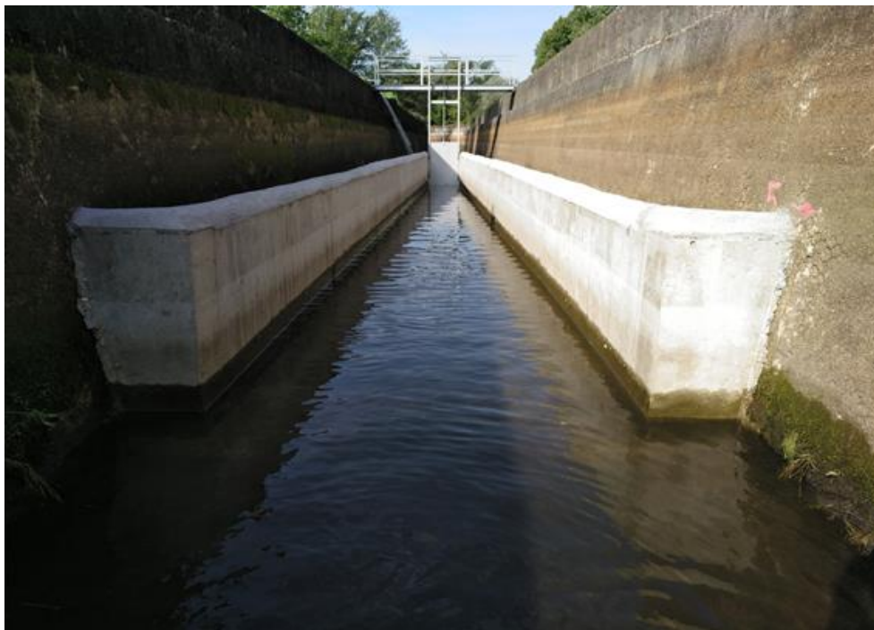
Vertedero “pico de pato” ejecutado en el canal de la margen derecha de Rosarito
