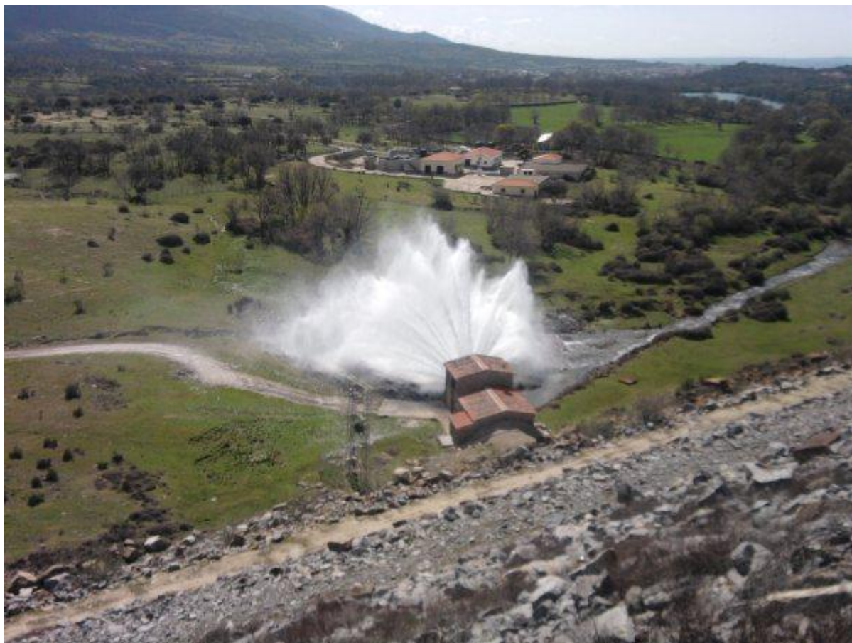
Presa de Baños – Desagües de fondo
