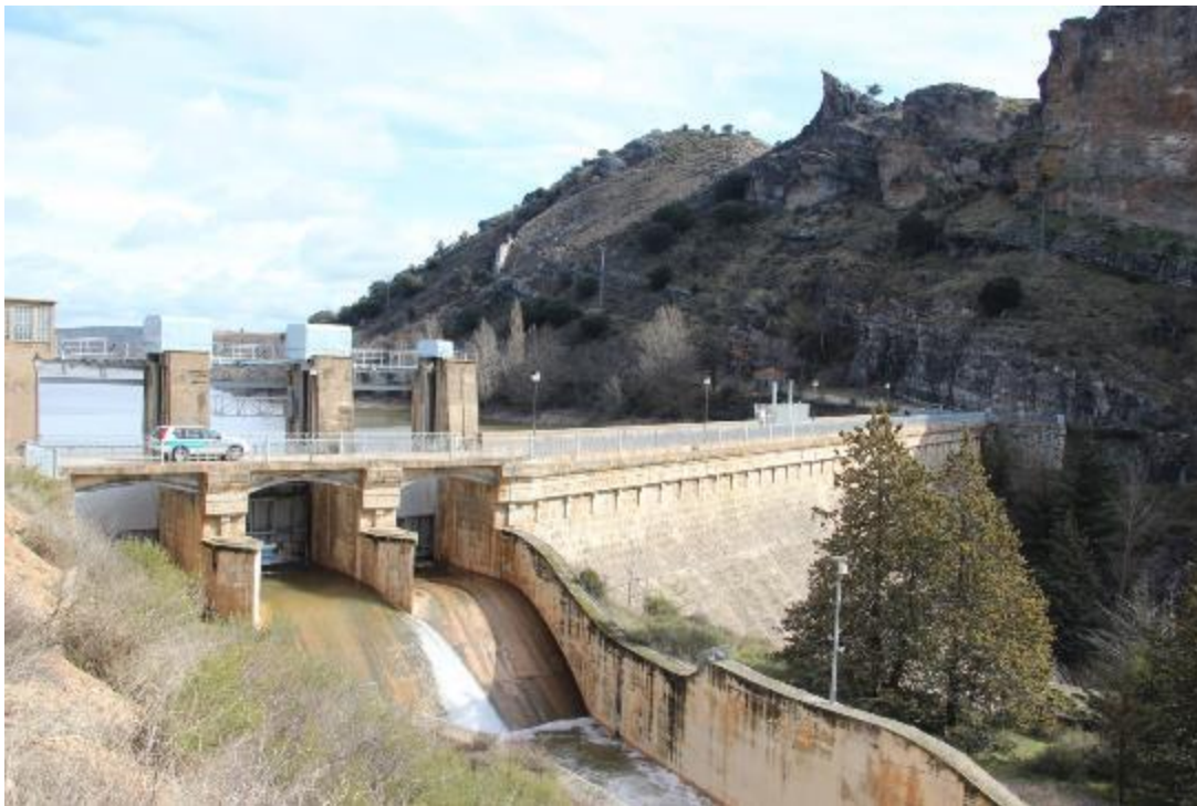
Presa de Pálmaces
