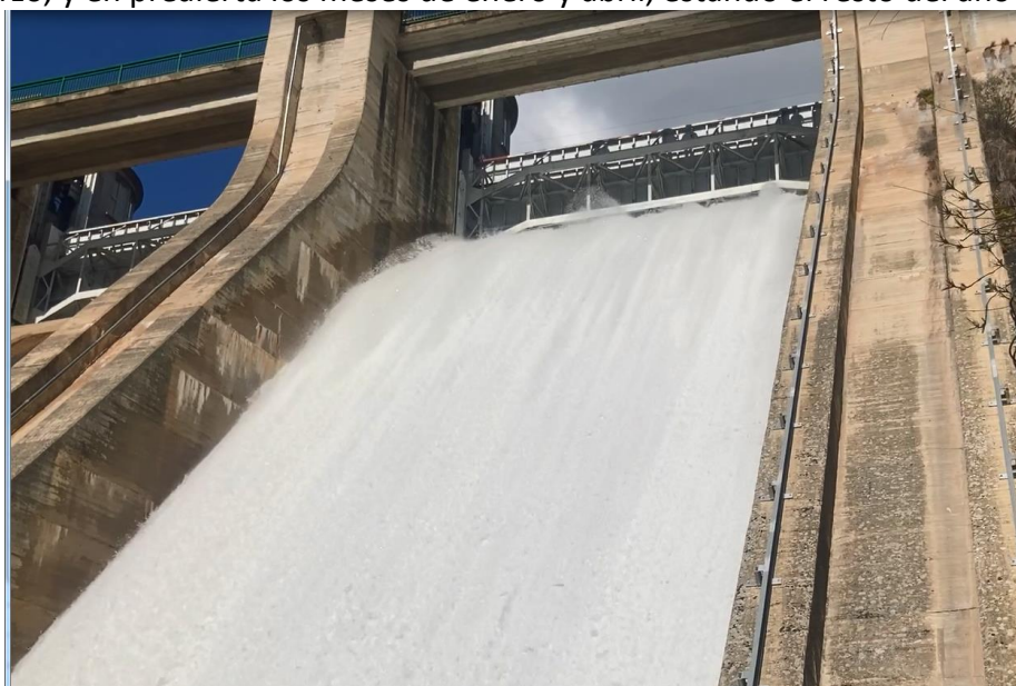
Vertido por aliviadero en la presa de Picadas
