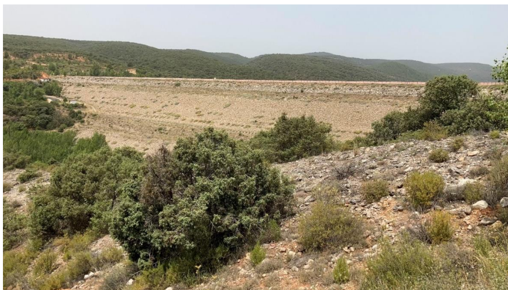
Presa de Beleña
