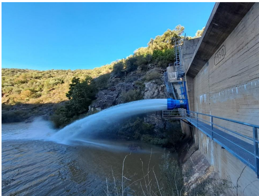
Vertido por desagüe de fondo en la presa de Picadas
