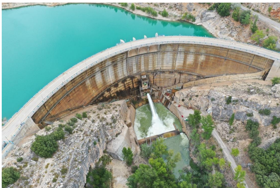
Presa de La Tajera
