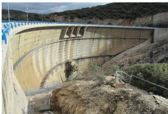
Presa de La Tajera
