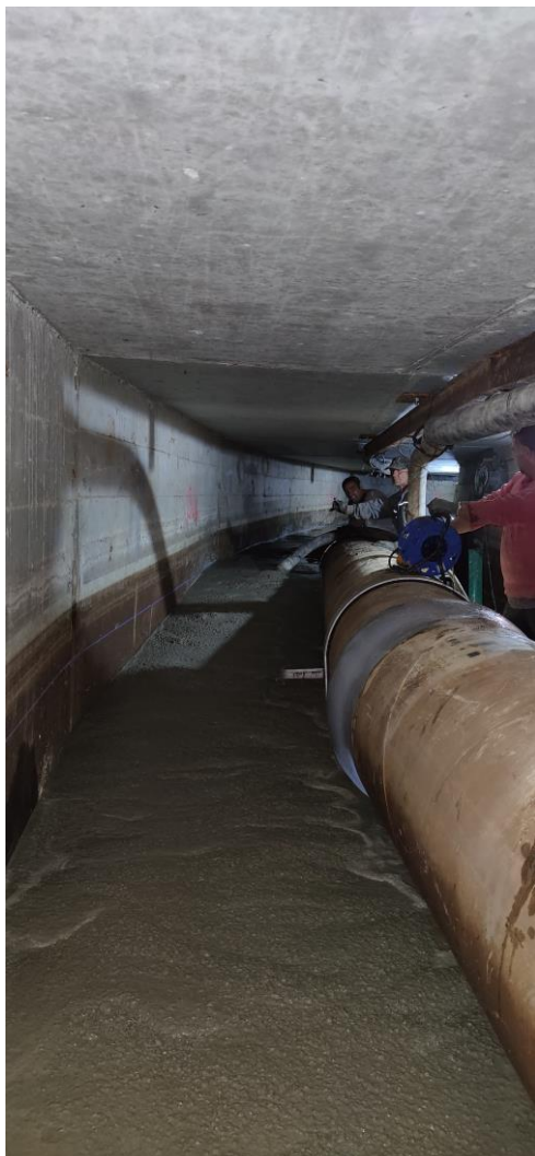
Ejecución del nuevo anclaje de hormigón de la tubería de acero en la galería II bajo A-5
