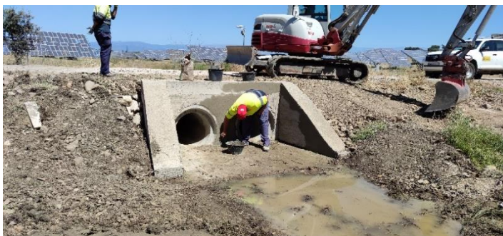
Ejecución del nuevo drenaje transversal bajo el canal principal en su PK. 5+000
