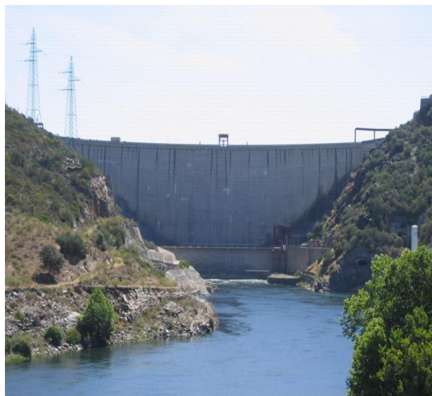
Presa de Valdecañas
