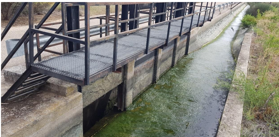
Compuertas de desagüe final del canal de la Z.R. Castrejón Margen Izquierda.
