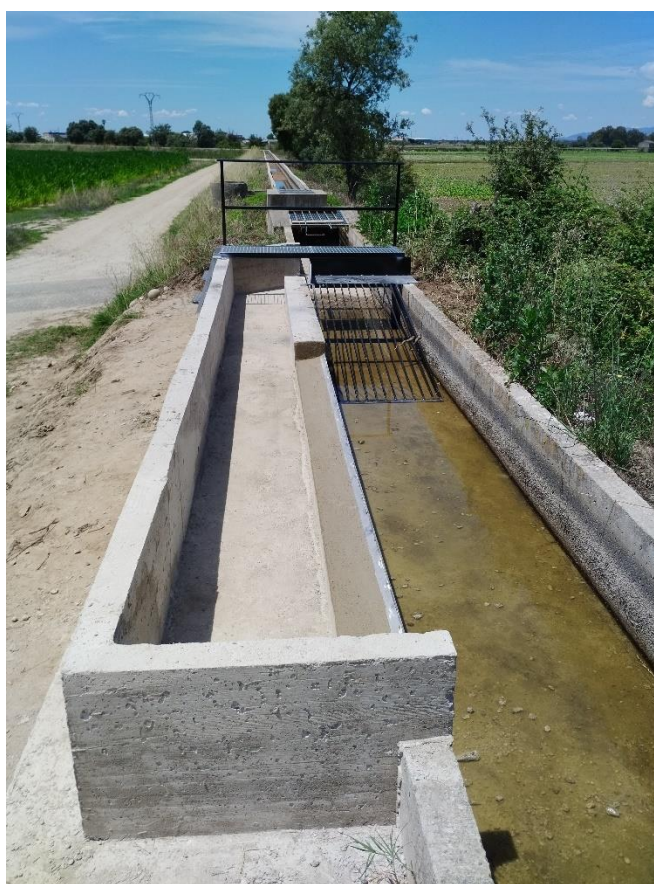
Ejecución de "by-pass" en acequia de la margen izquierda
