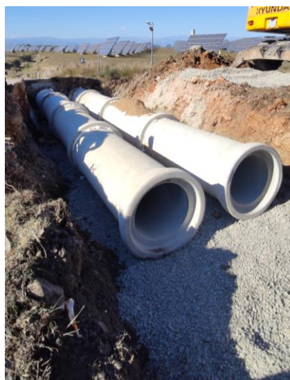
Ejecución del nuevo drenaje transversal bajo el canal principal en su PK. 5+000
