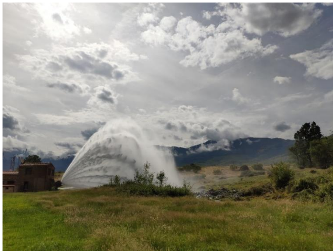
Presa de Baños – Desagües de fondo
