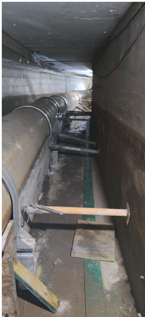
Ejecución del nuevo anclaje de hormigón de la tubería de acero en la galería II bajo A-5
