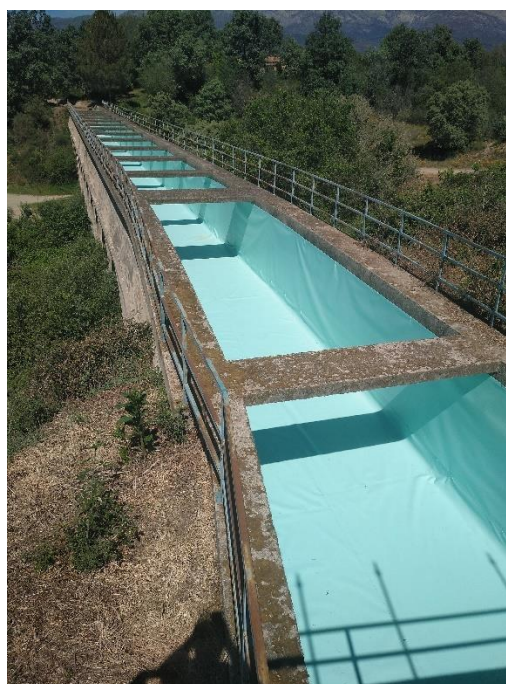
Ejecución de lámina TPO en acueducto
