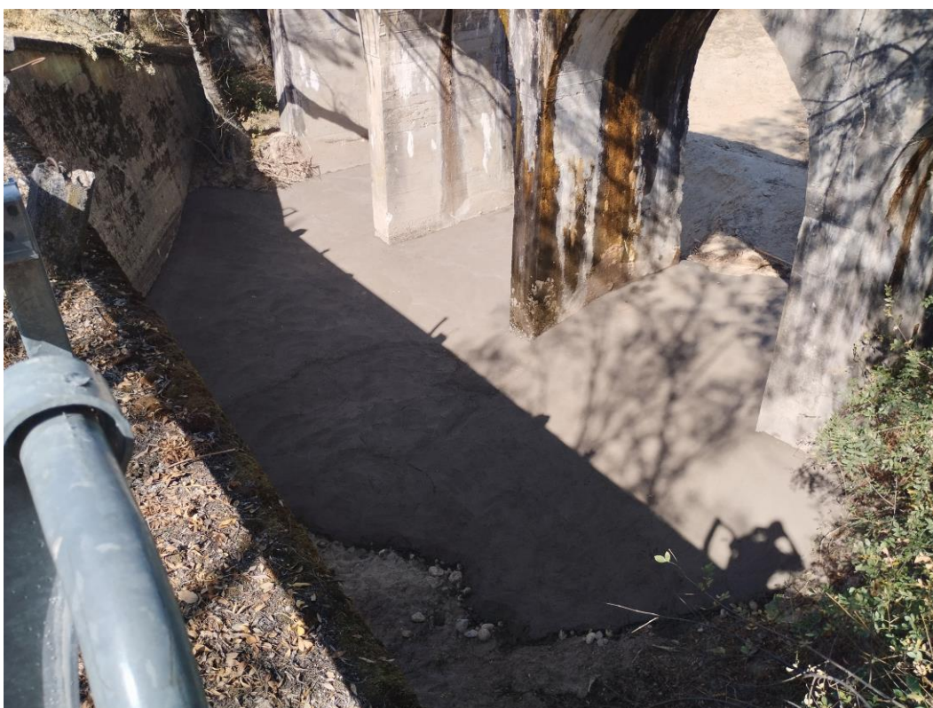
Protección y rehabilitación de la cimentación de un acueducto en la margen izquierda de Rosario
