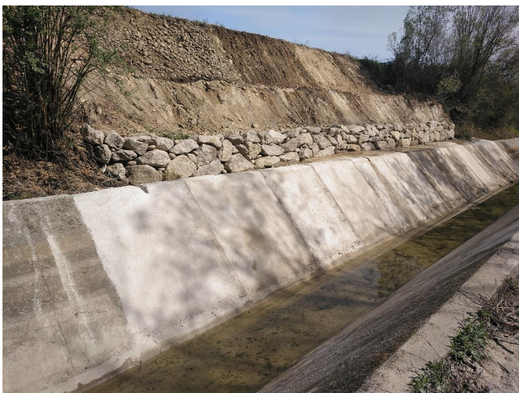
Tramo de canal reparado tras derrumbamiento del talud, que también se repara y protege
