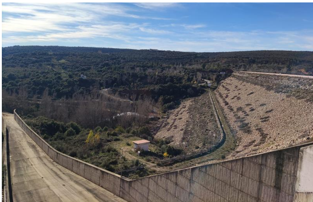
Presa de Beleña
