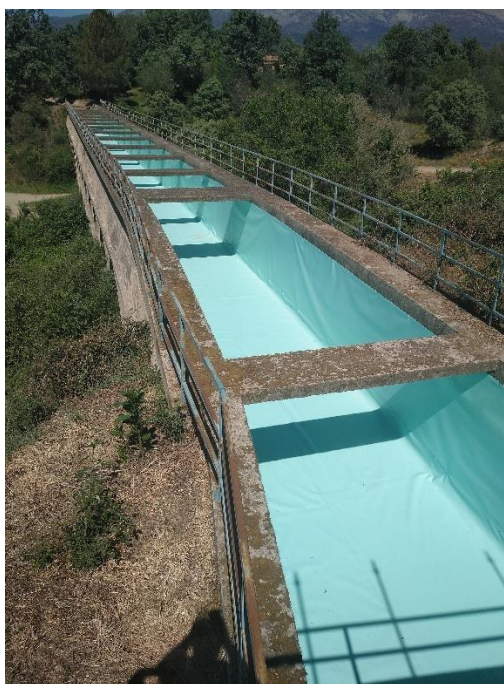
Ejecución de lámina TPO en acueducto
