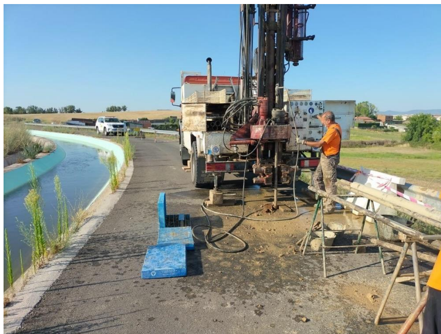
Estudio geotécnico del camino de servicio del Canal II-B
