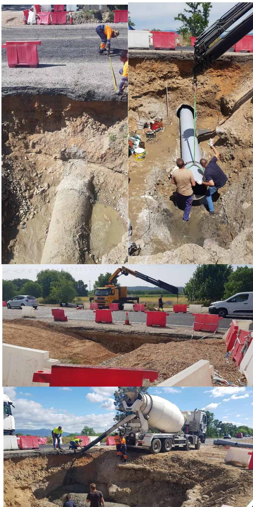
Sustitución de la tubería del sifón de la acequia A-2 en su cruce con la carretera N-V.
