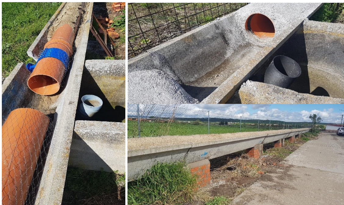
Entubado de la acequia A-19 Zona Regable de Azután
