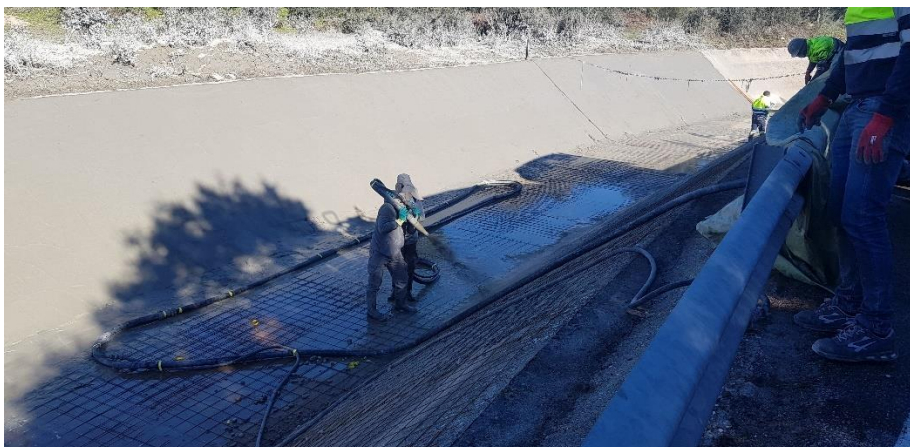
Proyectado de mortero en el Canal Bajo del Alberche.
