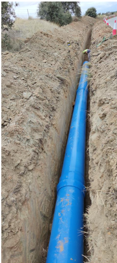
Ejecución de los nuevos tramos de tubería de la zona regable de Valdecañas
