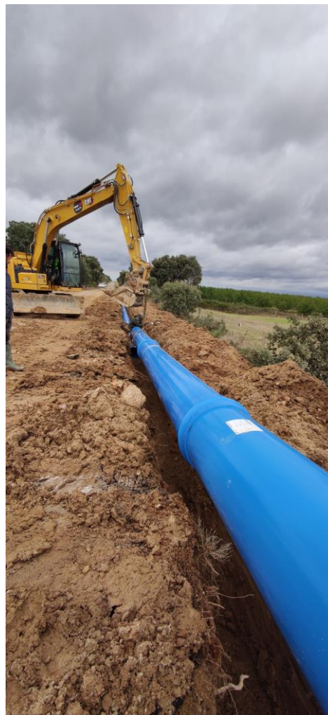
Ejecución de los nuevos tramos de tubería de la zona regable de Valdecañas
