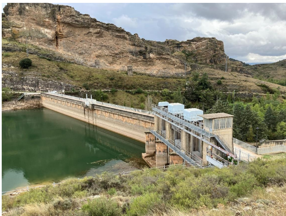
Presa de Pálmaces
