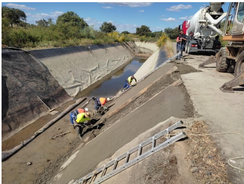
Gunitados en los canales del Alagón
