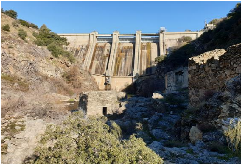
Presa de Picadas
