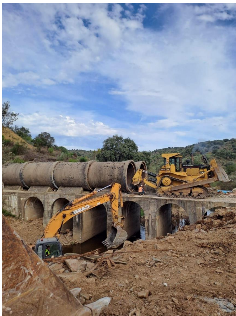
Obras de emergencia en el sifón del Bronco
