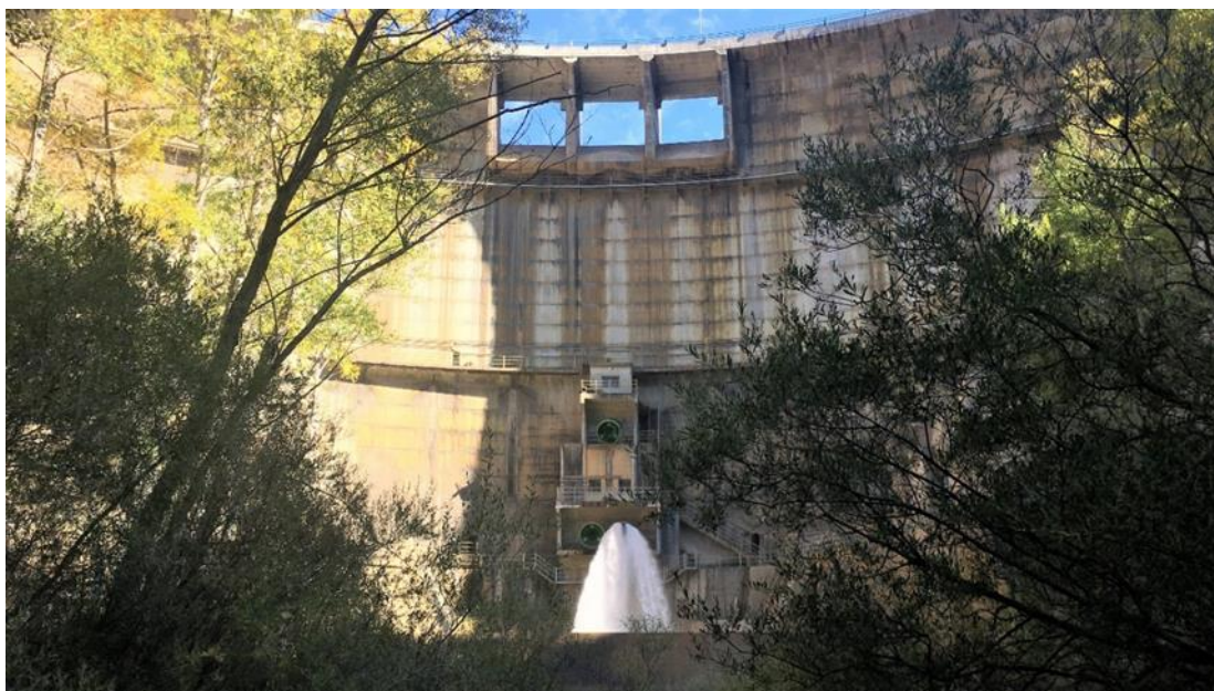
Presa de La Tajera
