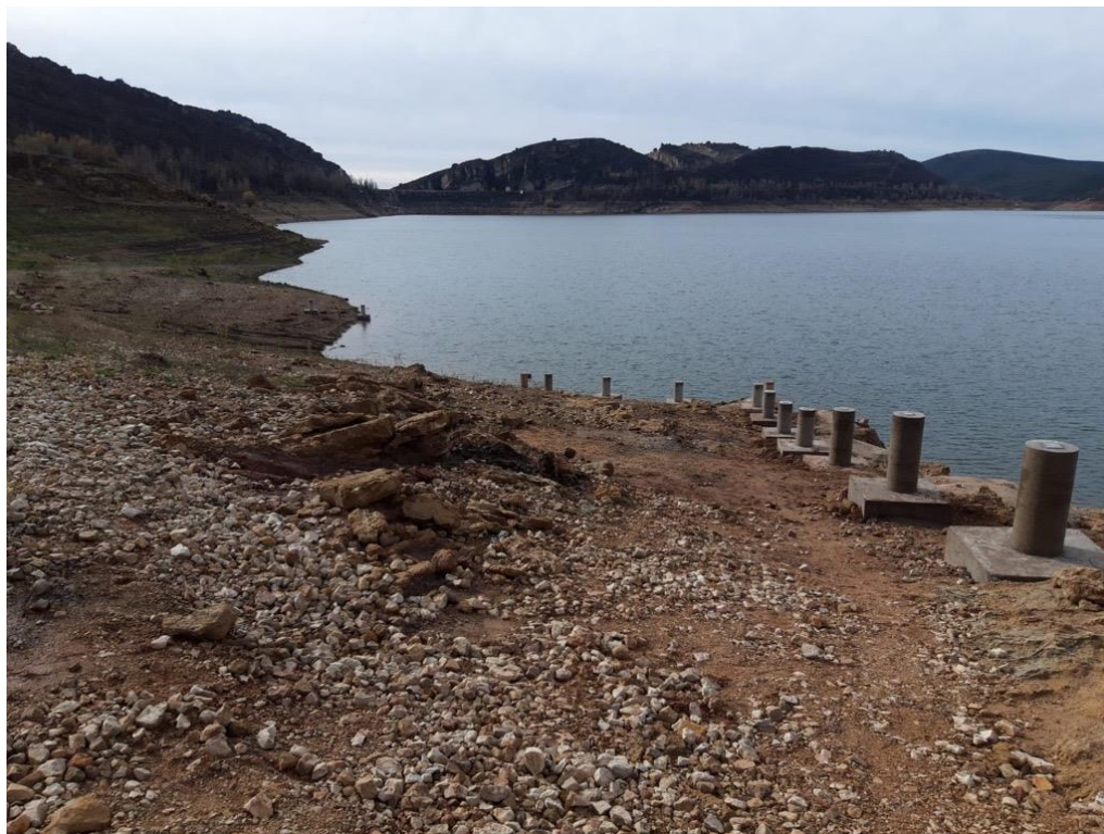
Renovación de hitos para medición del nivel del embalse de Alcorlo
