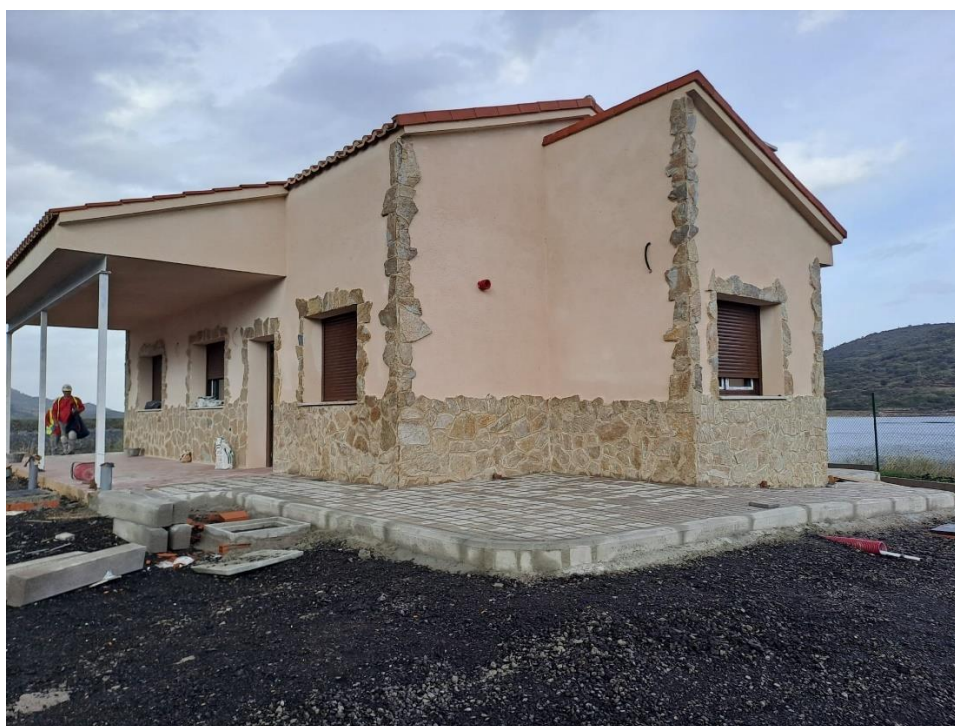
Construcción de nueva oficina de explotación y sala de emergencia de la presa de Baños
