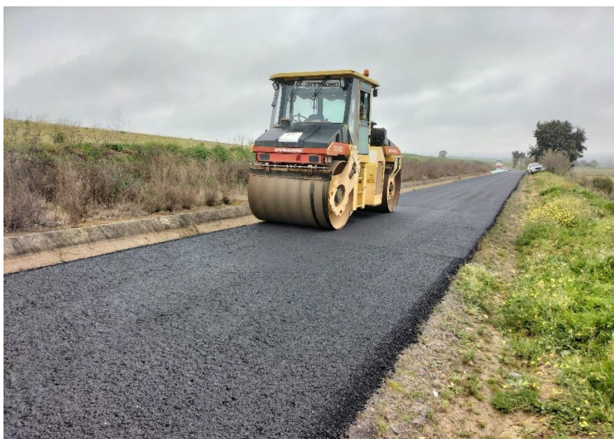
Obra de los caminos IA, IB y IIIB en la zona regable del Árrago
