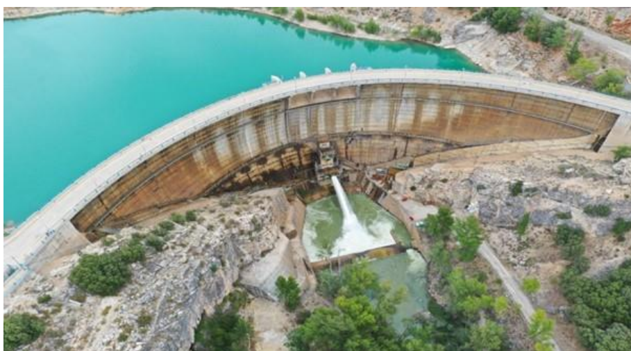
Presa de La Tajera
