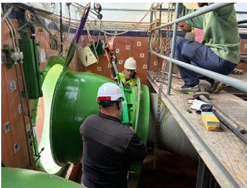
Reparación válvula chorro hueco en Pálmaces
