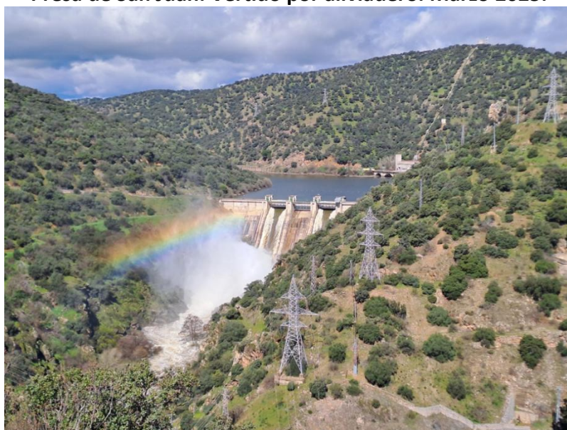
Presa de Picadas. Vertido por aliviadero. Marzo 2025.
