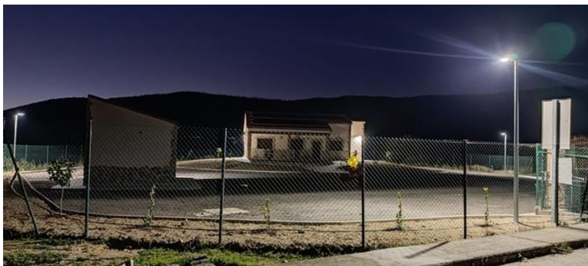
Nueva oficina de explotación y sala de emergencia de la presa de Baños
