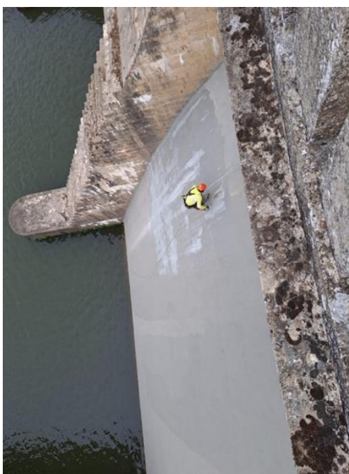
Trabajos de reparación de los aliviaderos de la presa de Borbollón realizados con el mantenimiento.
