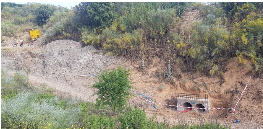
Construcción de colector para canalización de aliviadero en el canal de ZR Castrejón m izq.
