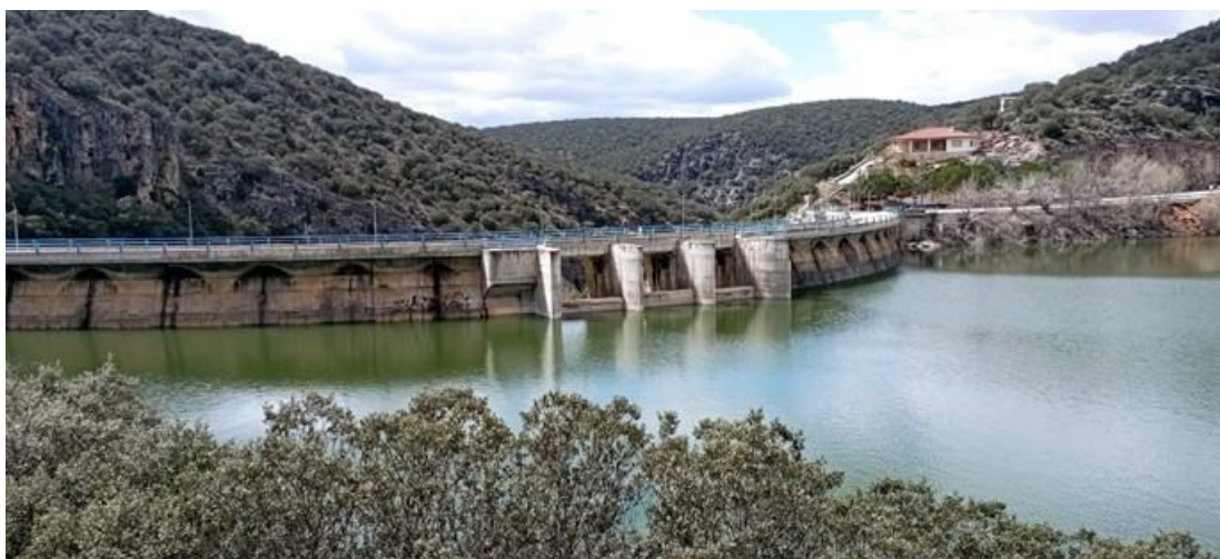
Presa de La Tajera
