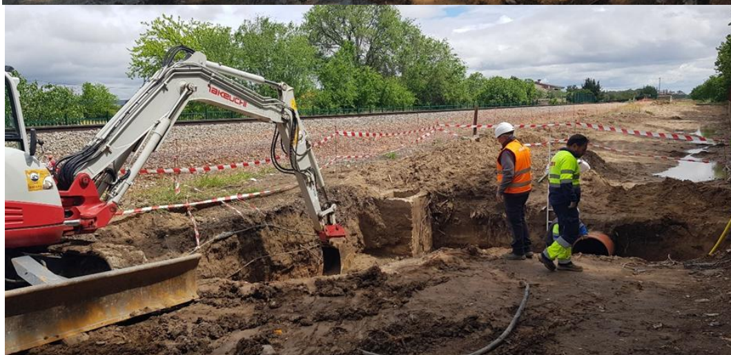
Sustitución de la tubería del desagüe D-4 Sector V paralelo a ff.cc. de ZR Alberche.
