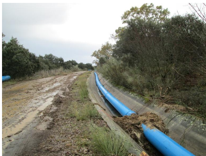
Prolongación del entubado del canal principal de ZR Azután en su primer tramo desde presa.
