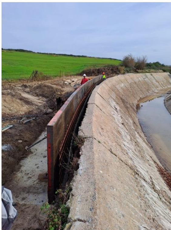
Trabajos de mantenimiento de caños en los canales del Alagón
