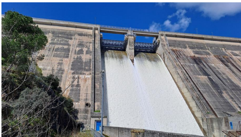
Presa de San Juan. Vertido por aliviadero. Marzo 2025.
