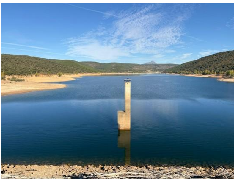
Presa de Beleña
