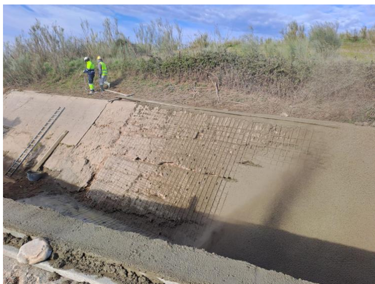
Gunitados en los canales del Alagón
