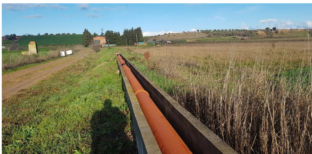
Entubado de la acequia 6 del Sector XI de ZR Alberche.
