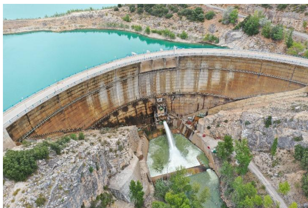
Presa de La Tajera
