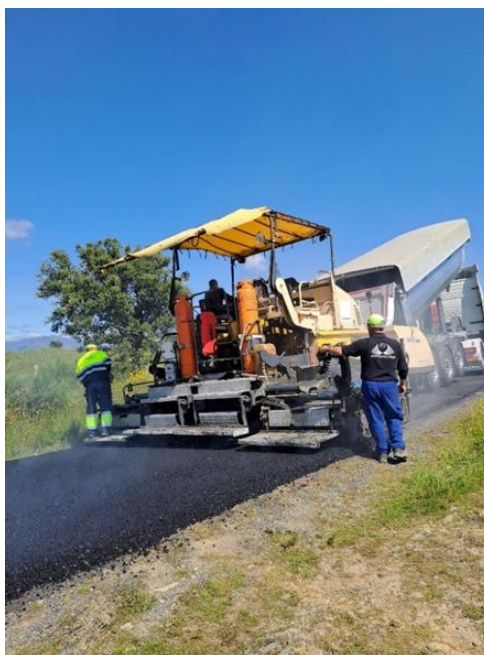
Trabajos de reparación en los caminos del Árrago realizados con el mantenimiento.
