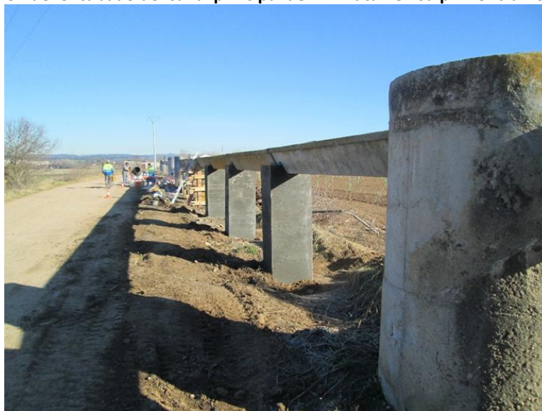
Refuerzo de pilares en la acequia A-15 y canal principal ZR Azután.
