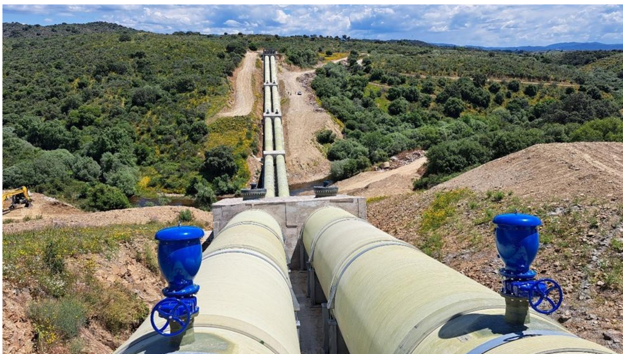
Obras de emergencia en el sifón del Bronco
