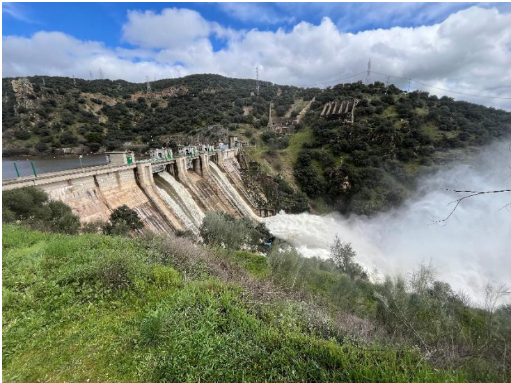
Presa de Picadas
