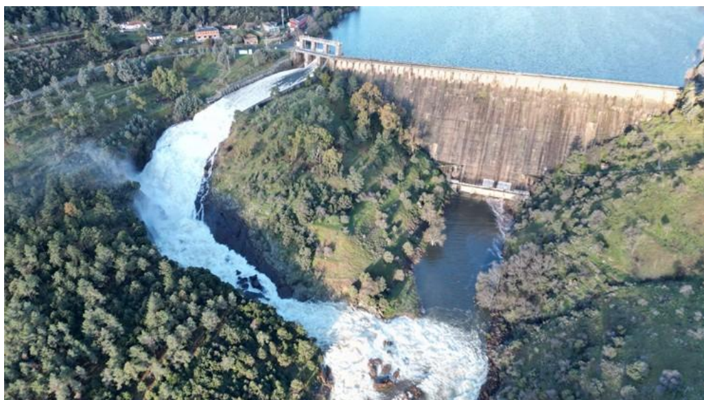
Presa de Burguillo. Vertido por aliviadero. Marzo 2025.
