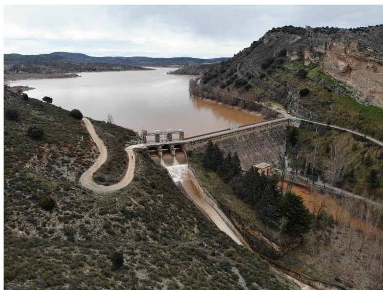
Presa de Pálmaces
