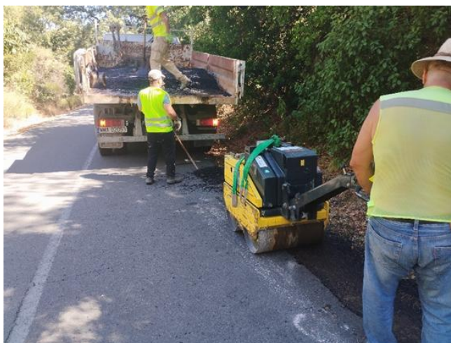
Reparación de caminos de servicio
