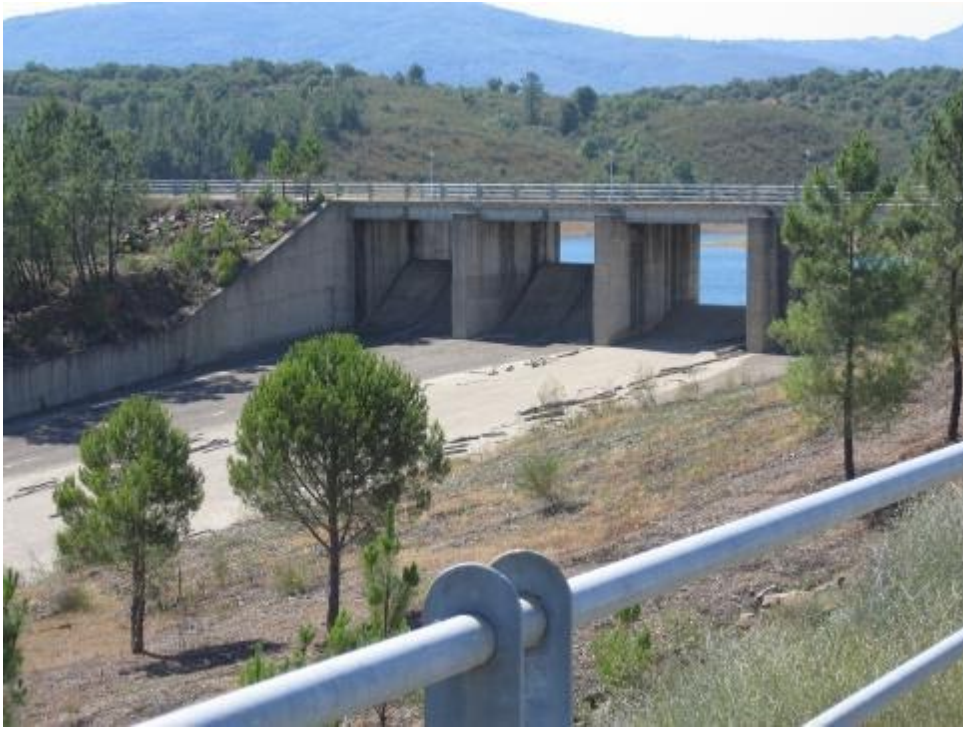
Aliviadero Presa de Rivera de Gata
