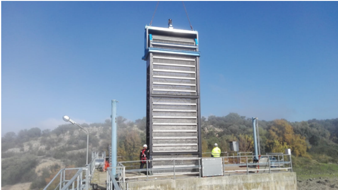
Instalación del filtro de bandas en la Balsa de Alcolea
