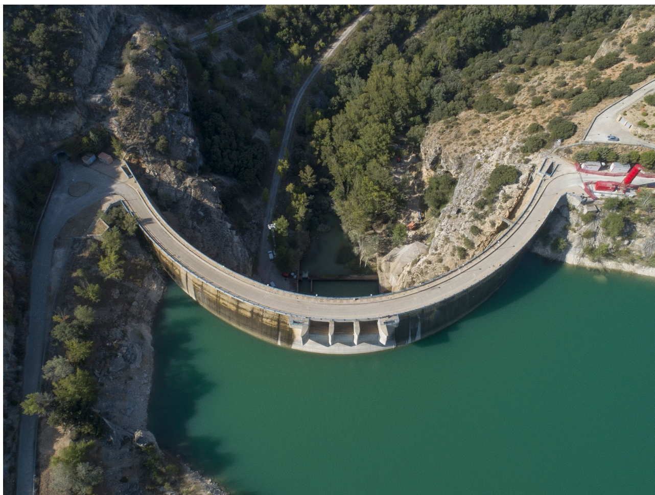
Presa de La Tajera
