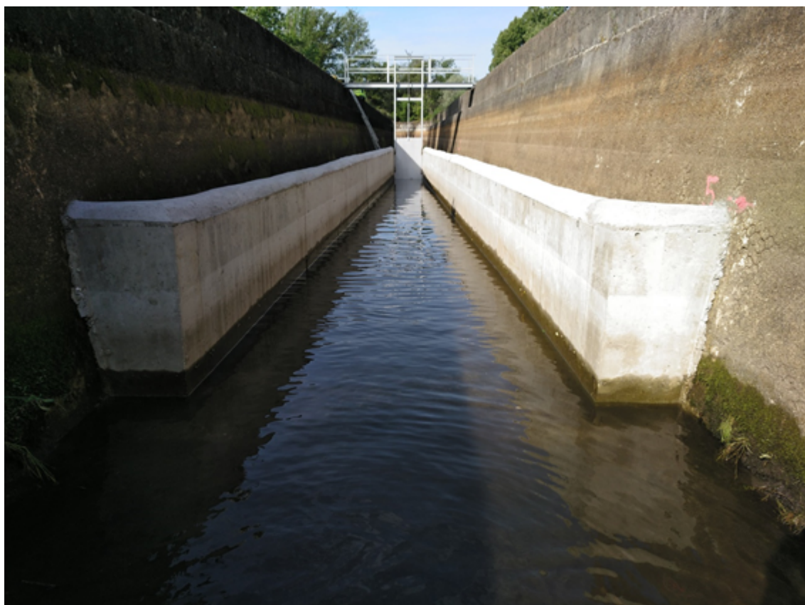
Vertedero “pico de pato” ejecutado en el canal de la margen derecha de Rosarito
