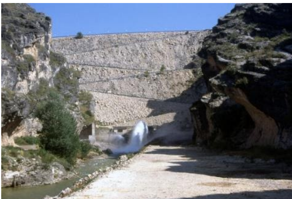
Presa de Alcorlo
