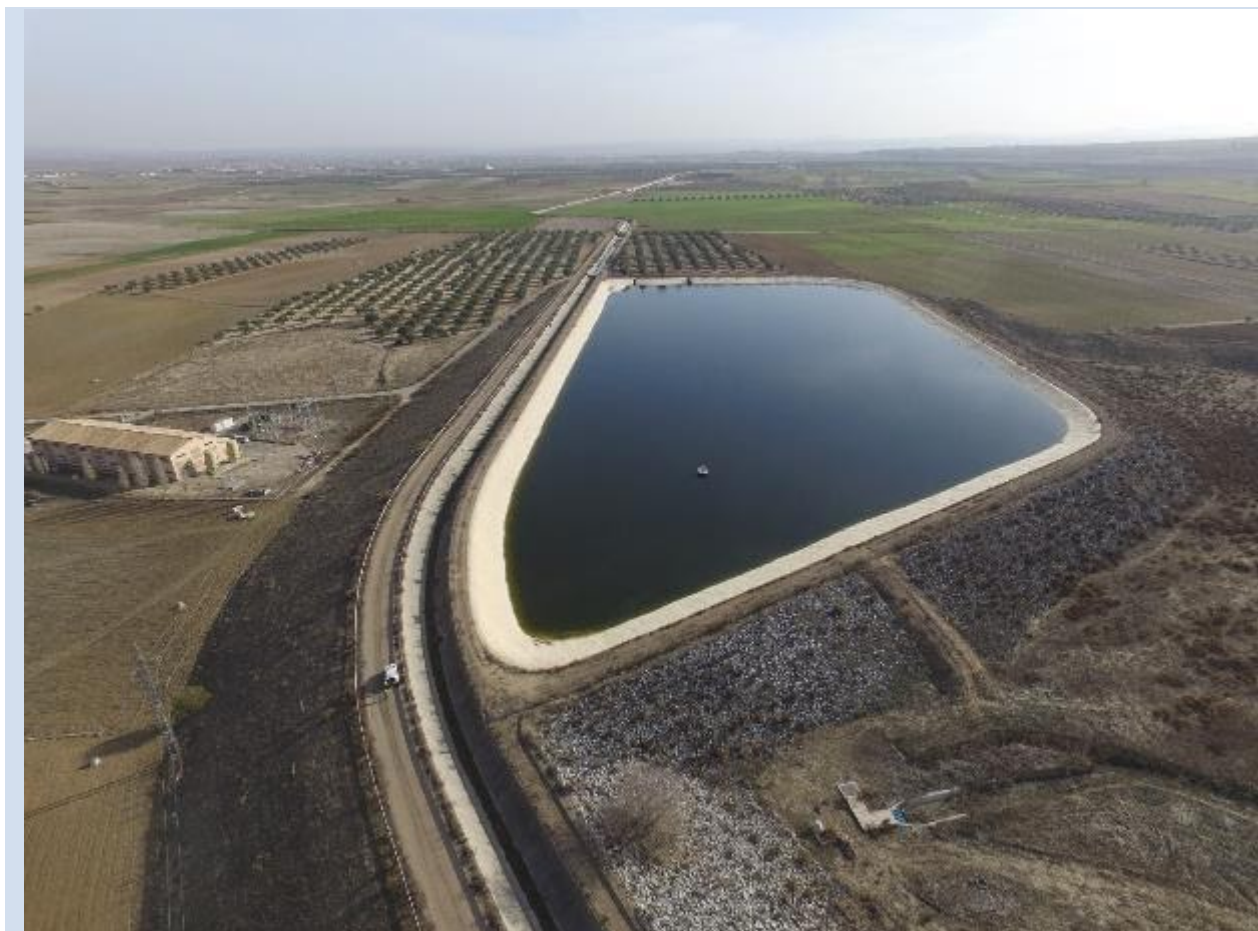
Balsa Sector II-A (balsa de Captación) y Estación de Bombeo
