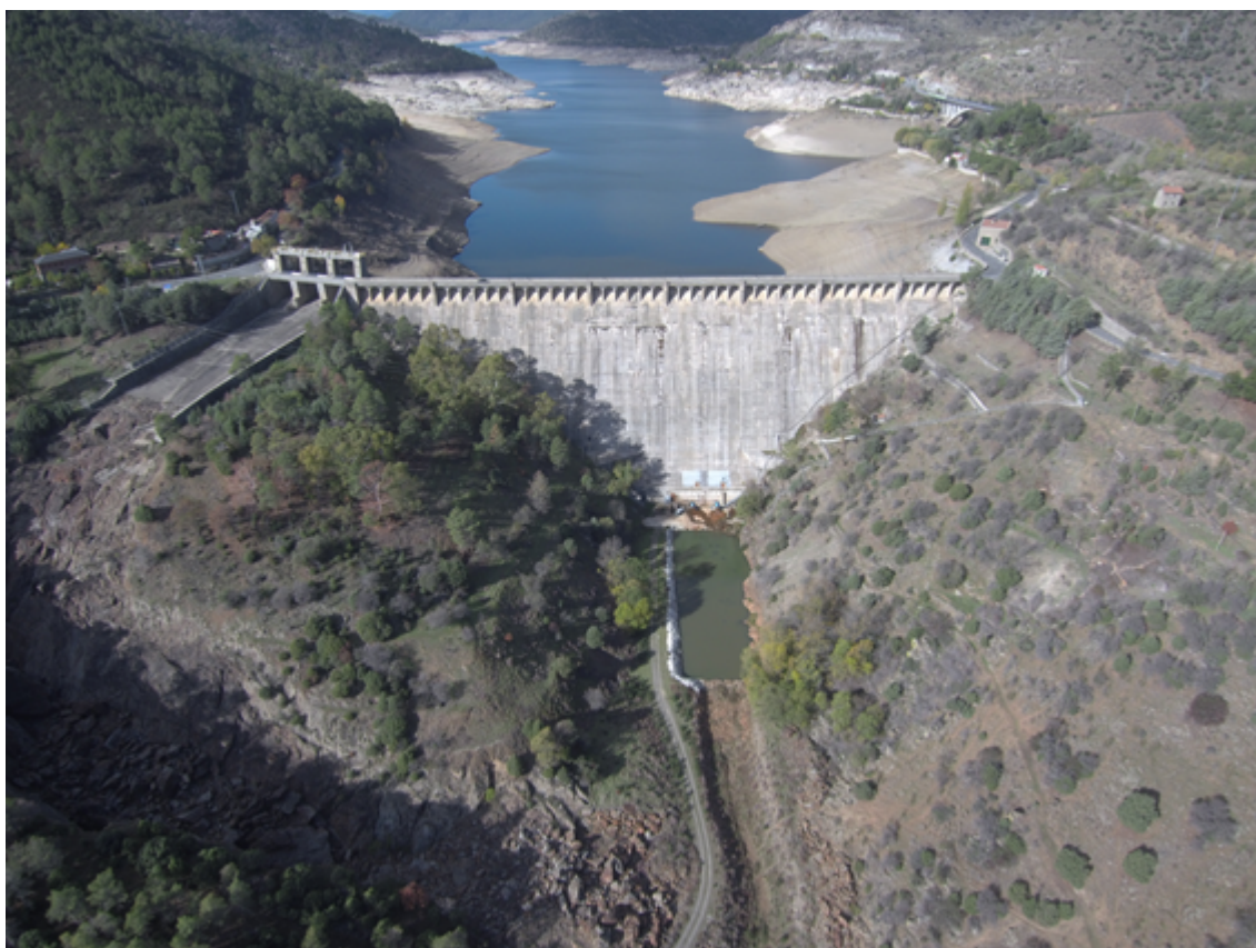
Presa de Burguillo
