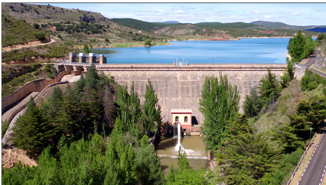
Presa de Palmaces
