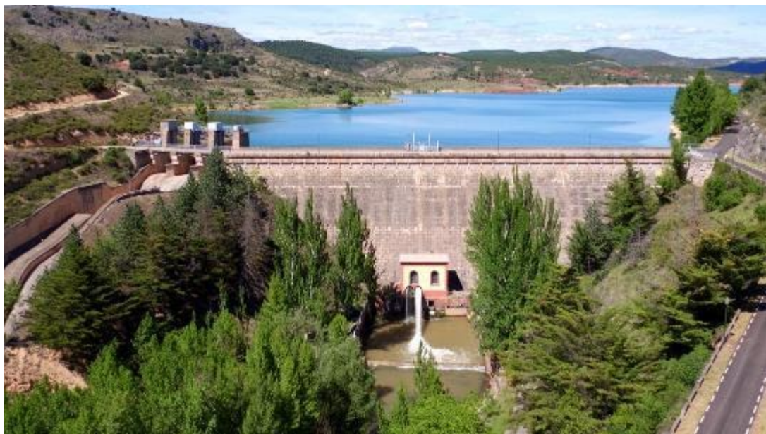
Presa de Pálmaces
