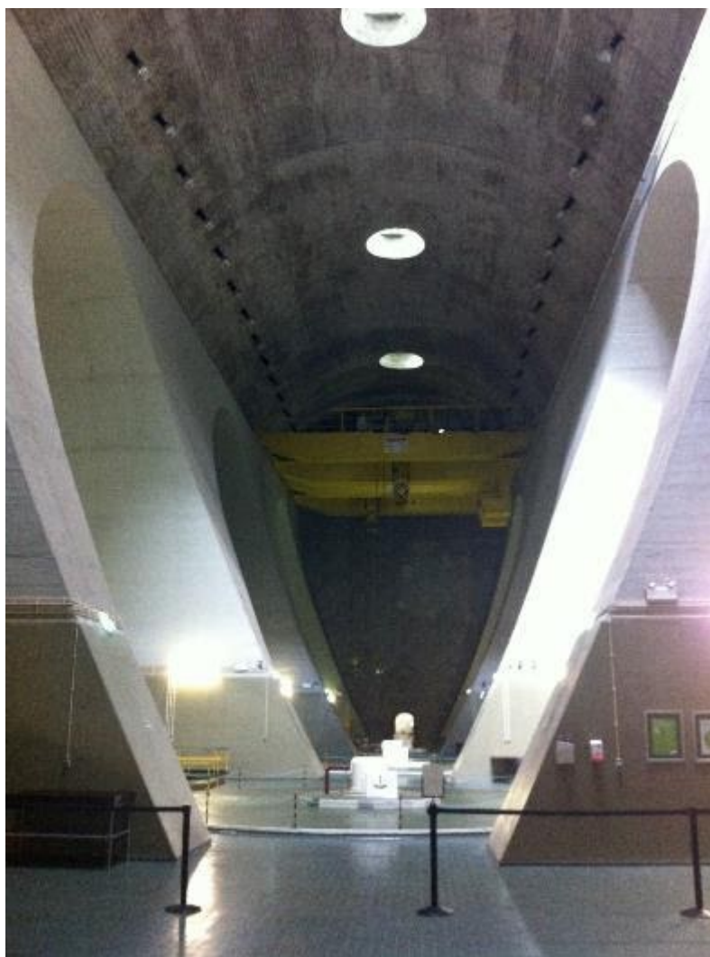
Cámara de turbinas presa de Fratel – Portugal
