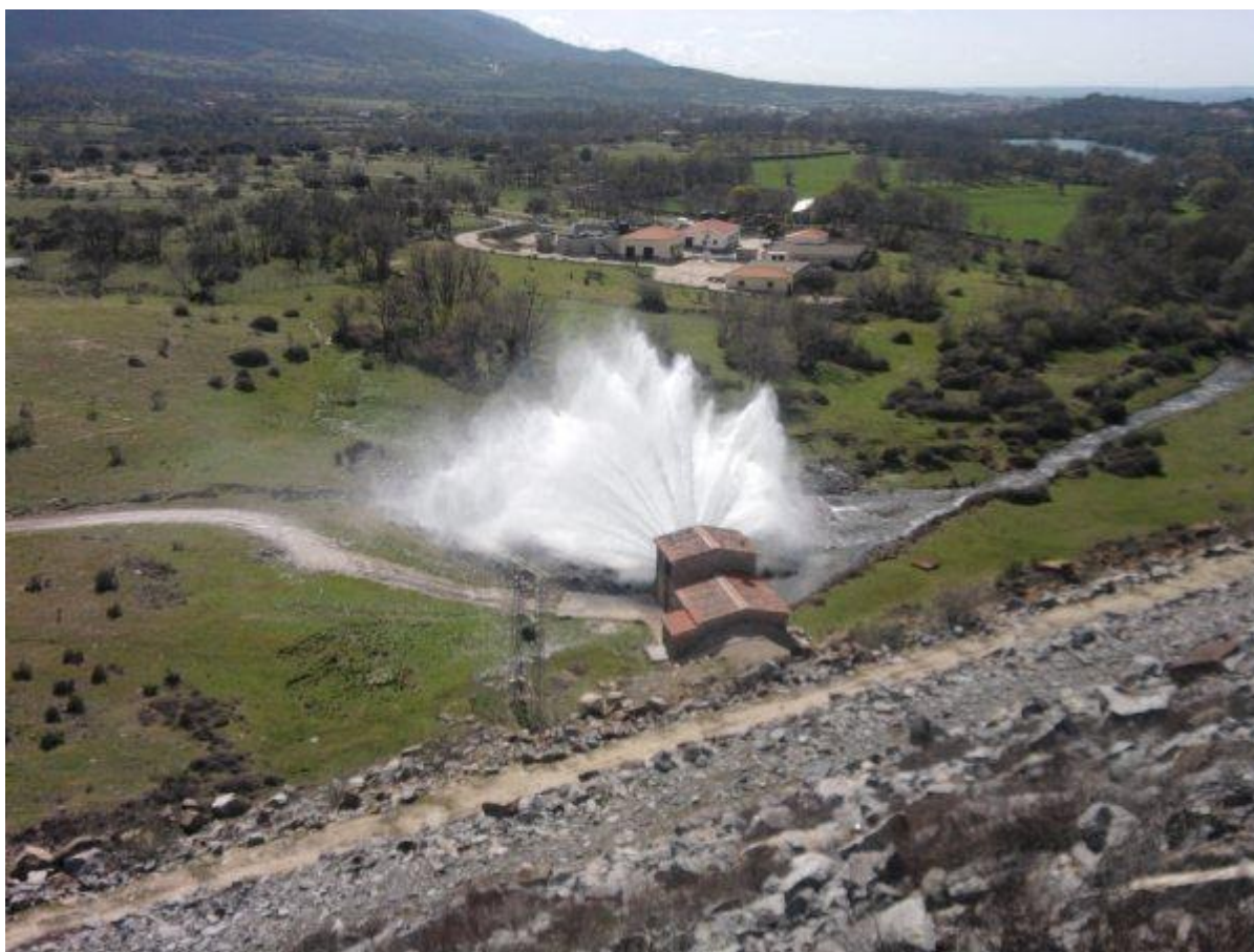
Presa de Baños – Desagües de fondo
