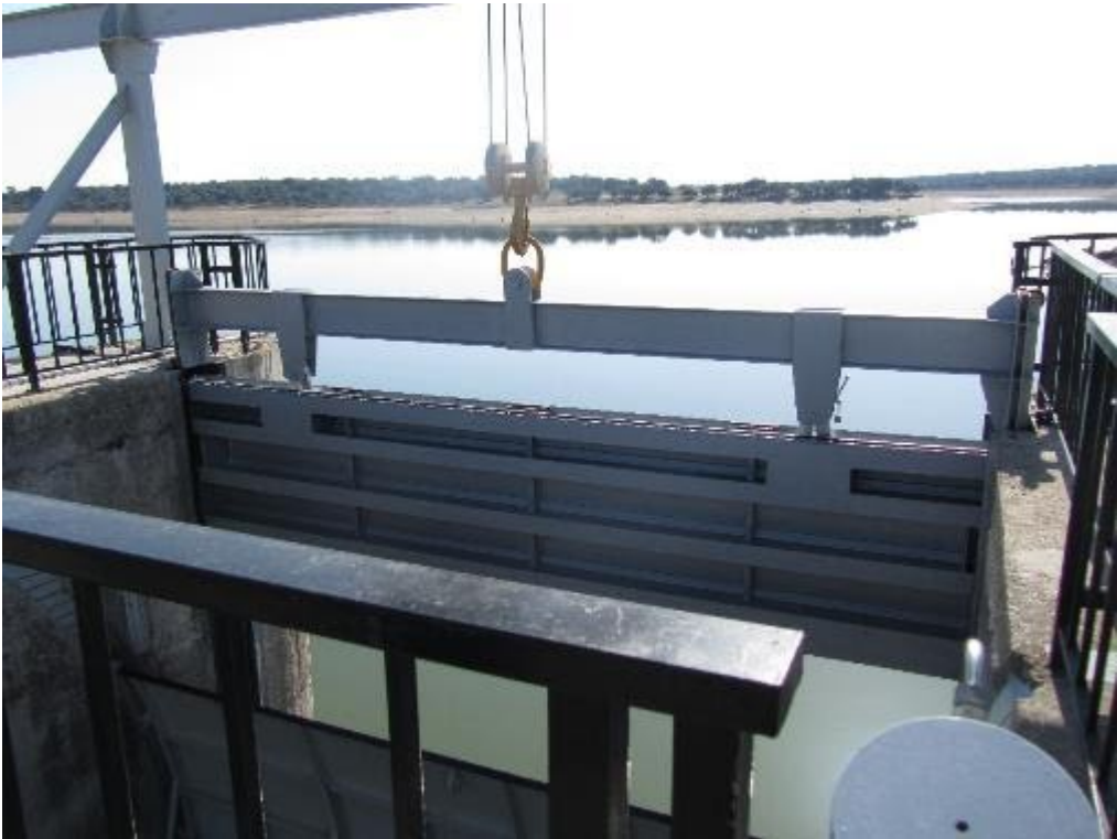
Atagüía aliviadero presa de Navalcán
