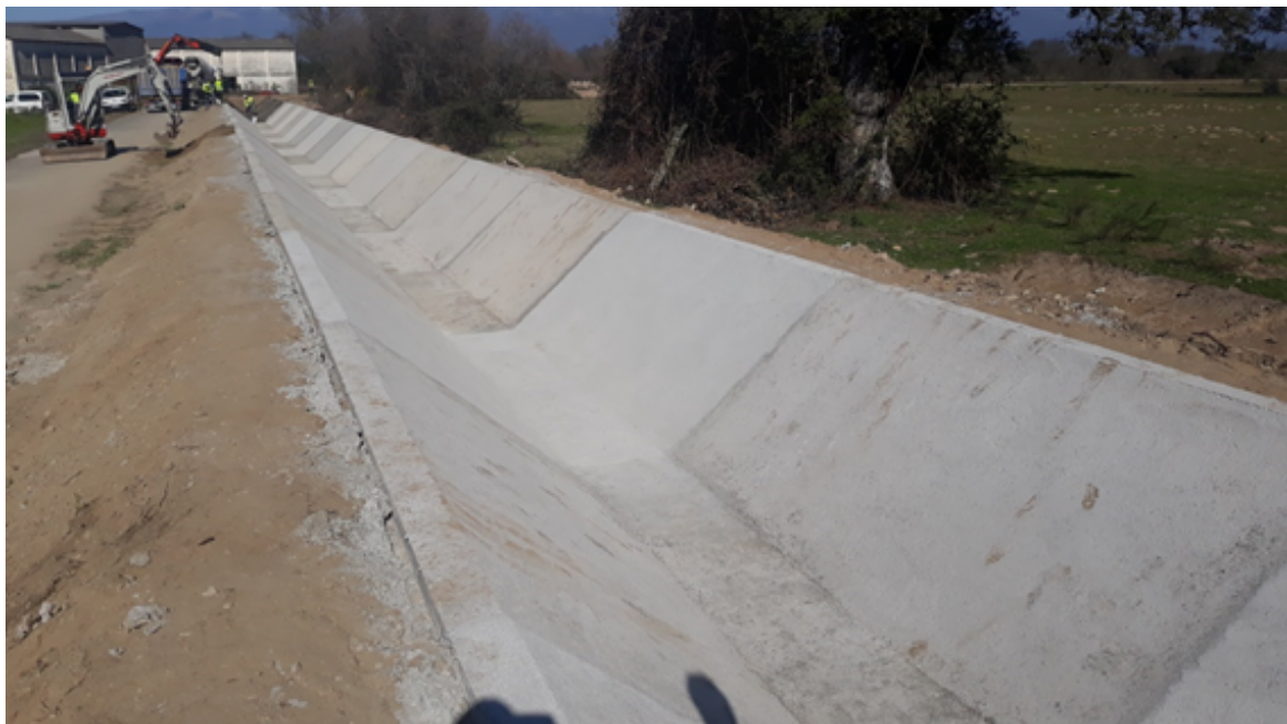
Ejecución de tramos reconstruidos de la Acequia 37 MI
