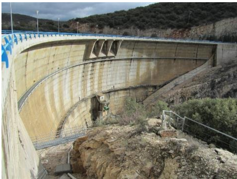
Presa de La Tajera
