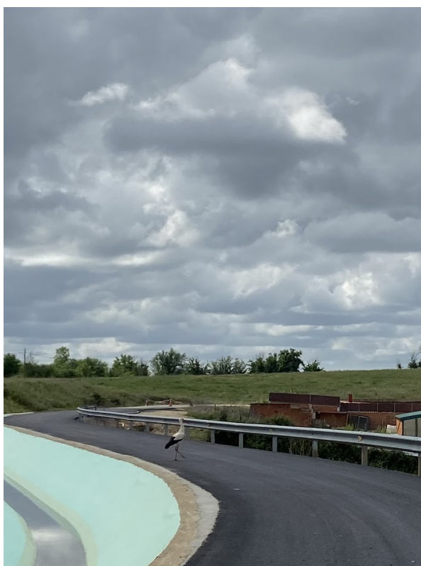
Proyecto de reparación del Canal II-B de la zona regable del Árrago y su camino de servicio
