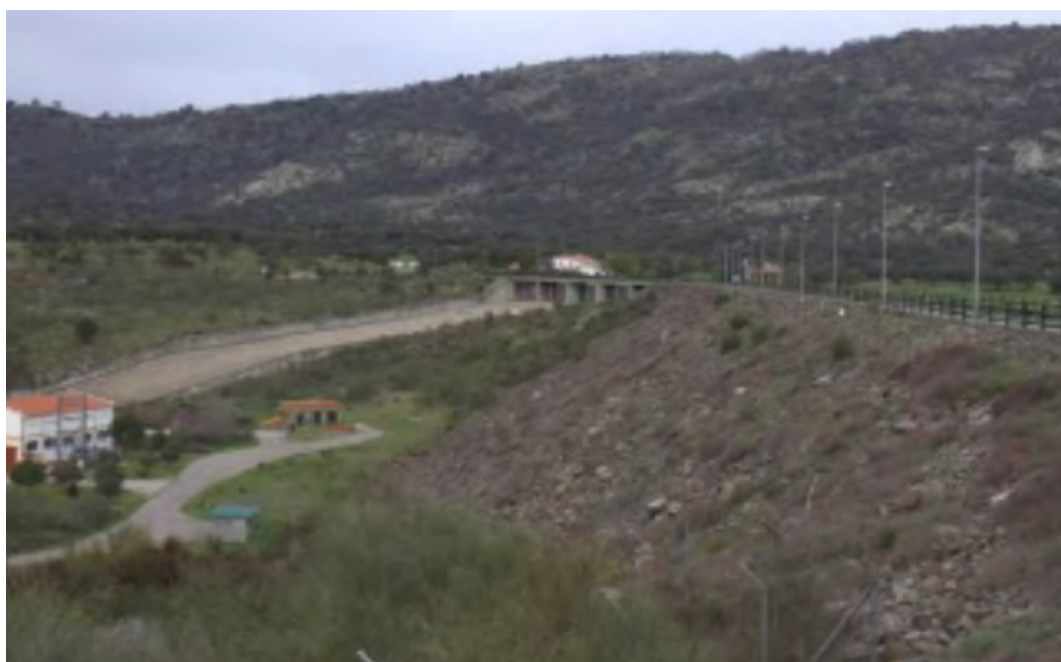
Aliviadero Presa del Jerte
