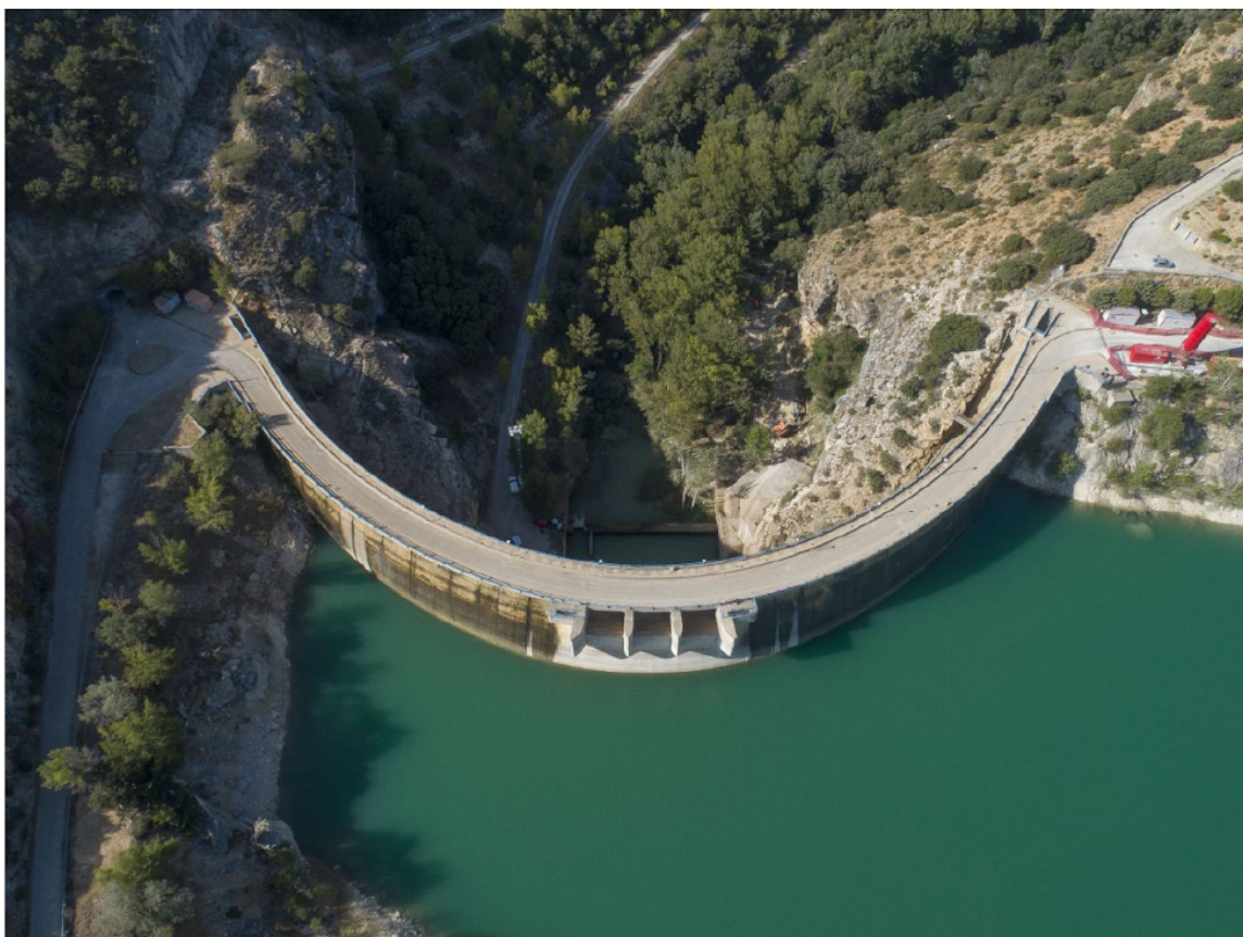
Presa de La Tajera
