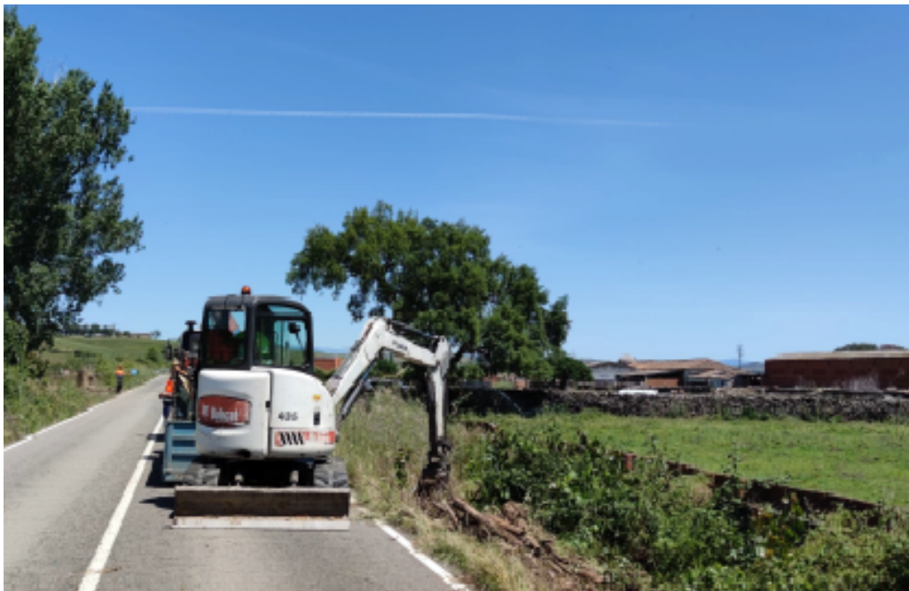
Trabajos de mantenimiento en los caminos de servicio
