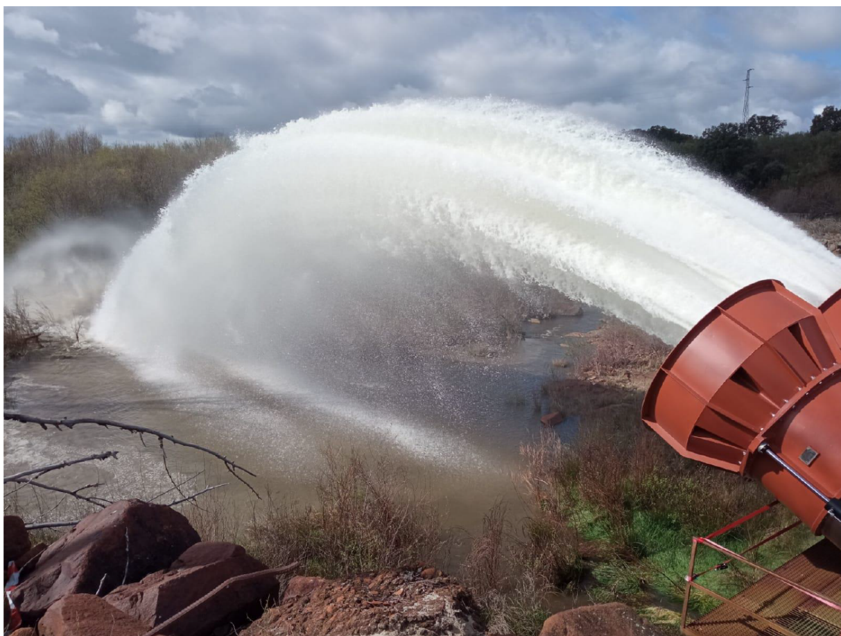
Desagüe de fondo. Presa de Baños
