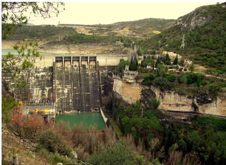
Presa de Entrepeñas
