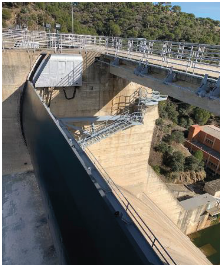
Nuevas compuertas Taintor en la presa de San Juan
