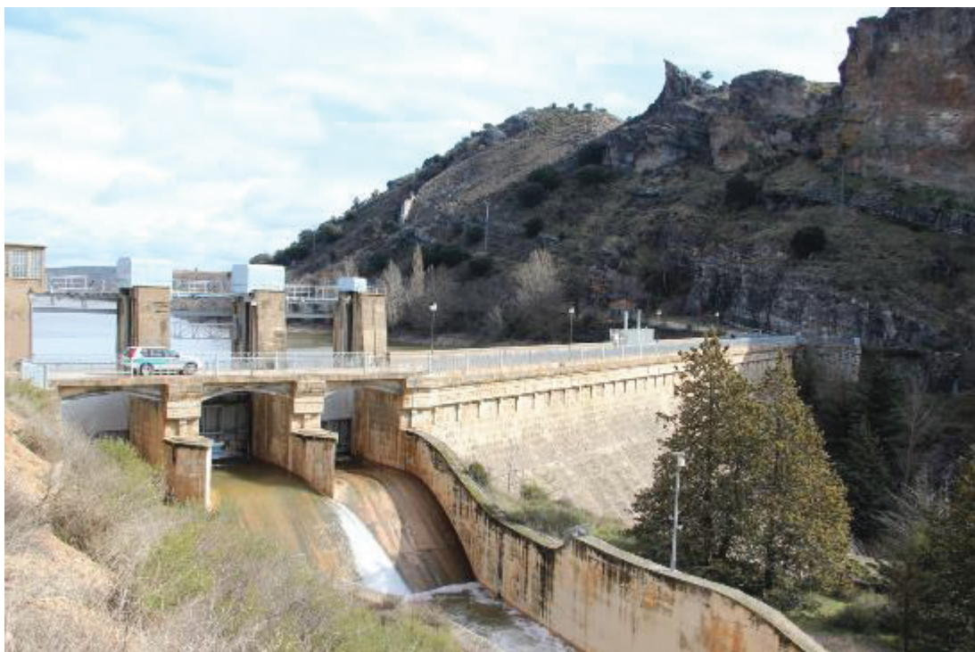
Presa de Pálmaces
