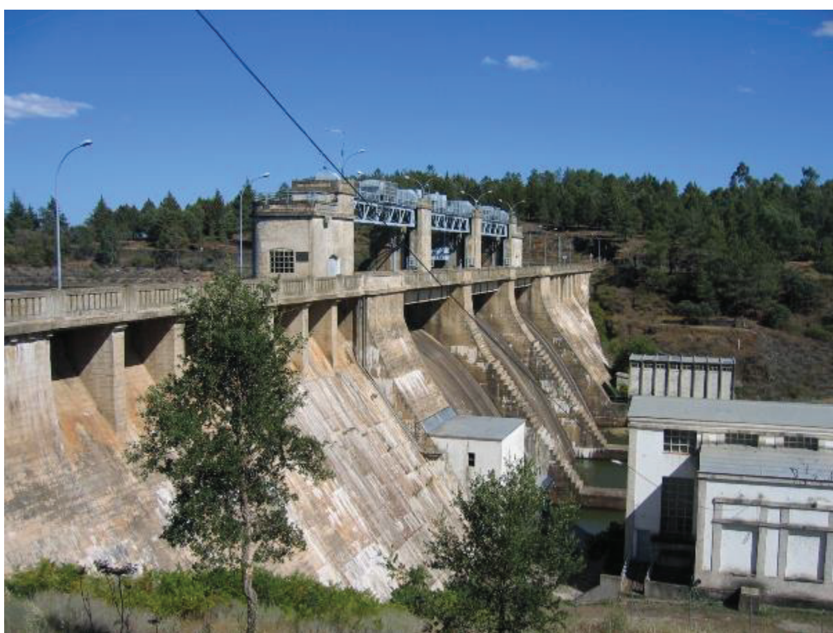
Presa de Borbollón
