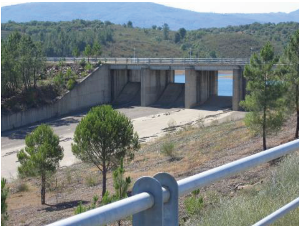
Aliviadero Presa de Rivera de Gata
