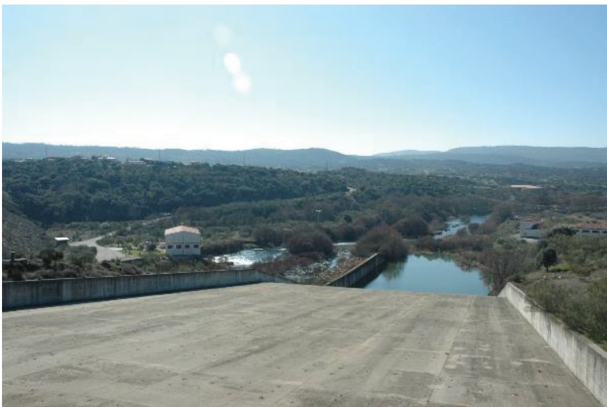
Aliviadero Presa del Jerte
