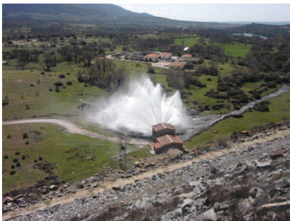
Desagüe de Fondo de la Presa de Baños
