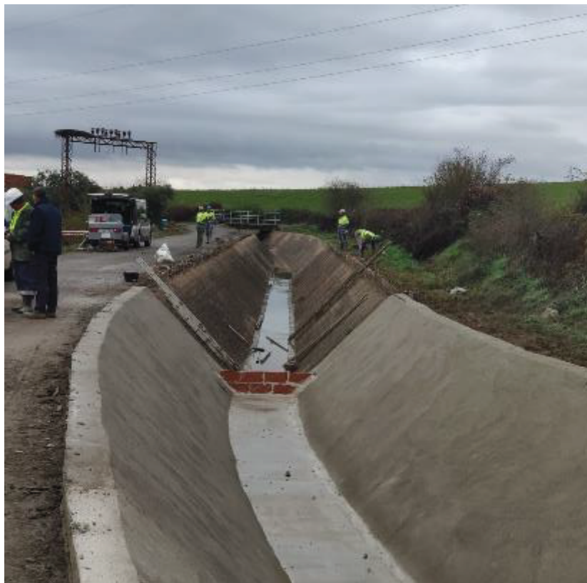
Trabajos de gunitado en Canal Secundario Primero Margen Derecha RELACIÓN DE CULTIVOS CAMPAÑA 2019 M.IZQUIERDA
