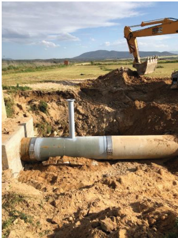
Rotura reparada en la tubería de 900 mm
