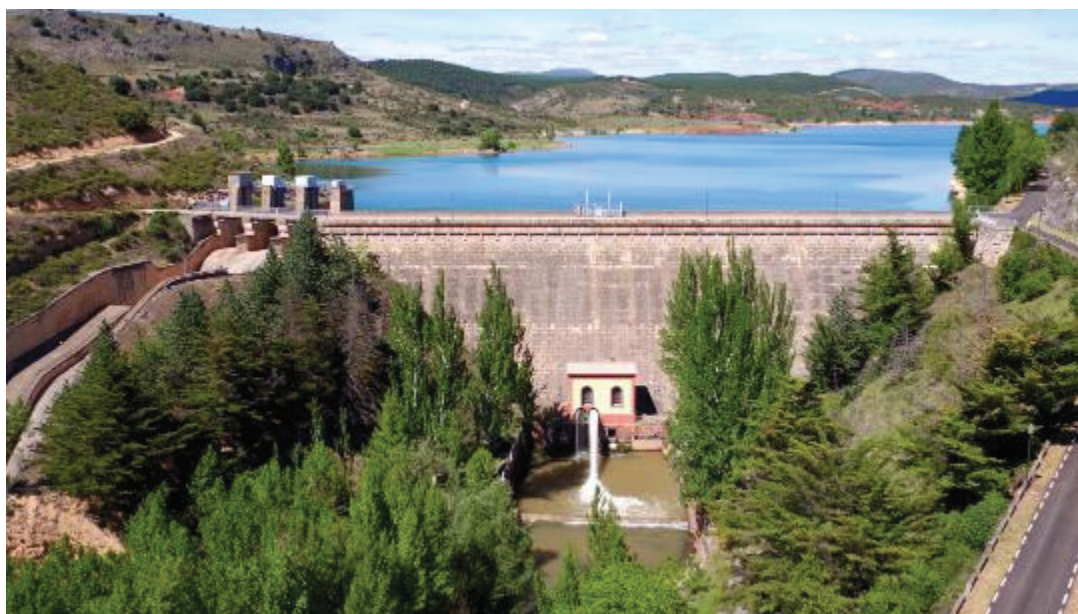
Presa de Pálmaces
