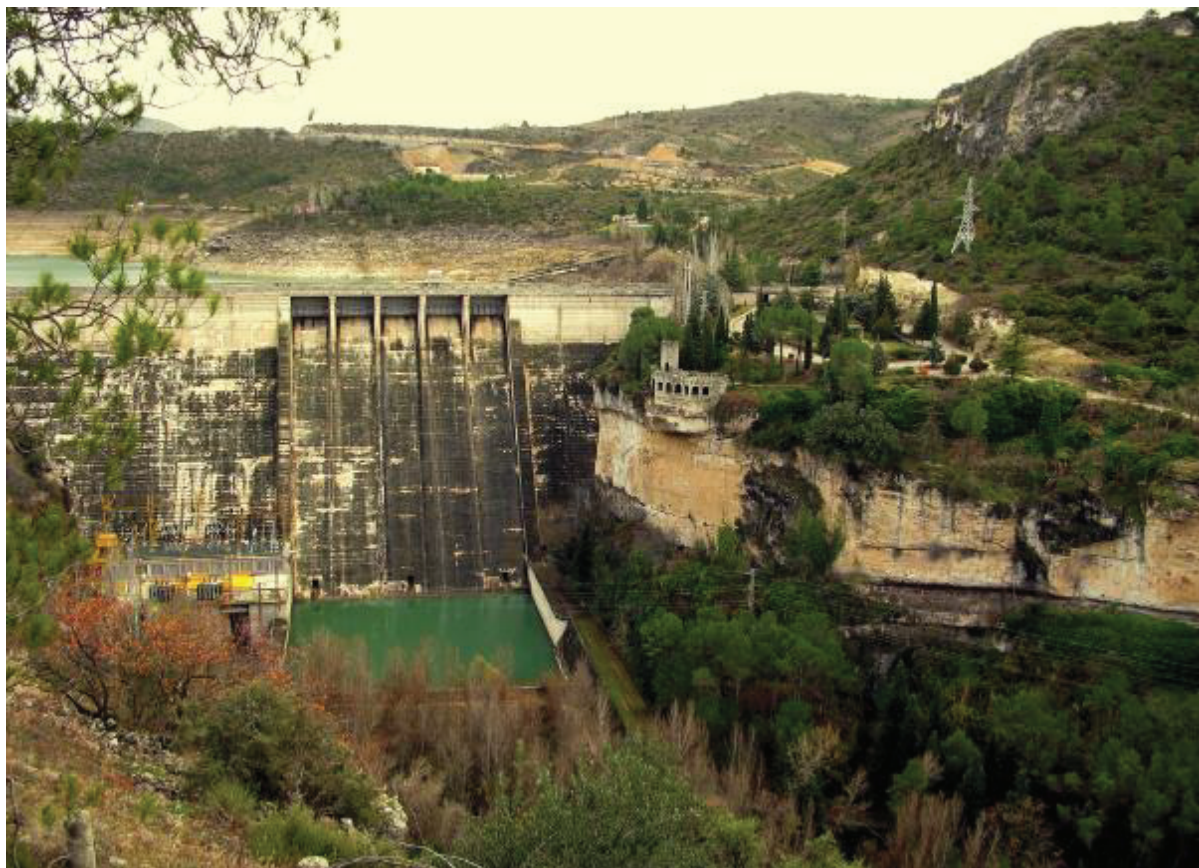
Presa de Entrepeñas
