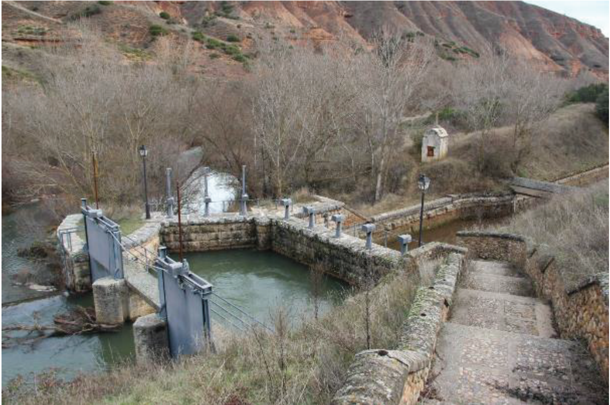
Toma del Canal del Henares
