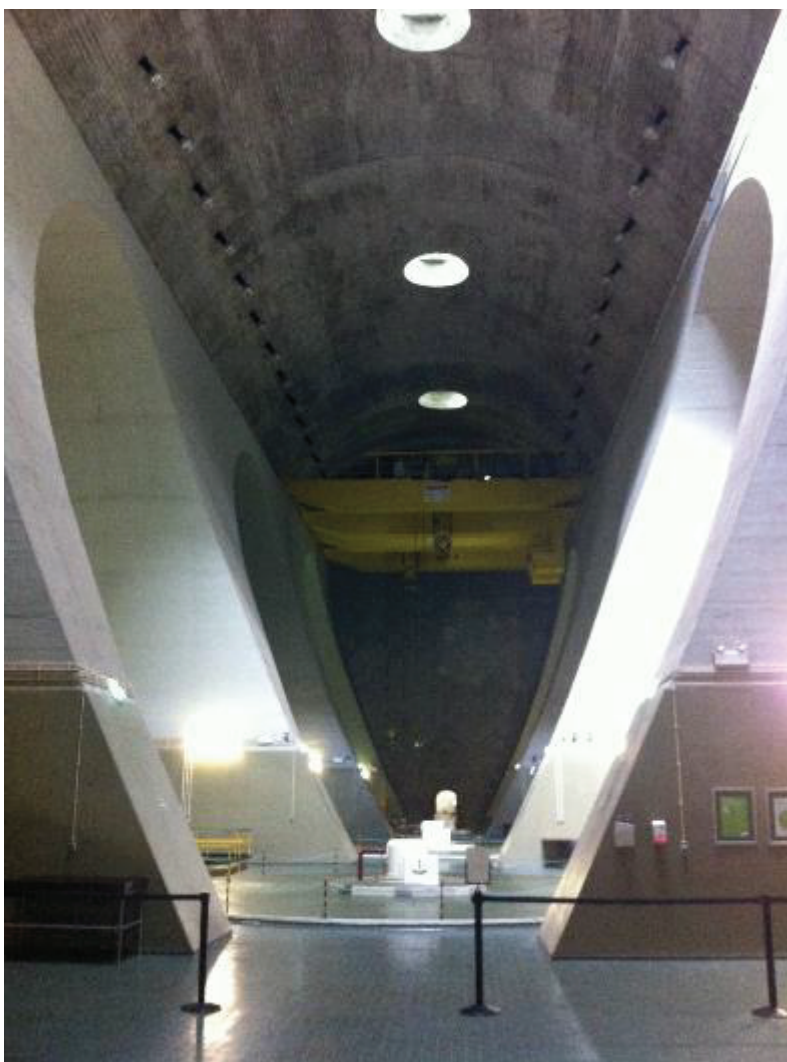
Cámara de turbinas presa de Fratel – Portugal
