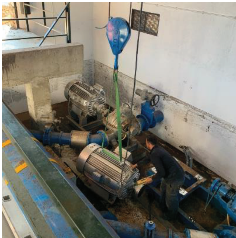
Desmontaje de equipos de bombeo Torre 1 tras la rotura e inundación
