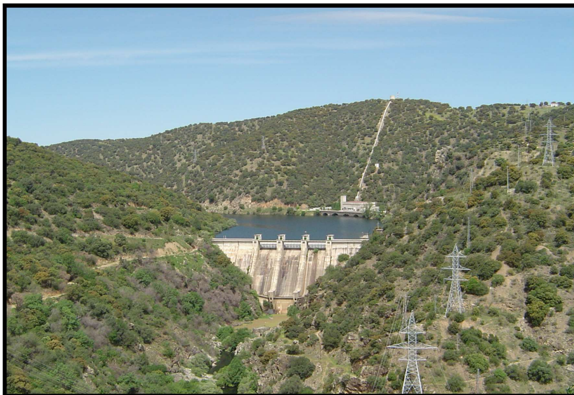
Presa de Picadas
