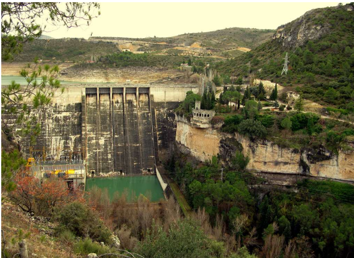
Presa de Entrepeñas
