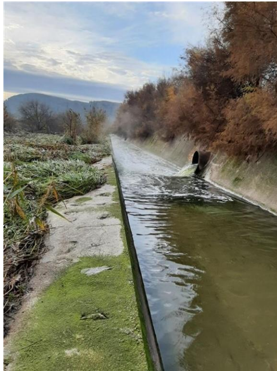
Figura 74. Vertido de la EDAR Sur Oriental, municipio Rivas-Vaciamadrid, cauce arroyo los Migueles (100m más abajo desemboca en el Manzanares). Autor: Comisaría de Aguas de la CHT
