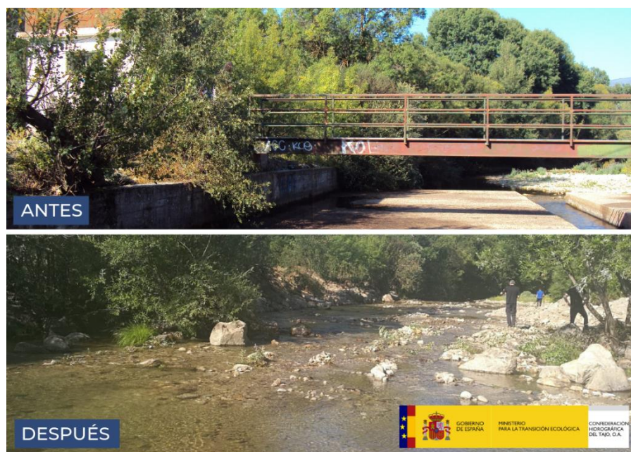
Figura 11. Eliminación de la estación de aforos del río Lozoya en Alameda del Valle (Madrid)
