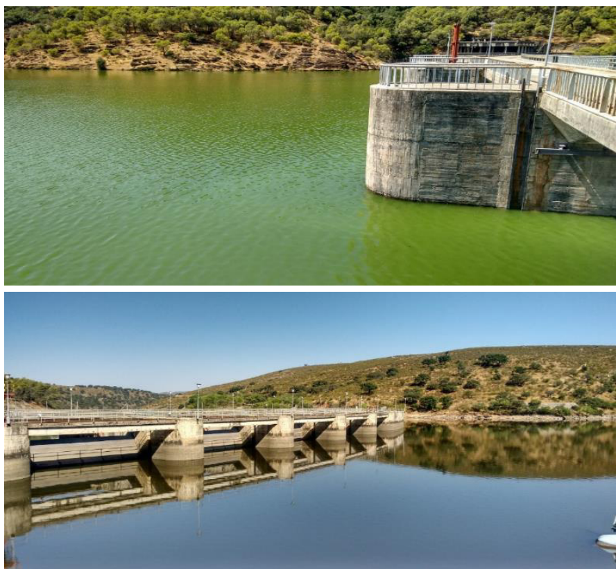
Figura 5. Imagen de dos embalses de la cuenca de diferentes geologías: arriba está el embalse de tipo calcáreo de Torrejón-Tajo y abajo el embalse de tipo silíceo Torrejón-Tiétar a su paso por el Parque Nacional de Monfragüe (Cáceres)
