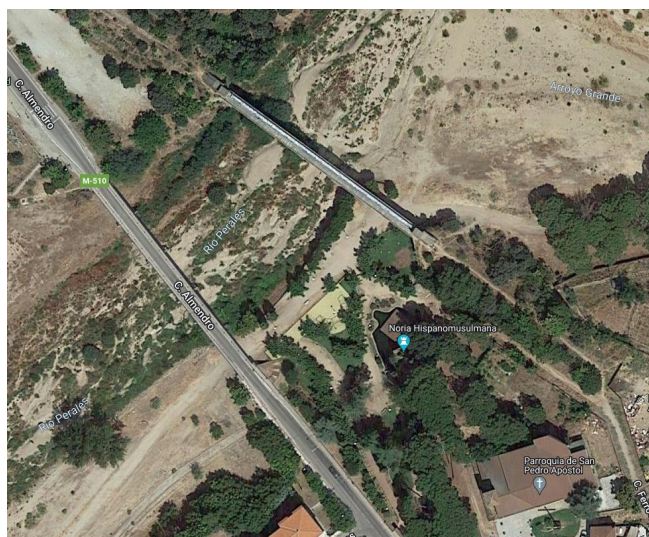
Imagen satélite de los puentes afectados en el río Peral
