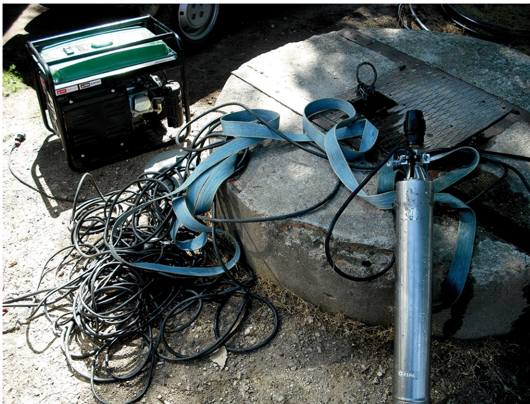
Ilustración 6. Detalle de sondeo sin bomba instalada
