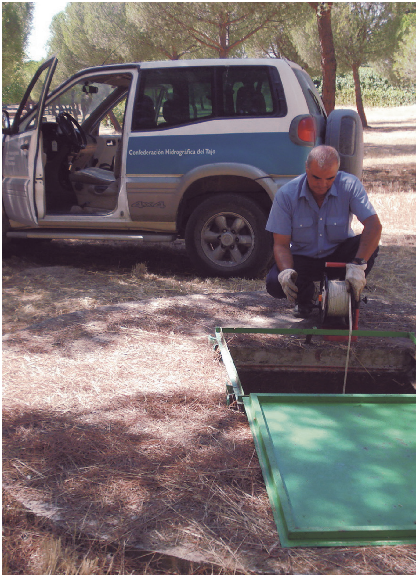
Medición de niveles por un operario (Las Lomas)
