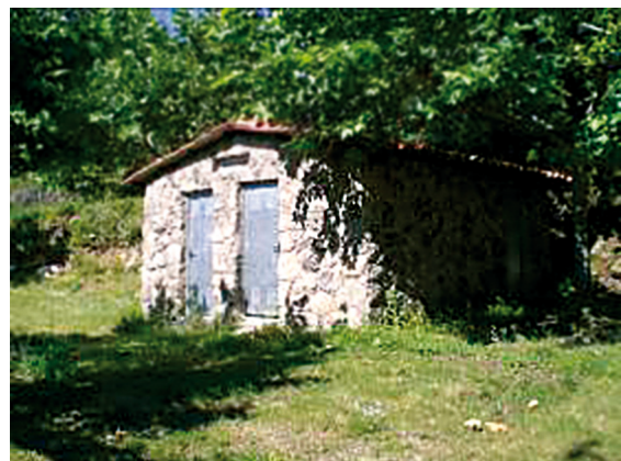
Figura 12. Caseta de aseos
