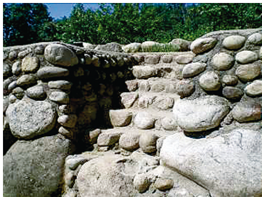
Figura 17. Escaleras de acceso al agua
