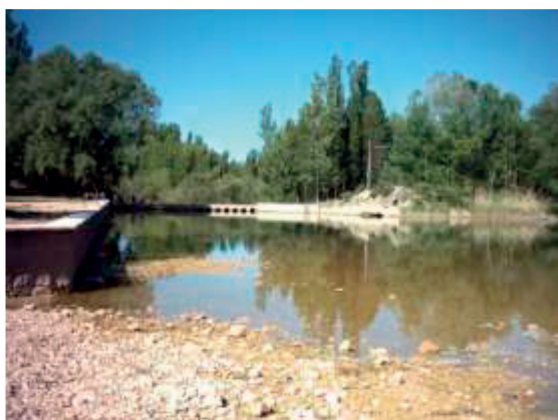
Figura 8. Vista general de la piscina
