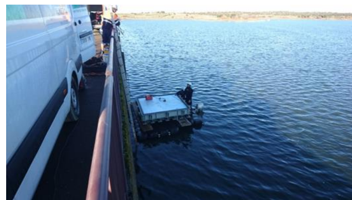
Fotografía 21. Colocación del escudo en la presa de Arroyo de la Luz
