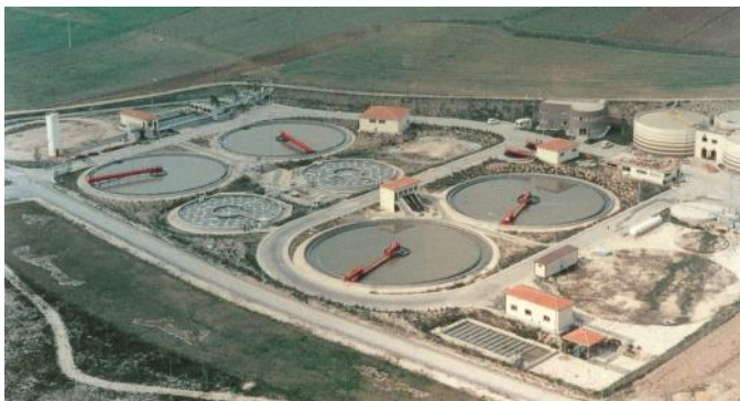
Fotografía 6. EDAR de Arroyo de la Vega
