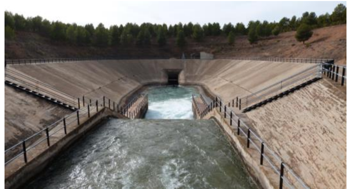
Fotografía 27. Entrada del túnel de El Tálave.
