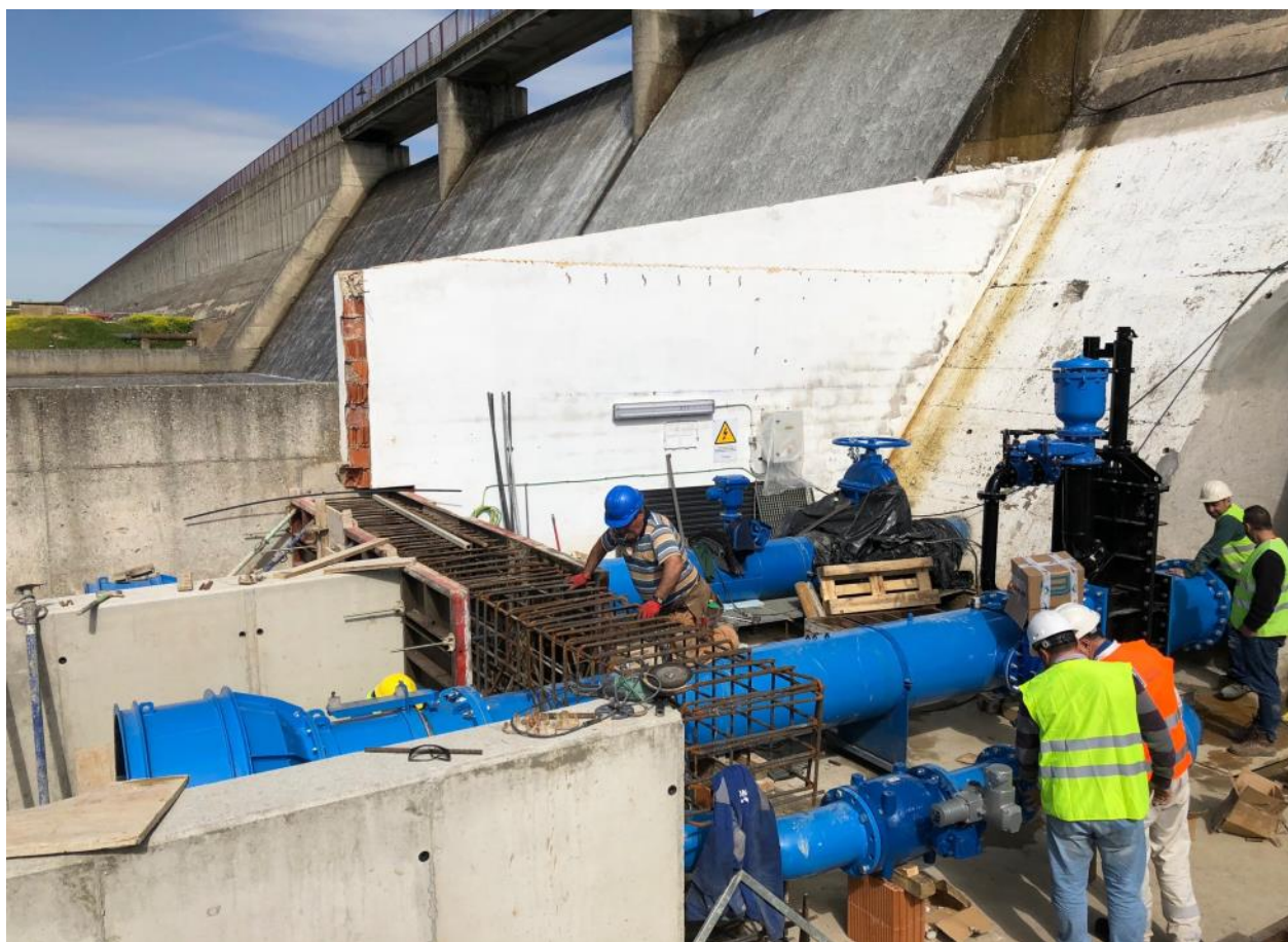
Fotografía 8. Presa de Arroyo de la Luz
