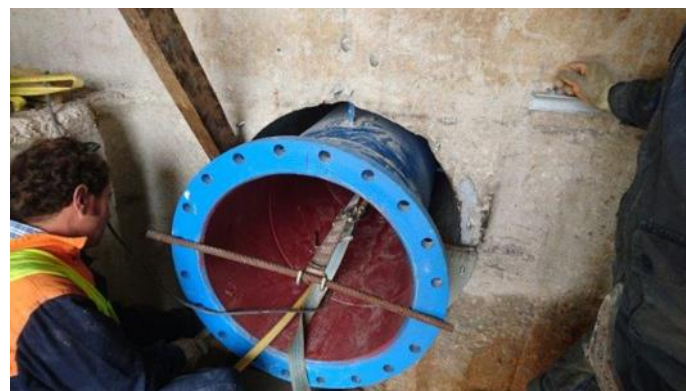
Fotografía 20. Encofrado del segundo desagüe en la presa de Arroyo de la Luz
