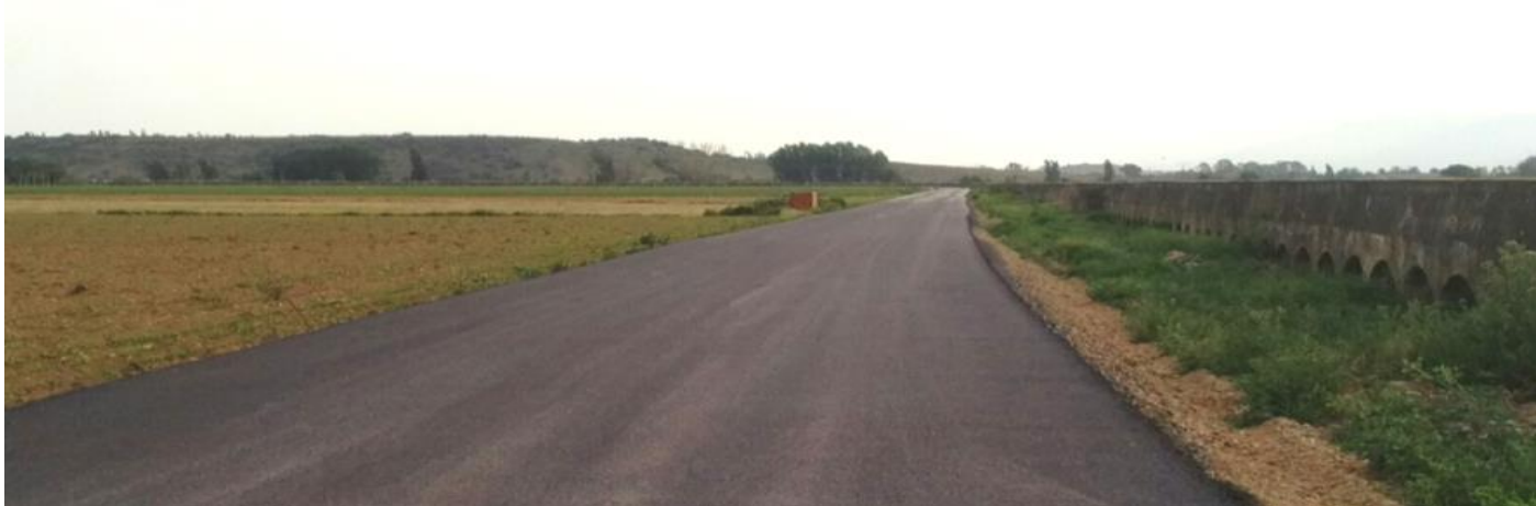
Fotografía 18. Camino de servicio de las acequias de la Zona Regable de la Margen Derecha del Alagón
