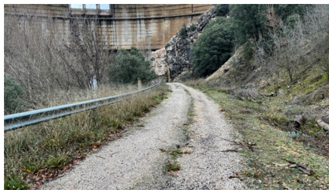
Foto 74. Estado inicial. Presa de la Tajera.
