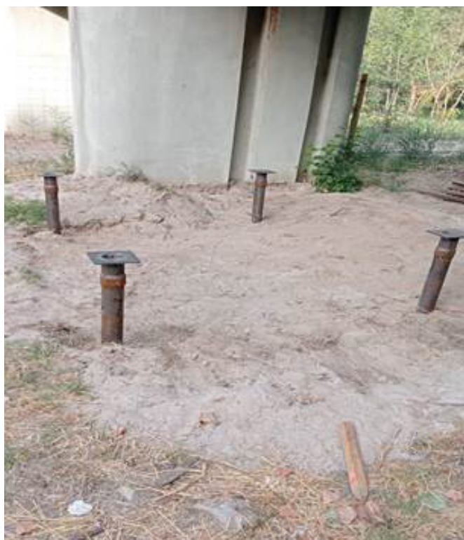
Foto 8. Apertura de sendas para uso peatonal.
