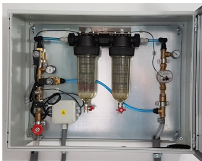
Foto 22. Muestreador automático. Detalle de filtros.
