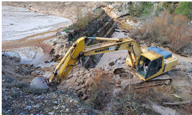
Foto 89. Obras en la margen del río Merdero
