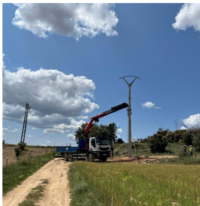
Foto 81. Instalación de poste eléctrico proximidades del municipio de Cifuentes.
