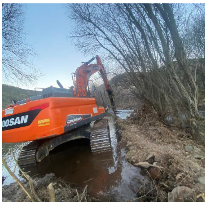
Foto 13. Río Pusa, azud de las Becerras, durante la ejecución
