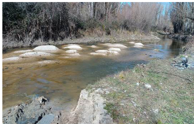
Foto 2. Extracción de la vegetación invasora del centro del cauce del río Manzanares e incorporación a orilla más próxima a la margen izquierda del río, mediante el uso de retroanfibia y de retroexcavadora de brazo largo.
