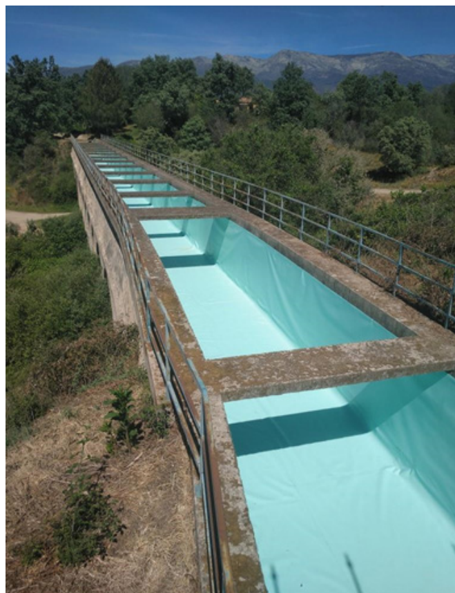
Foto 67. Impermeabilización de acueducto con lámina TPO. Zona Regable de Rosarito
