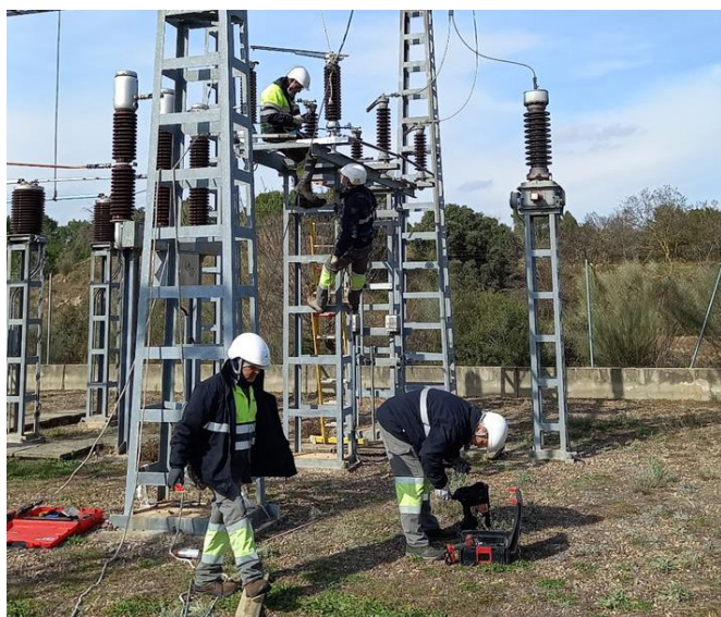
Foto 123: Mantenimiento y conservación de instalaciones de alta tensión.
