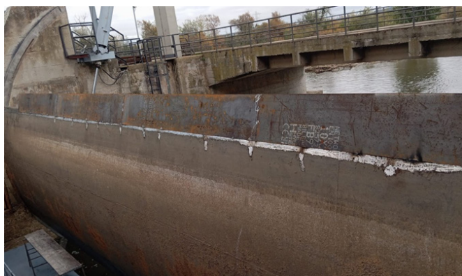
Foto 54. Recrecimiento de la compuerta. Presa del Rey.
