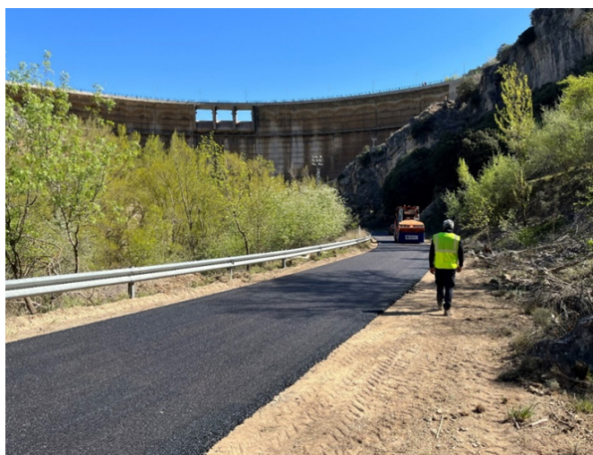
Foto 76. Trabajos de compactado. Presa de la Tajera.
