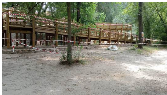
Foto 5. Pasarela adaptada para acceso a la zona del cauce
