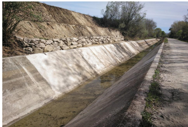
Foto 66. Impermeabilización de acueductos y tramos de canal y acequias mediante lámina TPO.
