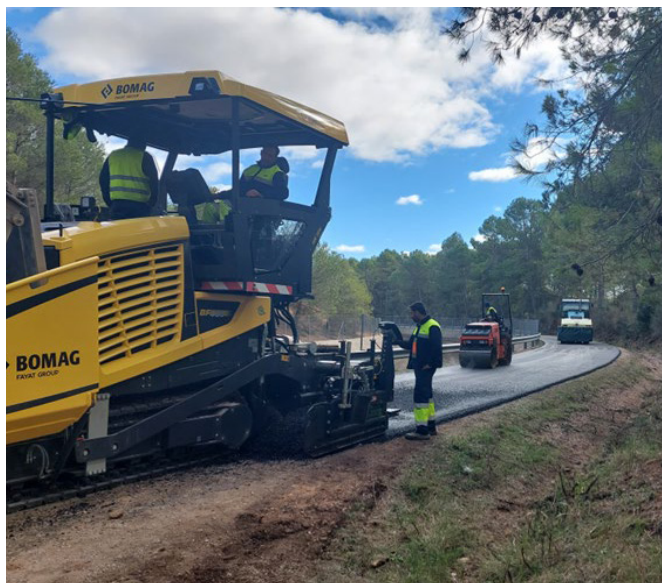
Foto 126. Asfaltados en reposición de caminos de servicio
