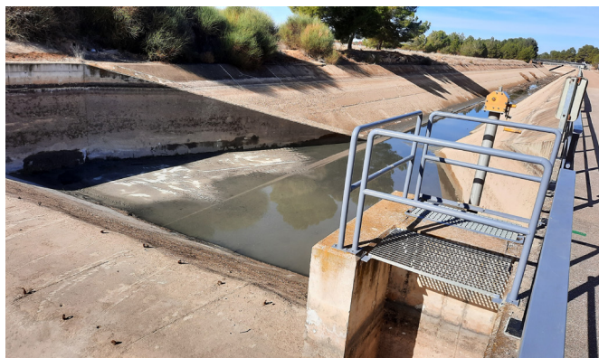
Fotos 129 y 130. Limpieza de arrastres y escombros. Estados inicial y final del canal.
