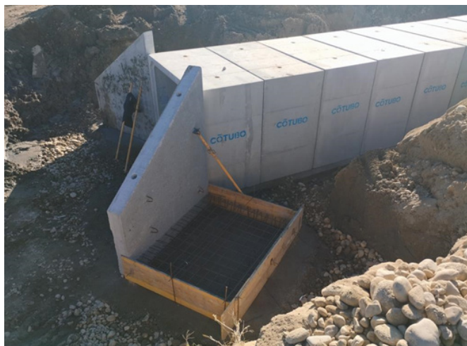
Foto 65. Trabajos de reconstrucción de la ODT, Quebrada de Charcones.
