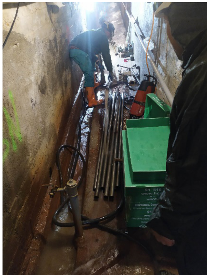
Fotos 91 y 92. Perforación de drenes en la presa de Villanueva
