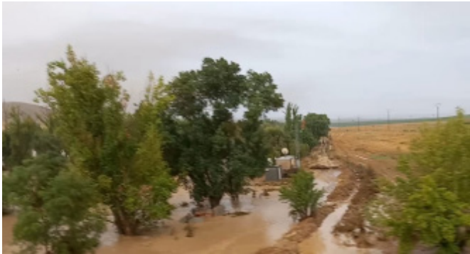
Foto 37. Estado de la estación AR20 tras el paso de la DANA
