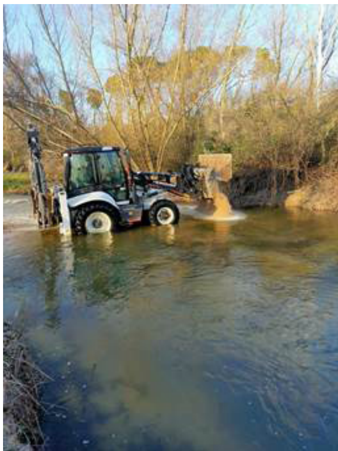
Foto 1 Reubicación de sedimentos en cauce
