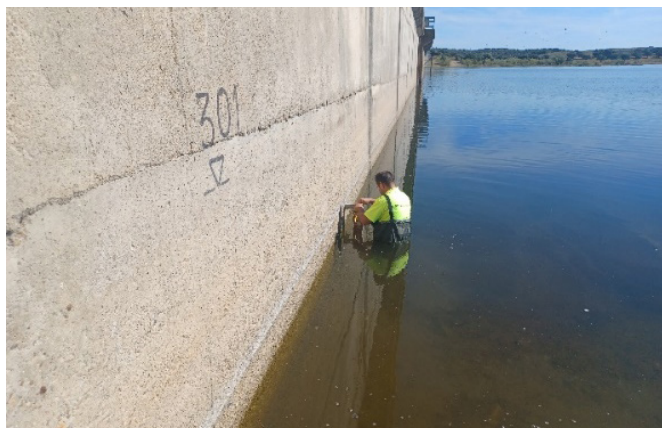
Foto 94. Colocación de escalas limnimétricas en la Presa de Portaje.
