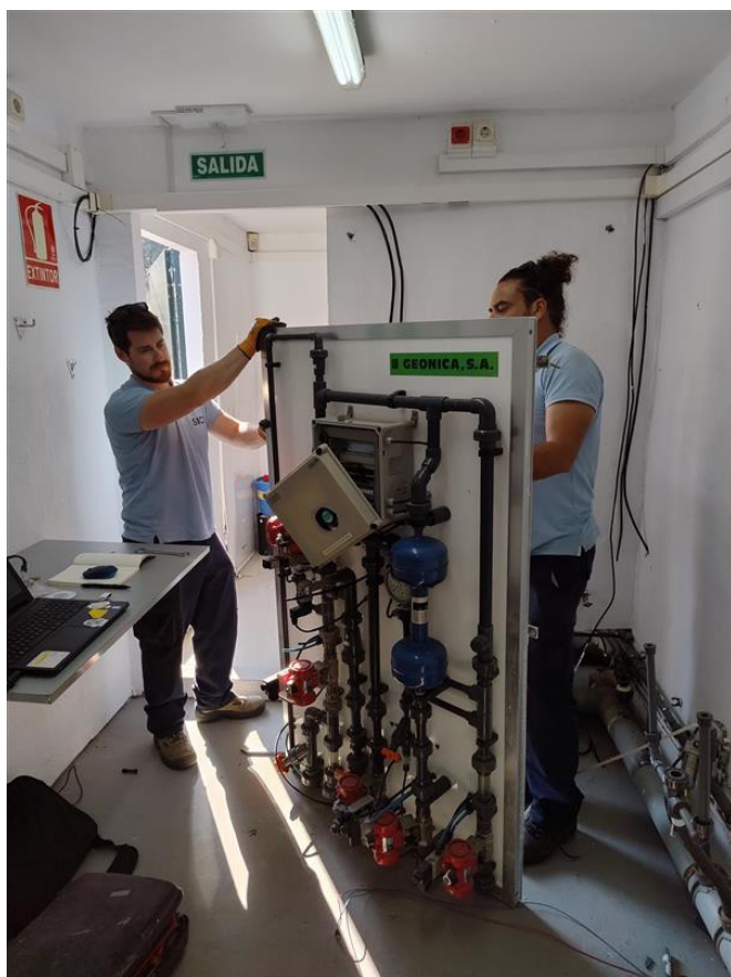
Foto 39. Reparaciones en estación SAICA de calidad de las aguas.
