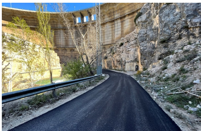
Foto 77. Estado final. Presa de la Tajera.
