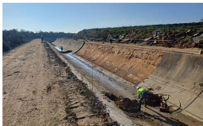
Foto 59. Trabajos de reparación del canal. Canales de Aranjuez
