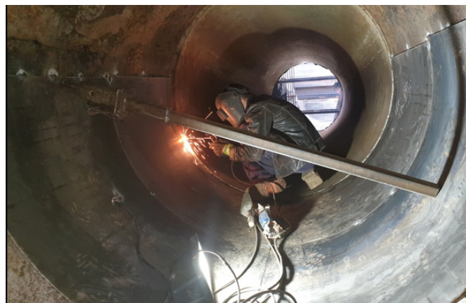
Foto 64. Trabajos de soldadura de las piezas metálicas del interior de la tubería del sifón. Zona Regable de Castrejón, Margen Izquierda.
