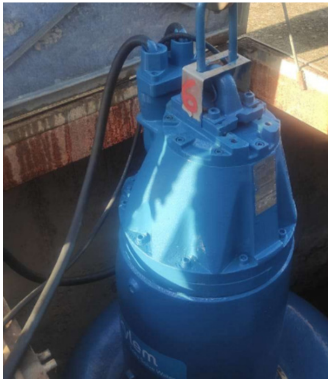
Fotos 56 y 57. Reparación y puesta a punto del bombeo. Canal de las aves Aranjuez.
