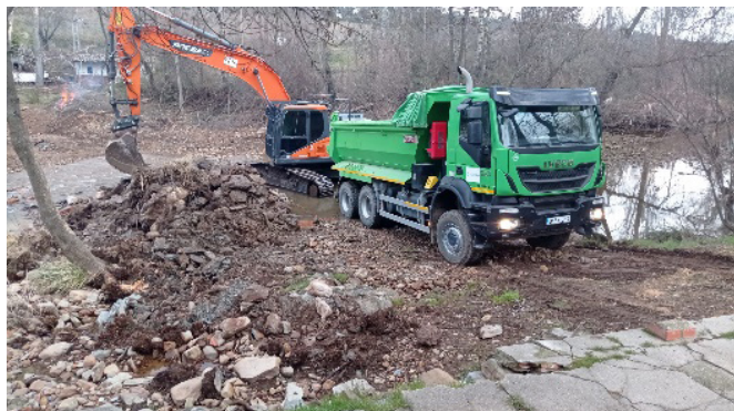
Foto 11. Río Pusa, azud de El Mazo, durante la ejecución
