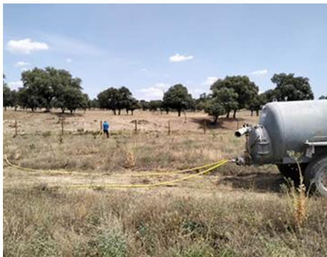
Foto 4. Reposición de cerramiento de seguridad en la confluencia del arroyo de la Trofa con el Manzanares.
