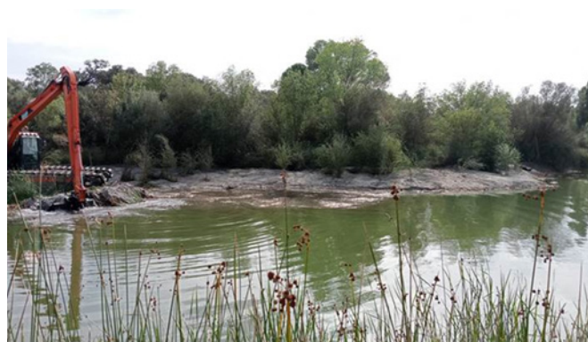
Foto 3 Retroanfibia en el Manzanares, extrayendo vegetación invasora
