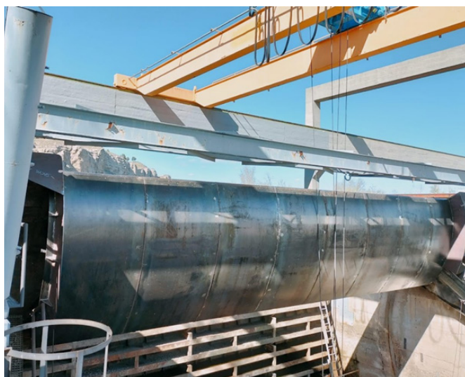
Foto 55. Acondicionamiento de las compuertas. Presa del Rey.
