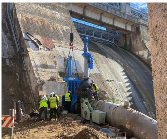
Foto 72. Colocación de válvula Bureau circular. Presa de Borbollón
