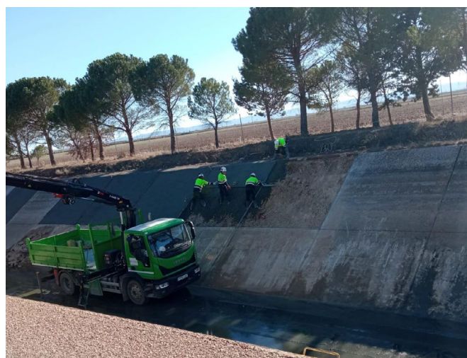
Foto 128. Ejecución de nuevas losas de revestimiento
