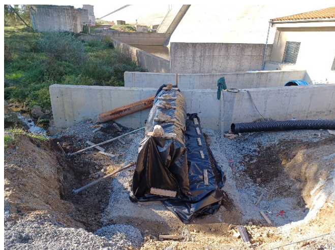
Foto 97 y 98. Obras de protección Presa de Arroyo de la Luz
