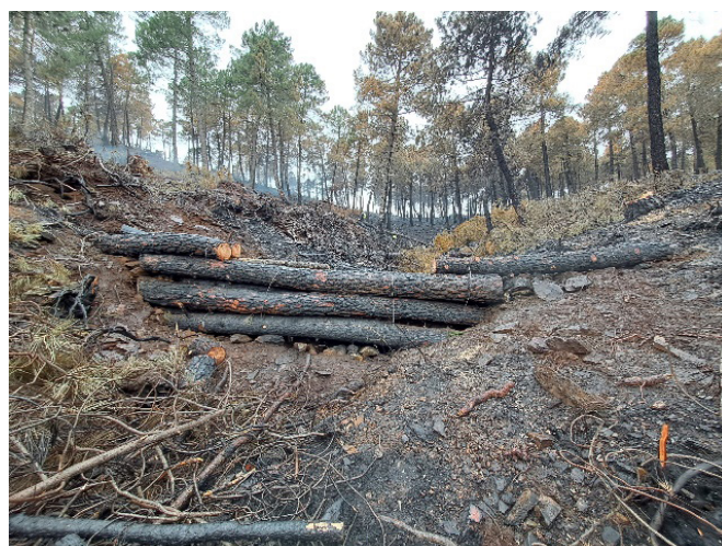
Foto 16. Albarradas realizadas con troncos de árboles quemados
