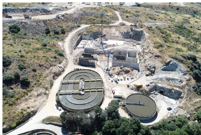
Foto 86. Obras en la EDAR de Plasencia.
