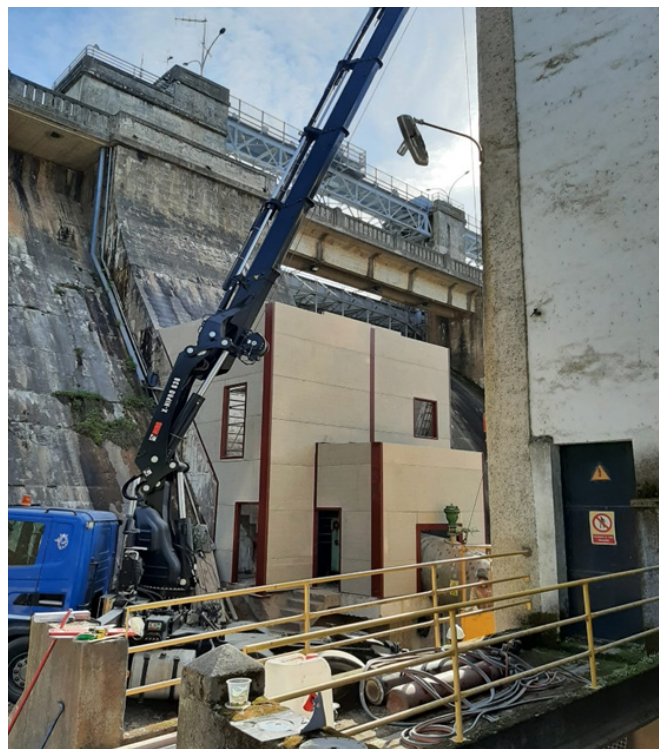
Foto 73. Trabajos de construcción de casetas. Presa de Borbollón
