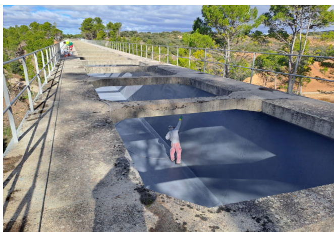
Foto 131. Reparación de acueductos
