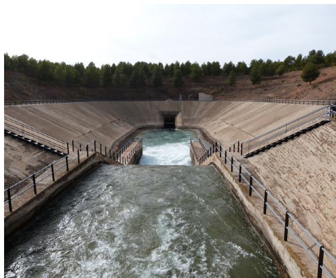
Foto 124. Trasvase Tajo-Segura. Entrada al túnel del Talave. Provincia de Albacete.
