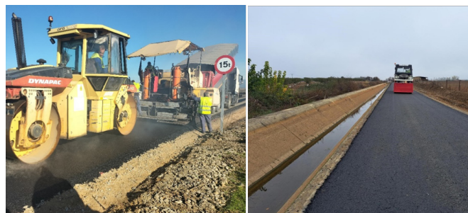
Fotos 68 y 69. Trabajos de asfaltado en los caminos de servicio. Zona Regable del Árrago.
