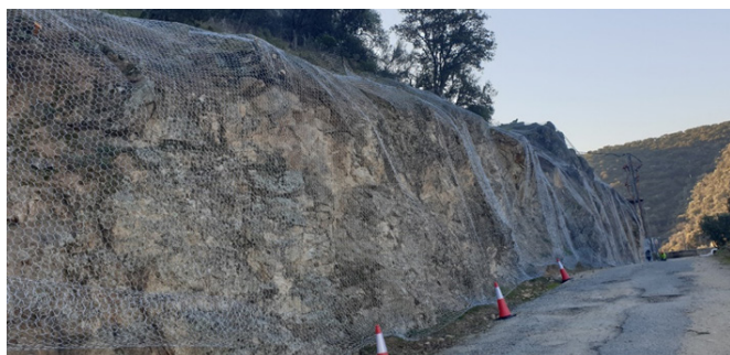
Foto 62. Colocación de malla de protección en la margen izquierda de la Presa de Picadas
