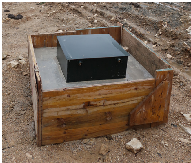
Foto 48. Encofrado de madera del dado de hormigón de un nuevo piezómetro.
