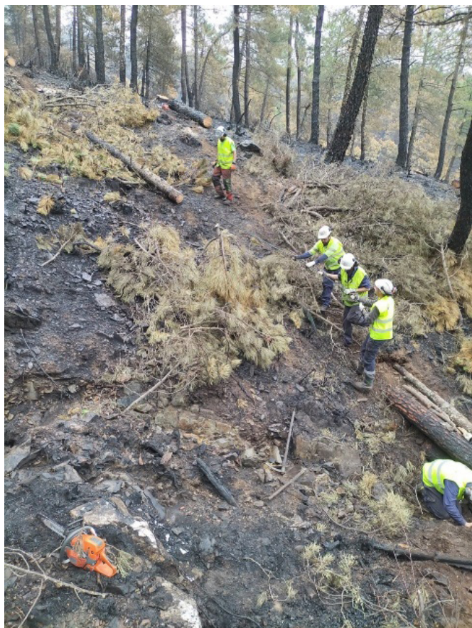
Foto 17. Construcción de fajinas de retención de arrastres
