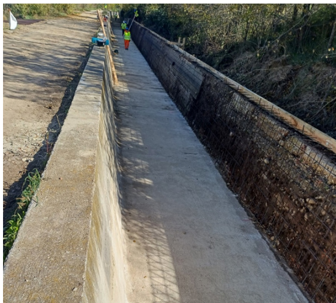
Fotos 60 y 61. Trabajos de reparación de los canales. Canales de Aranjuez.
