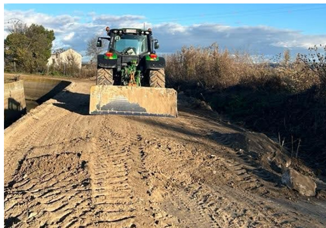
Foto 52. Regularización y despeje del camino. Inmediaciones de la presa del Rey.
