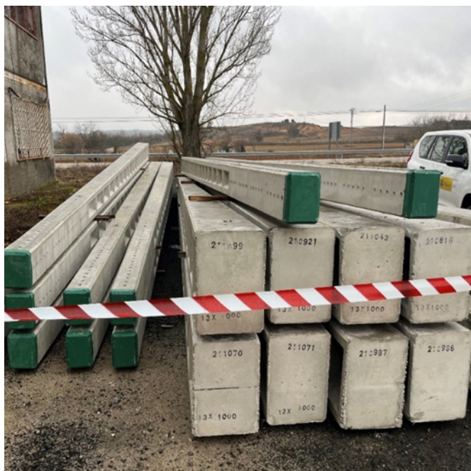
Foto 80. Acopio de postes eléctricos proximidades del municipio de Cifuentes.
