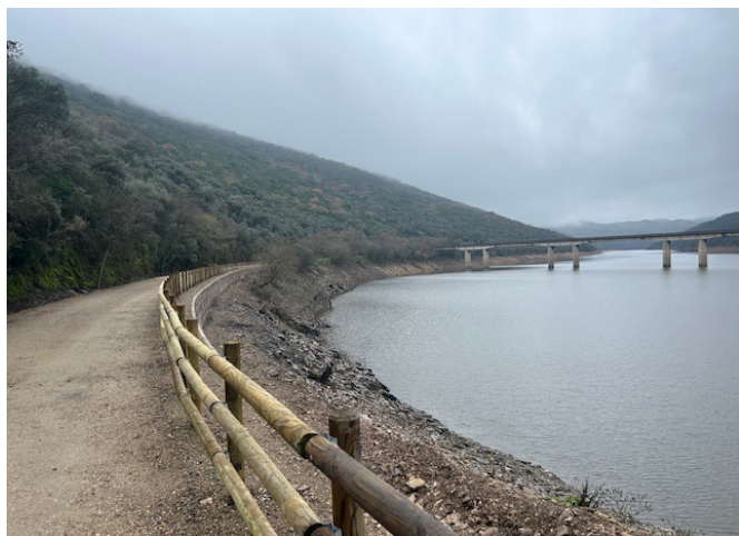
Foto 90. Protección de taludes en el Parque Nacional de Monfragüe
