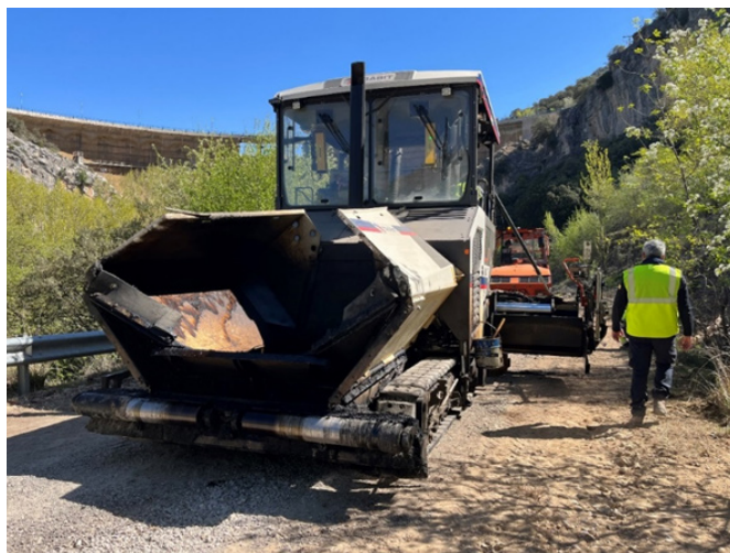
Foto 75. Trabajos de extendido Presa de la Tajera.
