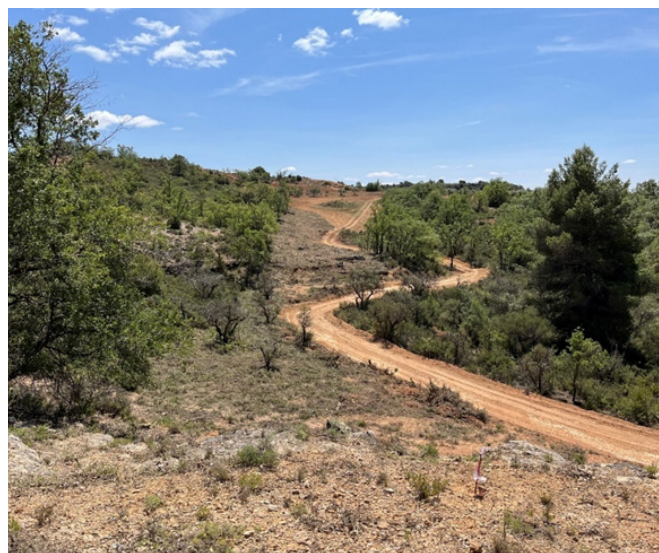
Foto 78. Apertura de camino para trabajos de tala e instalación de postes de línea eléctrica en zona de difícil acceso. Inmediaciones municipio de Cifuentes.
