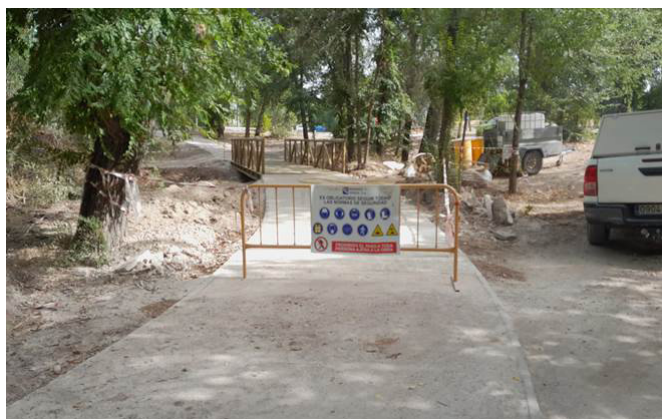
Foto 7. Cimentación de la futura pasarela en la zona del Club Deportivo Puerta de Hierro. Instalación de pilotes.
