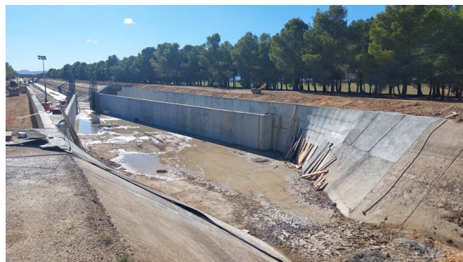
Foto 132. Vertedero tipo “pico de pato” en ejecución por la Confederación Hidrográfica del Júcar
