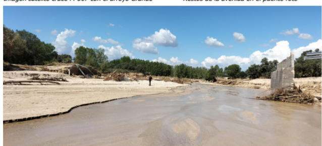
Imagen desde el cauce del arroyo Grande donde el puente roto de la M-507
