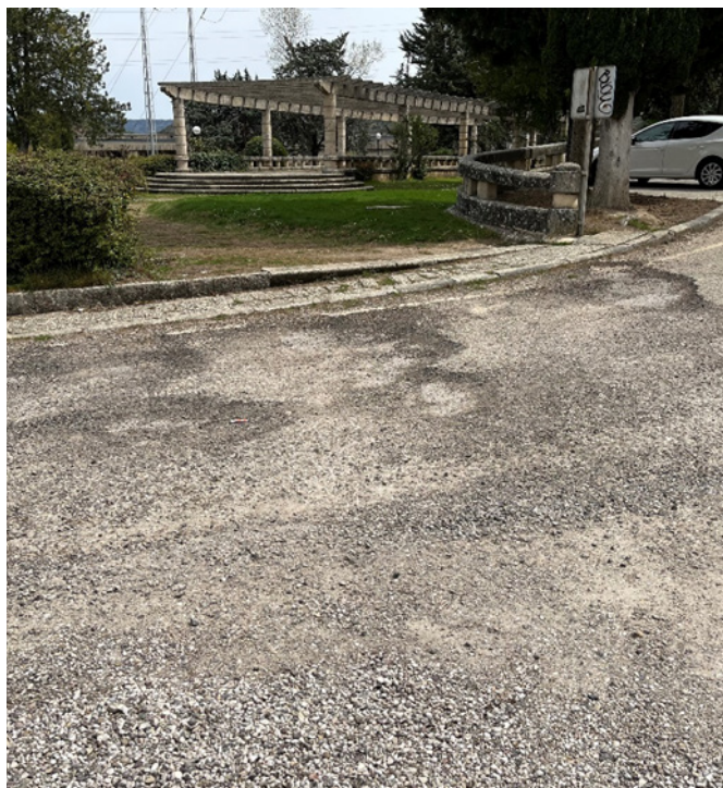
Foto 83. Estado inicial. Inmediaciones presa de Entrepeñas.
