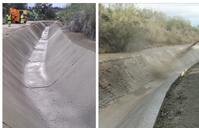
Fotos 70 y 71. Trabajos de gunitado del Canal Secundario Primero de la Margen Derecha del Alagón
