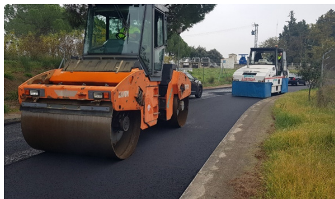
Foto 63. Compactado de la nueva capa de rodadura de mezcla bituminosa en caliente del Camino General de acceso a la presa de Cazalegas.
