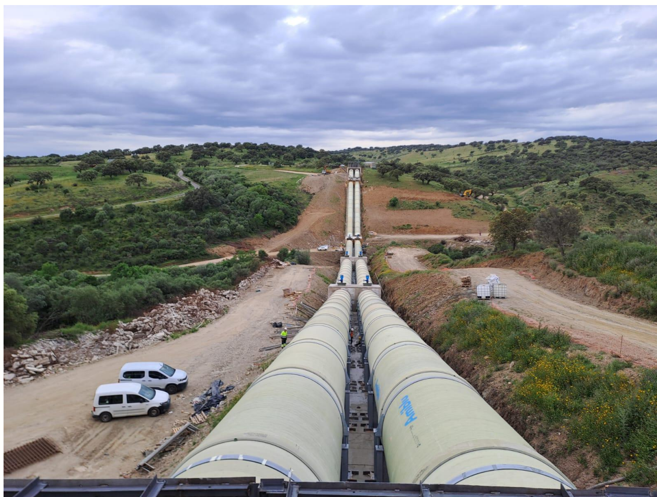
Obra de emergencia del Sifón del Bronco (Cáceres)
