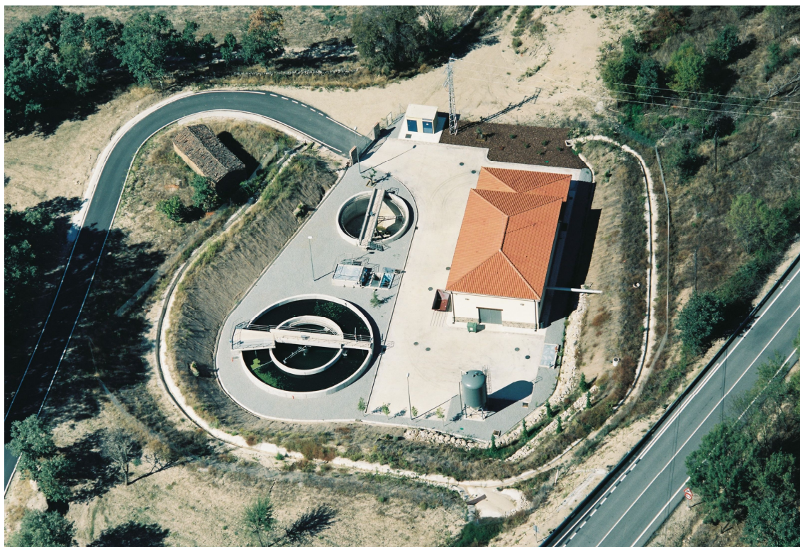
EDAR Talaveruela y Viandar de la Vera, Cáceres
