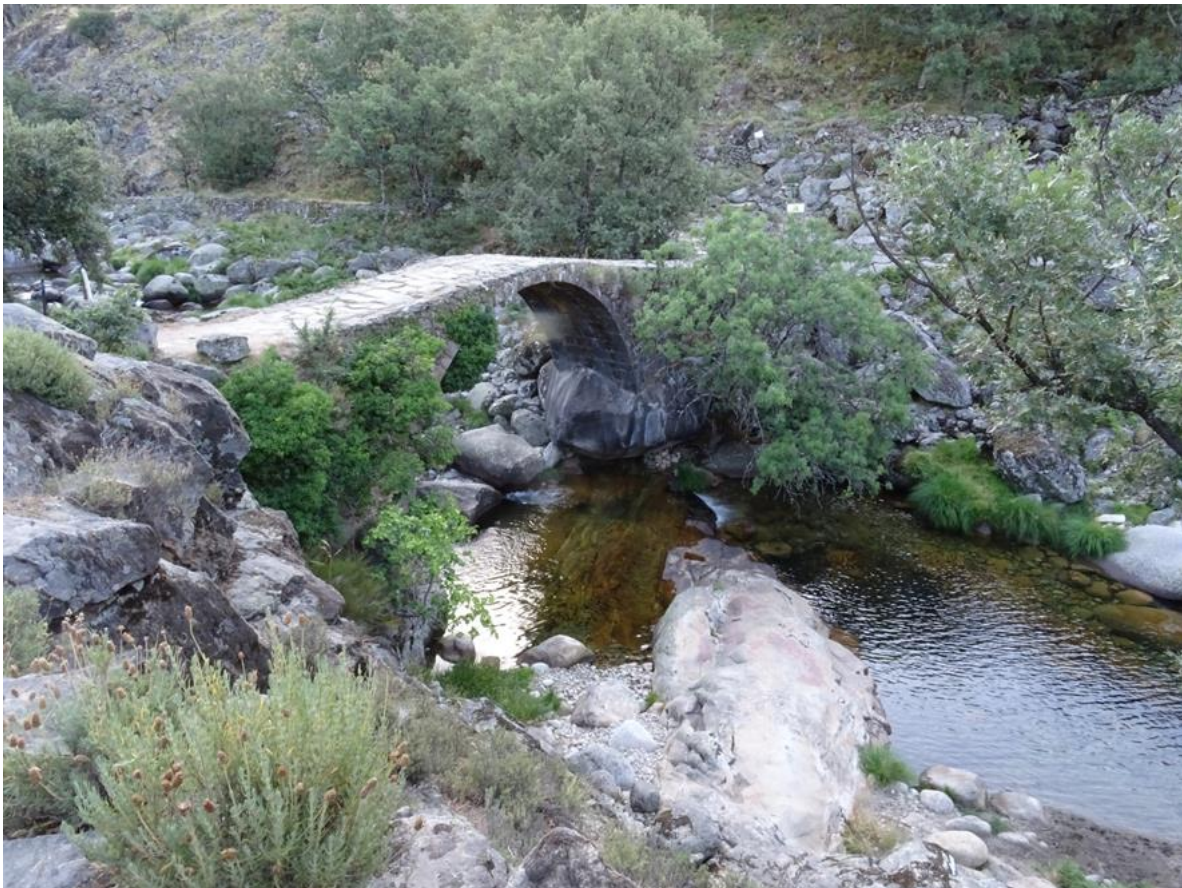
Vista del cauce en el puente Nuevo, en el Arroyo de los Cerros
