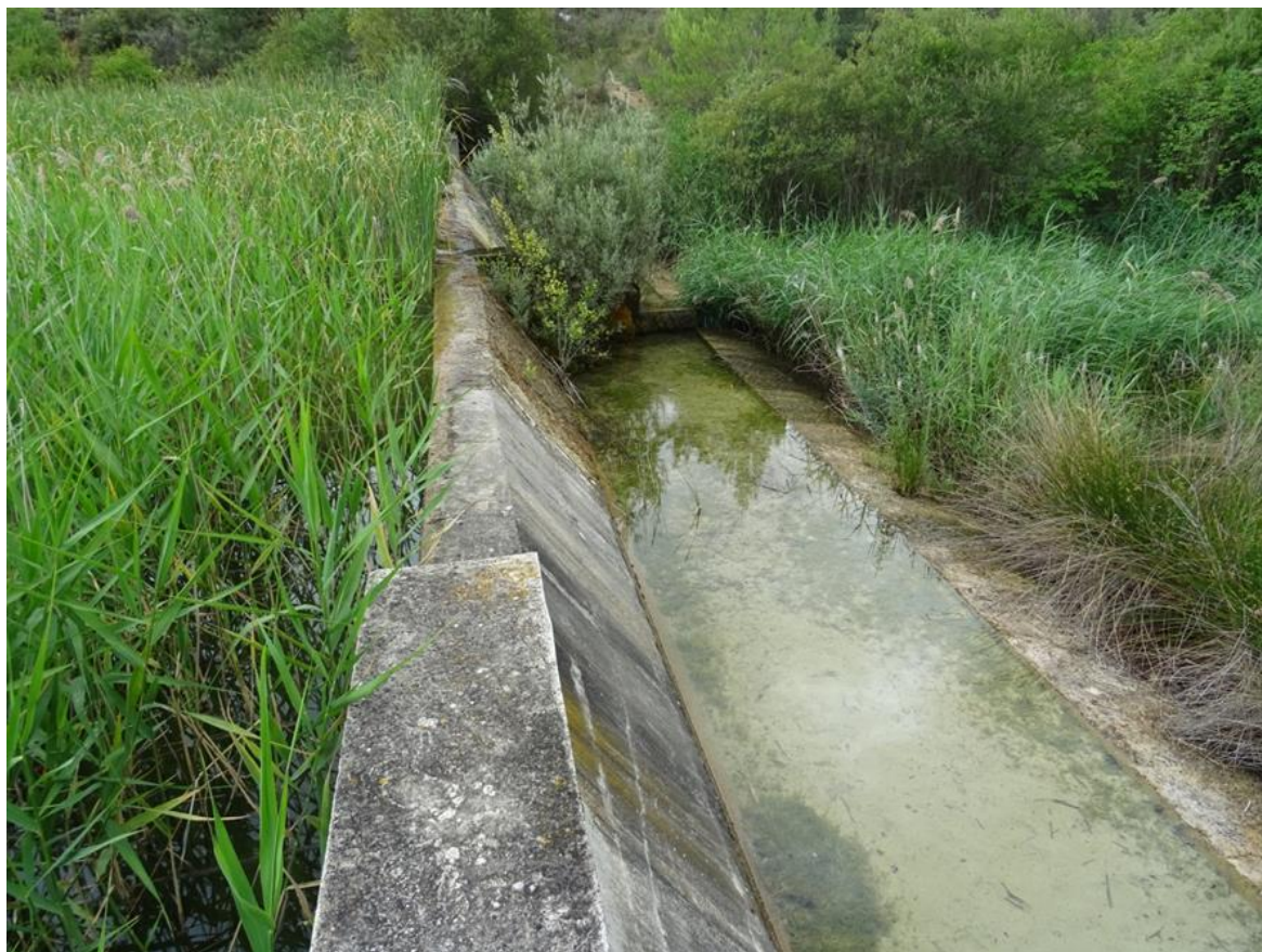
Dique de Ompolveda
