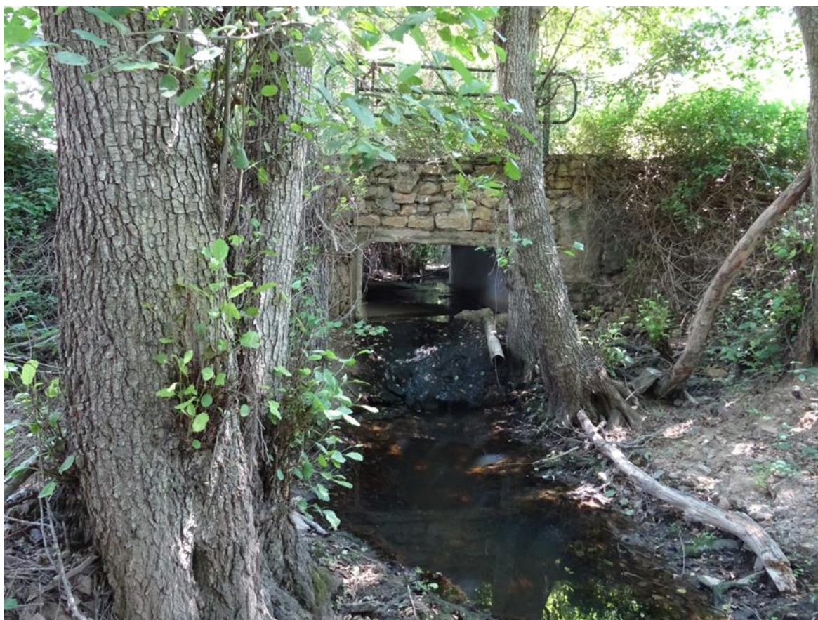
Puente con paso sobre paramento en la zona 2
