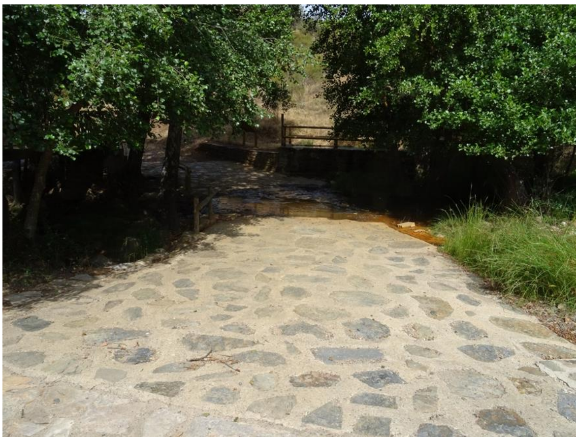
Vado en el puente de Malvecino donde se propone su permeabilización con un canal de aguas bajas
