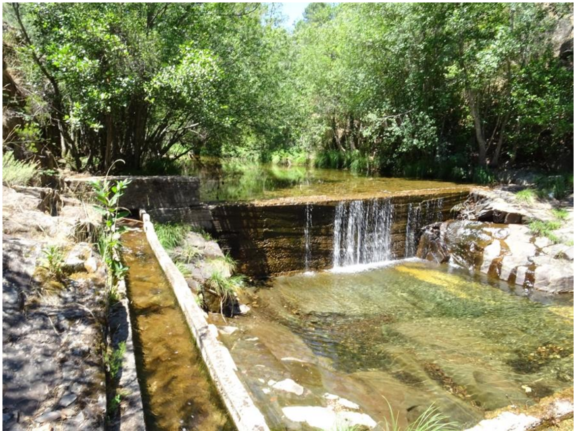
Azud del tramo bajo aguas arriba de Las Mesta
