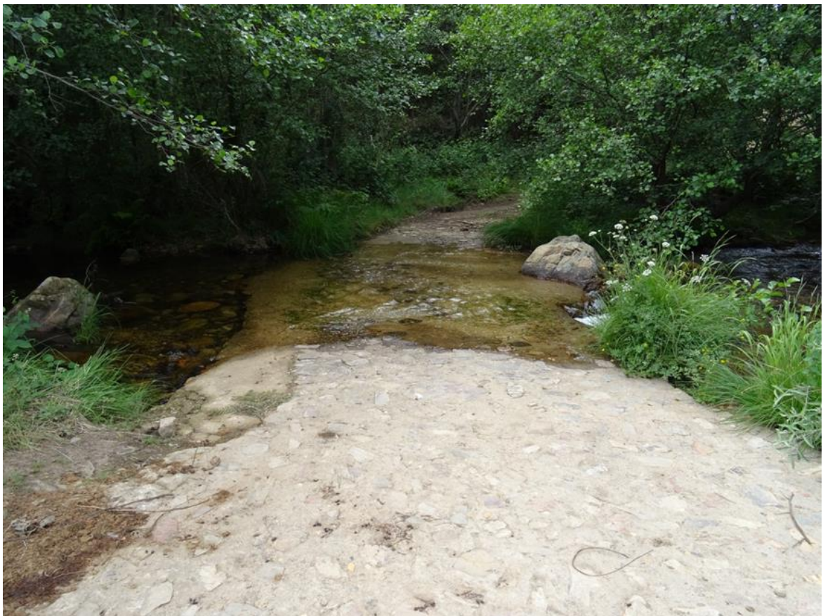
Vado cementado al final de la zona 1 del río Viejas
