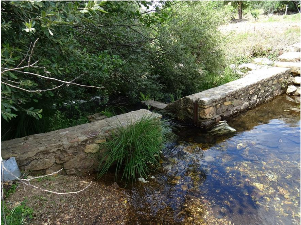
Azud con compuerta en la cabecera del río Viejas
