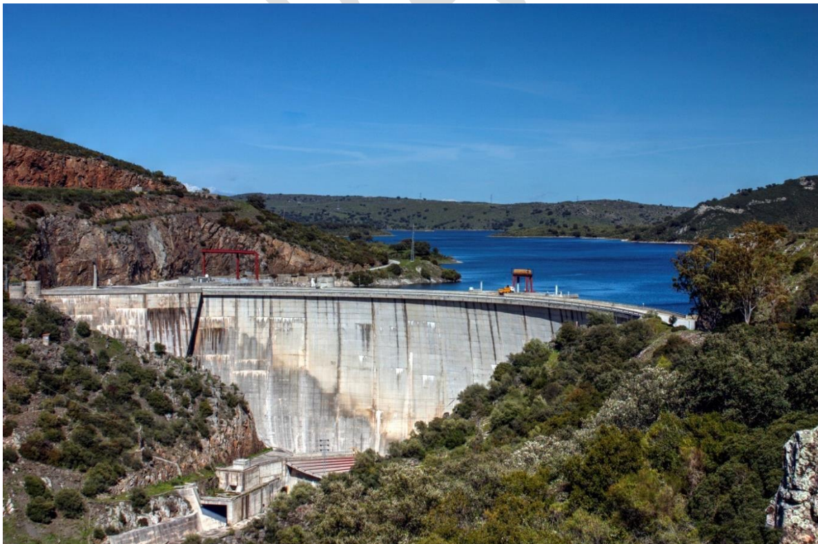
Foto 13. Presa de Valdecañas (Cáceres).
