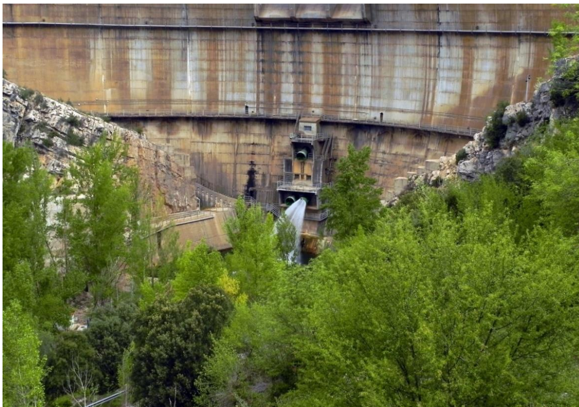
Foto 4. Presa de La Tajera (Guadalajara).
