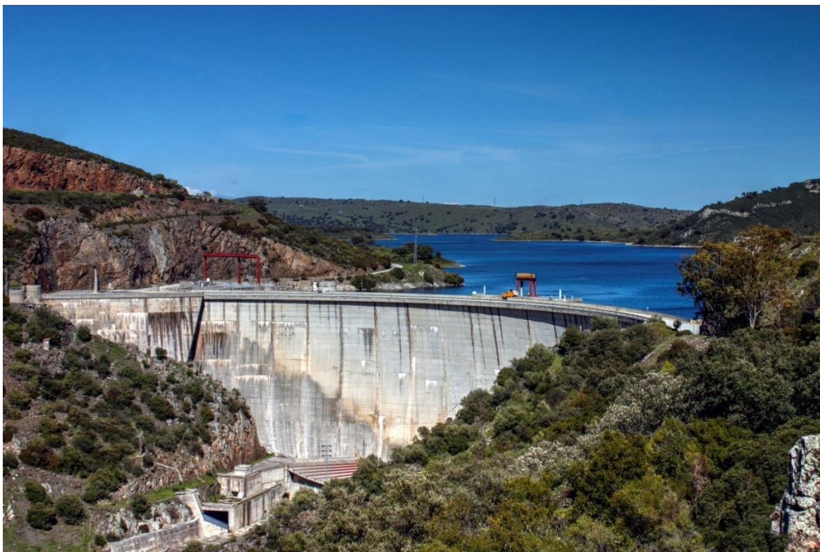
Foto 13. Presa de Valdecañas (Cáceres).
