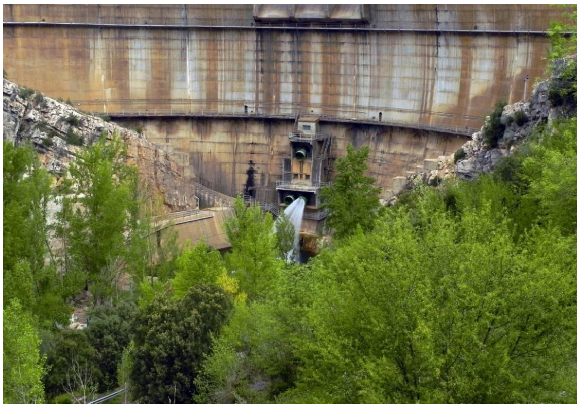
Foto 4. Presa de La Tajera (Guadalajara).
