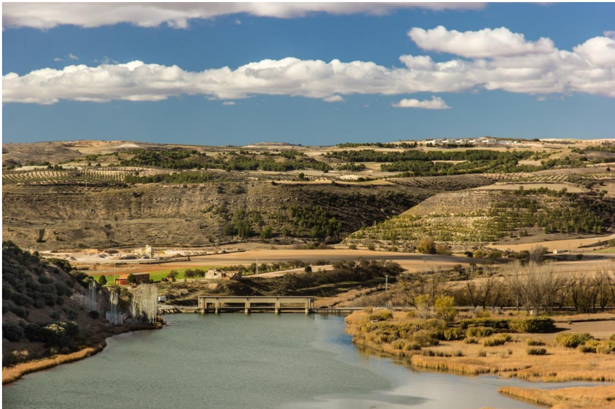
Foto 3. Presa de Almoquera (Guadalajara).
