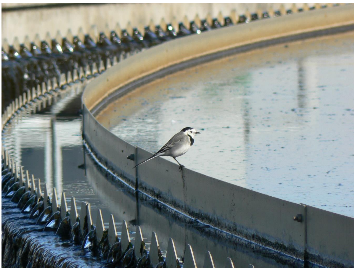
Figura 120. Decantador de la EDAR de la cuenca media del arroyo Culebro (Madrid)
