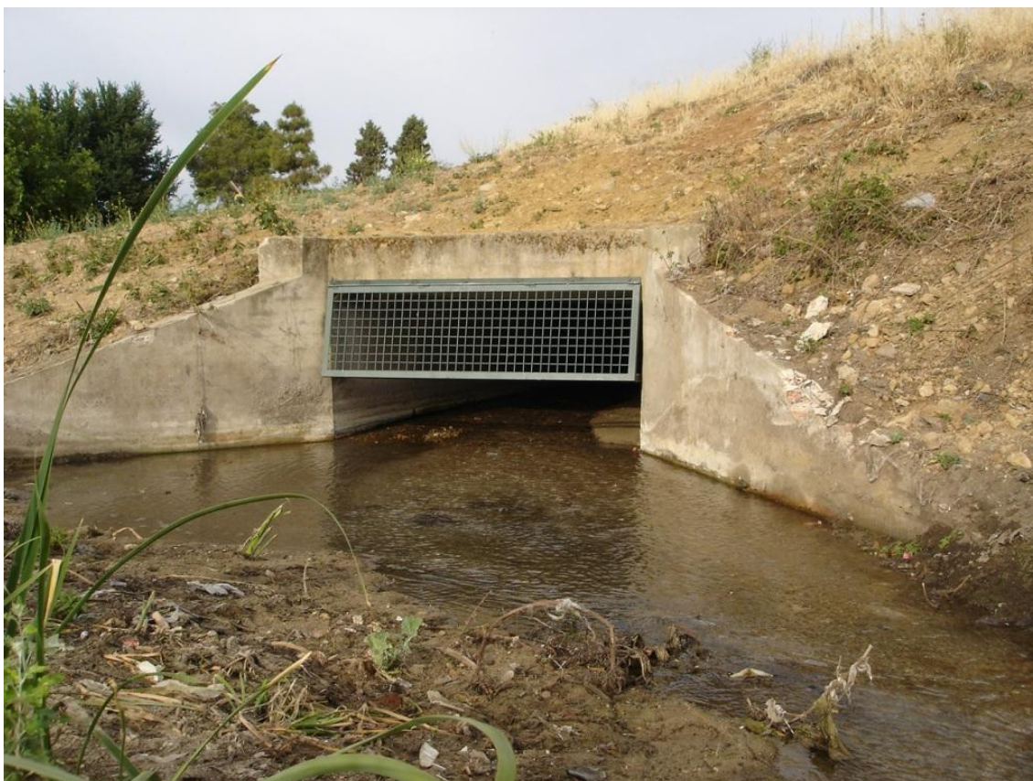
Foto 41: Aliviadero del colector de aguas pluviales de la Avenida de la Hispanidad (18/06/12)
