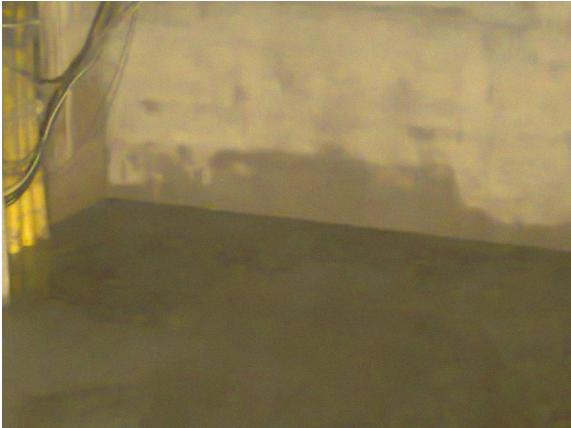
Foto 26. Recinto donde se produce la extracción de agua (20/03/2012).
