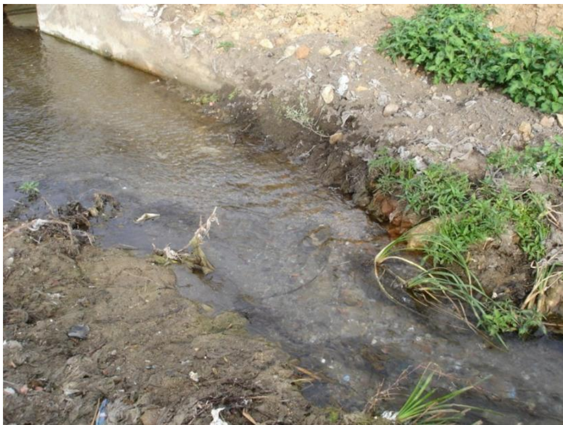
Foto 42: Cauce de la Ribera del Marco en el punto del aliviadero del colector de aguas pluviales de la Avenida de la Hispanidad (18/06/12)
