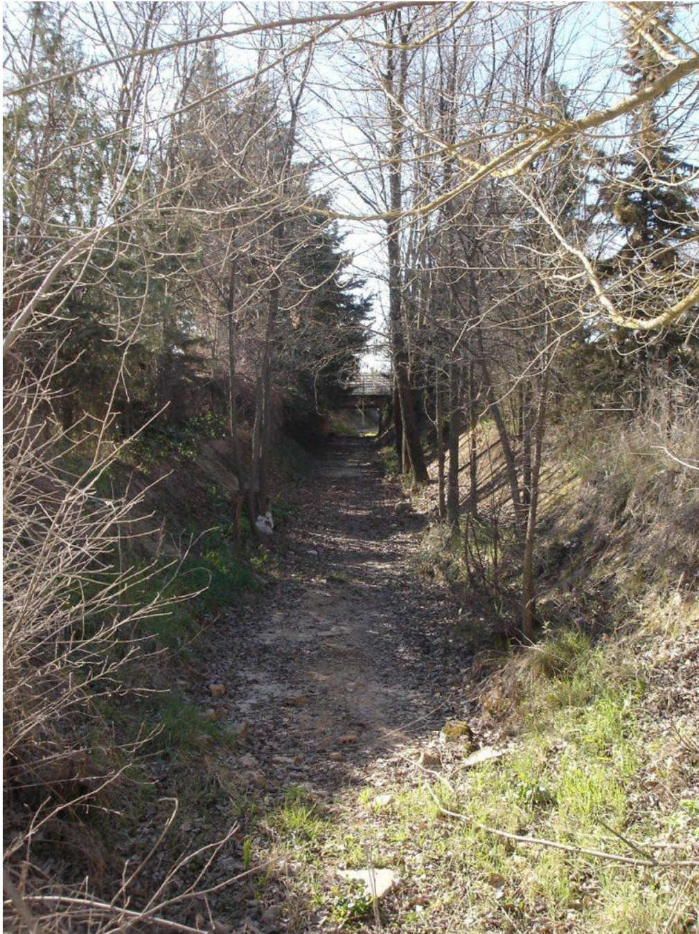
Foto 14. Arroyo de la Plata canalizado, aguas arriba de la charca del Marco en febrero 2012. Observe que no tiene caudal.
