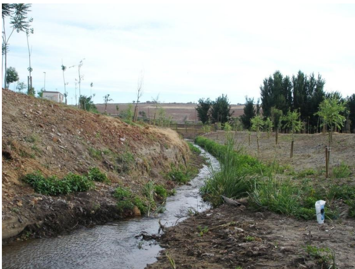
Foto 40. Caudal en la Ribera del Marco, debido a la entrada de agua por el aliviadero del colector de aguas pluviales de la Avenida de la Hispanidad con la Ribera del Marco el 18/06/12.
