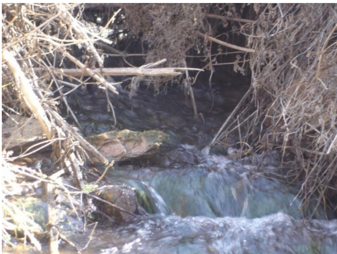
Foto 24. Flujo de agua en la salida al exterior de la galería de drenaje de la Mina Esmeralda (22/02/2012).
