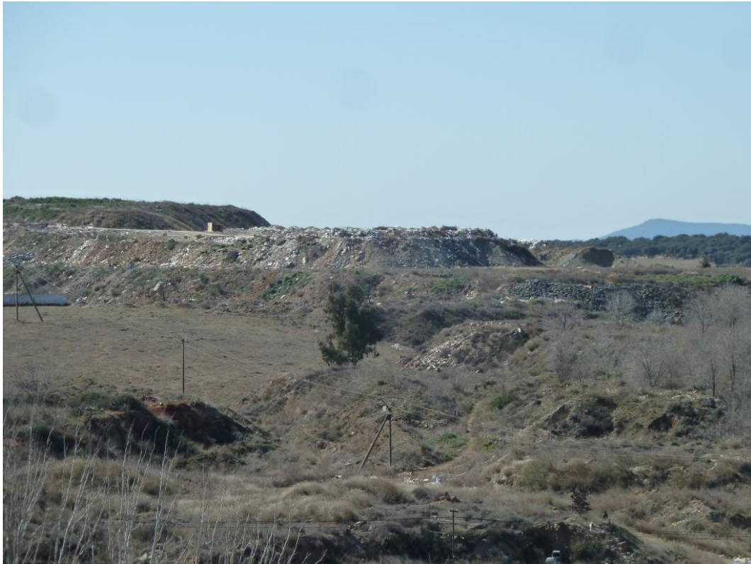
Foto 47. Escombrera del Junquillo (27/02/12).
