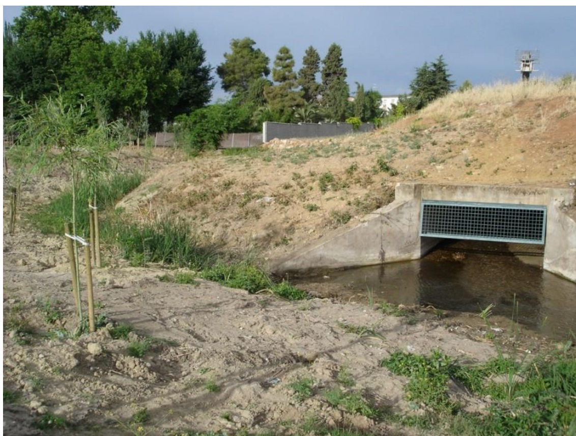
Foto 39. Confluencia del aliviadero del colector de aguas pluviales de la Avenida de la Hispanidad con la Ribera del Marco el 18/06/12.
