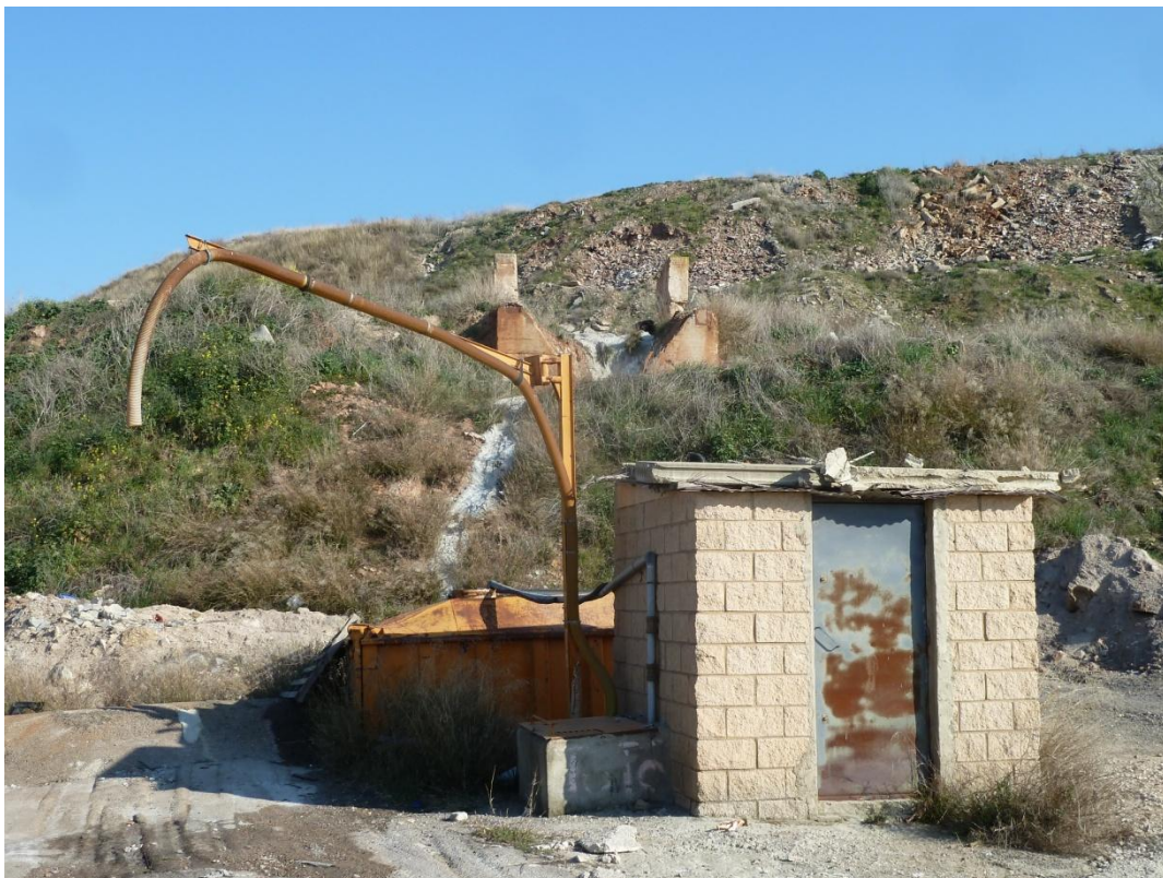
Foto 32. Pozo de la escombrera (27/02/12).
