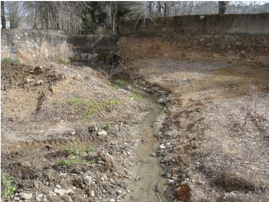
Foto 16. Caudal en la salida de la Charca del Marco tras su vaciado y limpieza en marzo de 2012.
