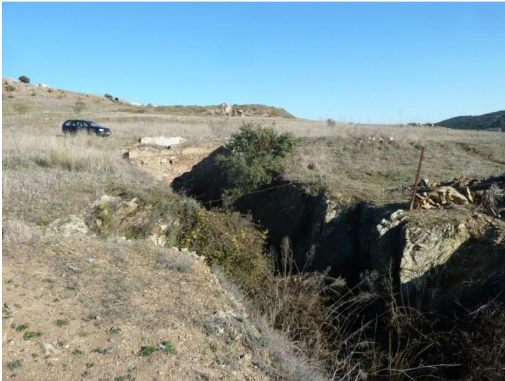
Foto 23. Salida al exterior de las aguas de drenaje de la Mina Esmeralda (22/02/2012).
