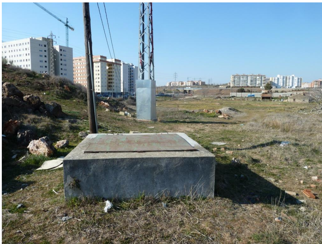
Foto 30. Uno de los pozos del Junquillo (27/02/12). A la izquierda se observan los edificios de reciente construcción.
