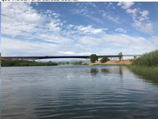
Subtramo 6, aguas abajo de Talavera, con valores del índice QBR que indican una calidad intermedia y alteraciones importantes.
