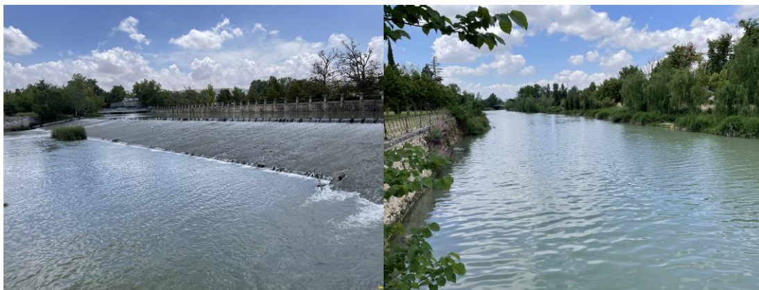
Azud del Palacio Real y subtramo aguas abajo del mismo.
