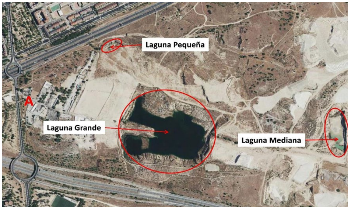
Imagen 1: Ubicación de las Lagunas Grande, Mediana y Pequeñas de Ambroz. La A en rojo señala el acceso principal al complejo lagunar. Fuente: SigPac .
