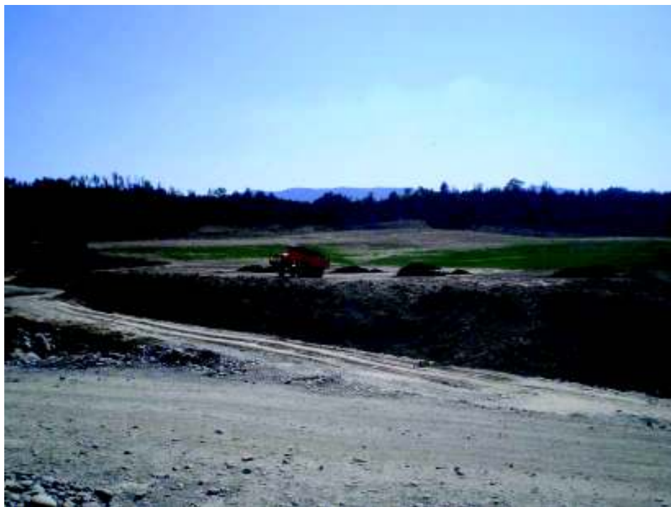
Ilustración 22: Movimiento de tierras
