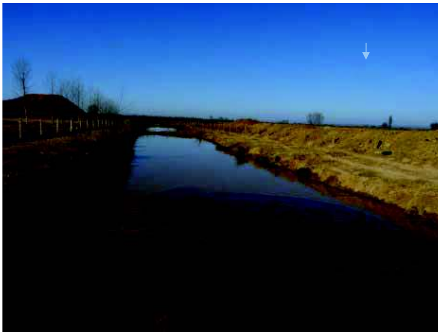
Ilustración 40: Balsa decantación de lodos
