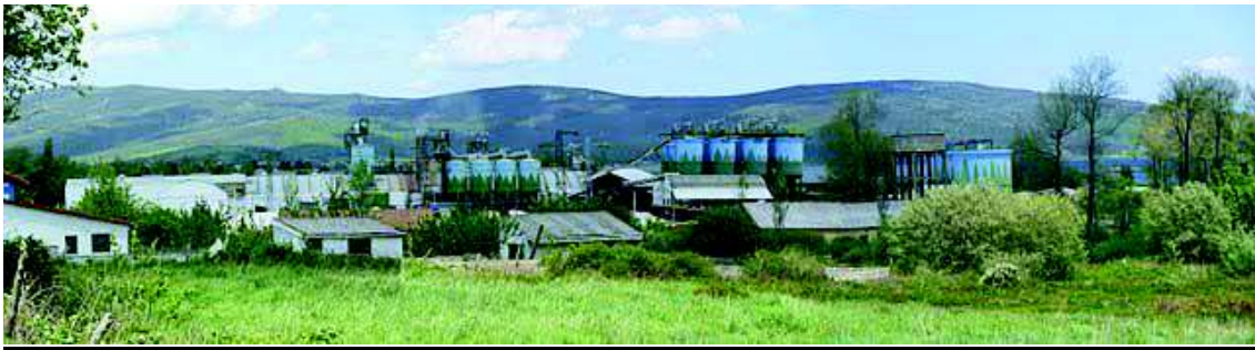
Ilustración 28: Vista general de una planta de tratamiento
