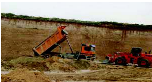
Ilustración 72: Relleno de huecos con estériles
