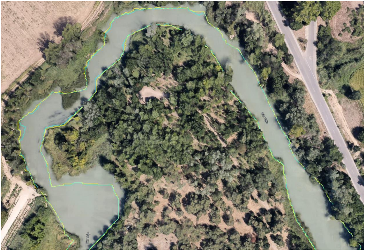
Figura 27. Alturas de la lámina de agua en Aranjuez para caudales mínimos 6-8.5 (detalle)
