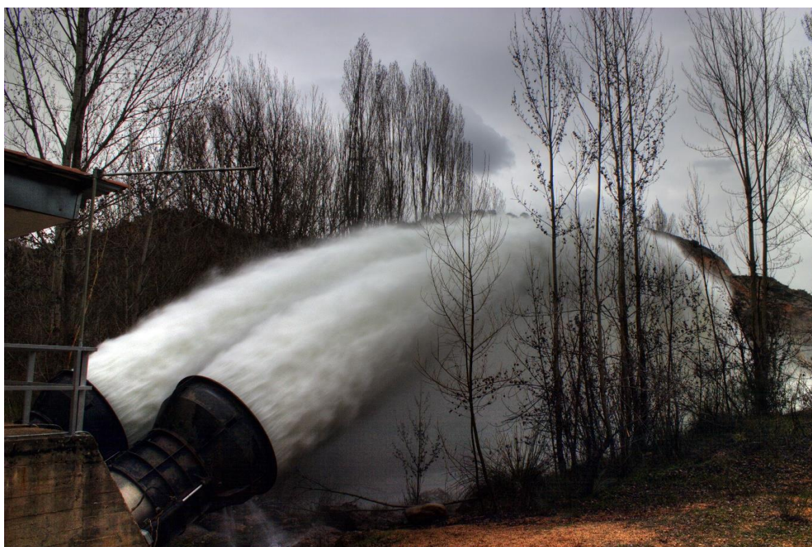
Figura 2. Válvulas de chorro hueco de la Presa de Beleña
