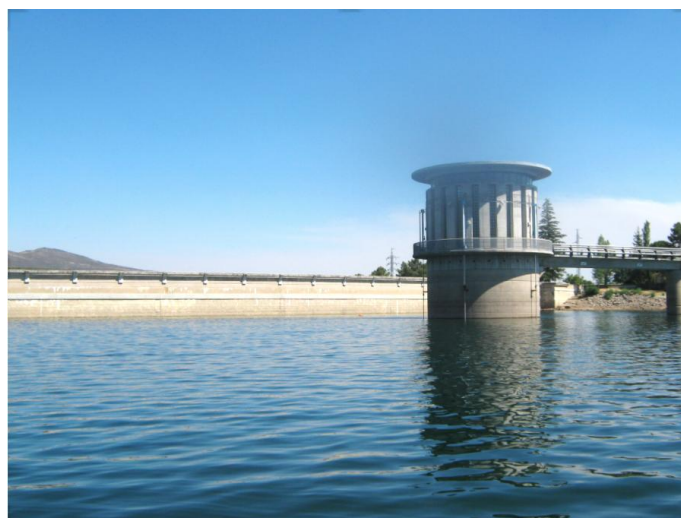
Torre para captación de abastecimiento
