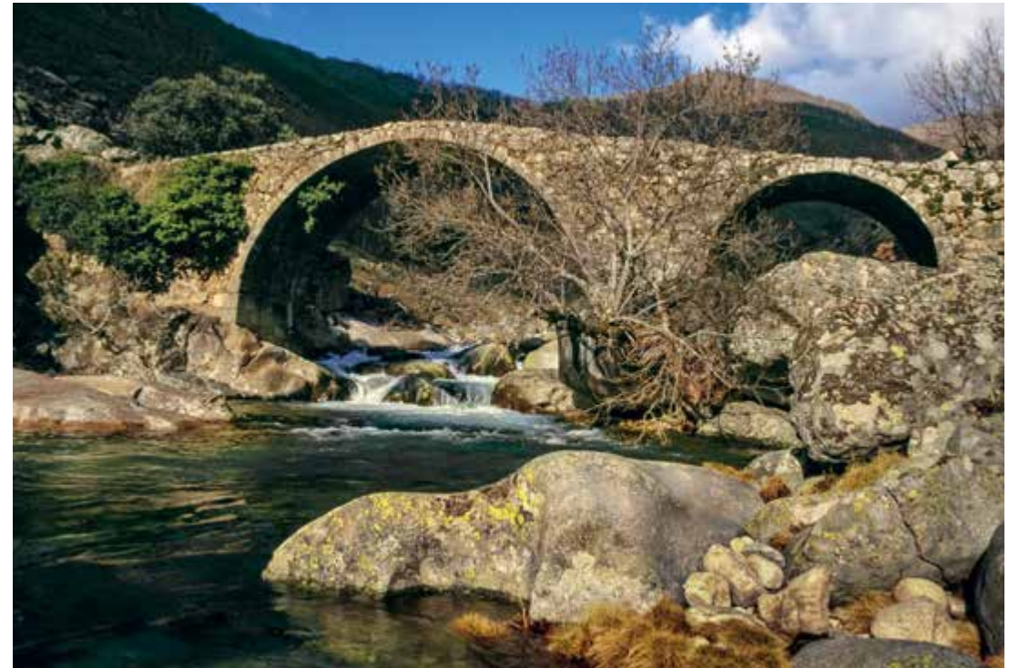
Puente de Carlos V, en la Garganta de los Infiernos.
