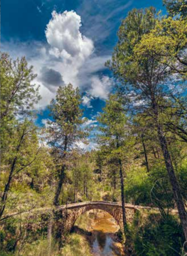
Puente medieval de Barbazoso.
