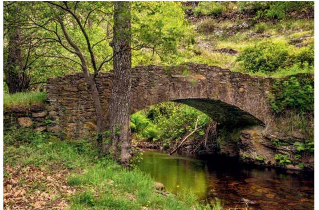
Puente de El Batán sobre el río Pelagallinas.
