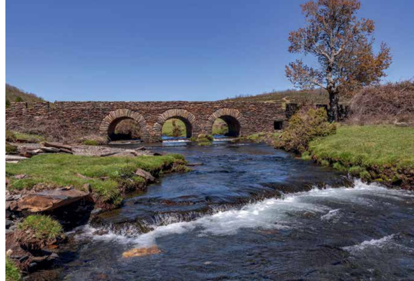
Puente del Cerezo sobre el río Lillas.
