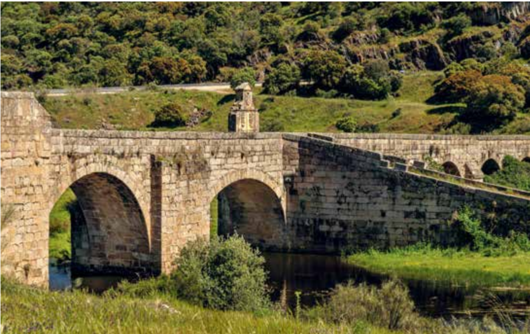
Histórico puente del Cardenal, construido con sillares de granito con nueve arcos y templete.
