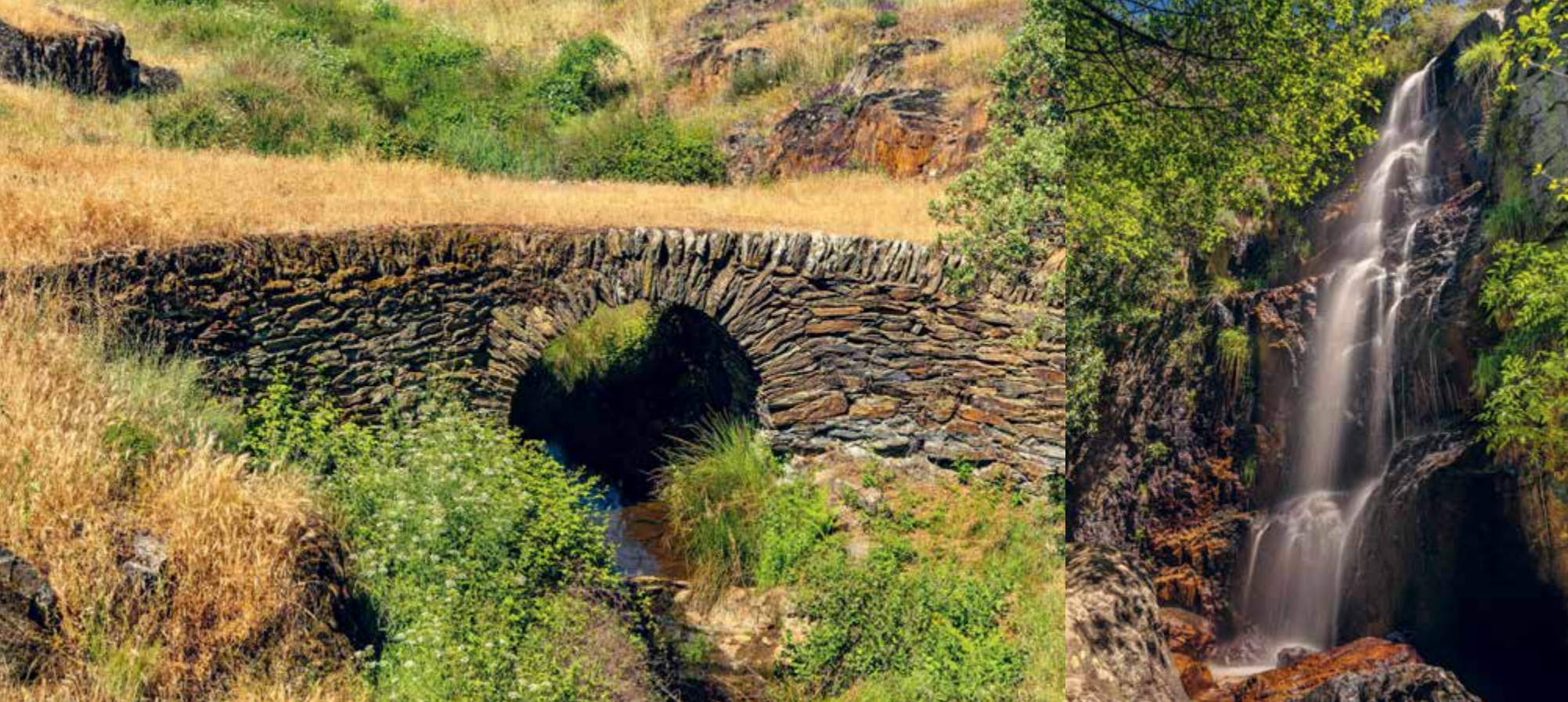
Puente tradicional sobre el arroyo del Endrino, próximo al río Gévalo.
