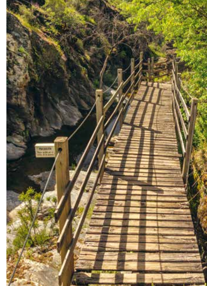
Pasarelas en el sendero del río Malvecino.
