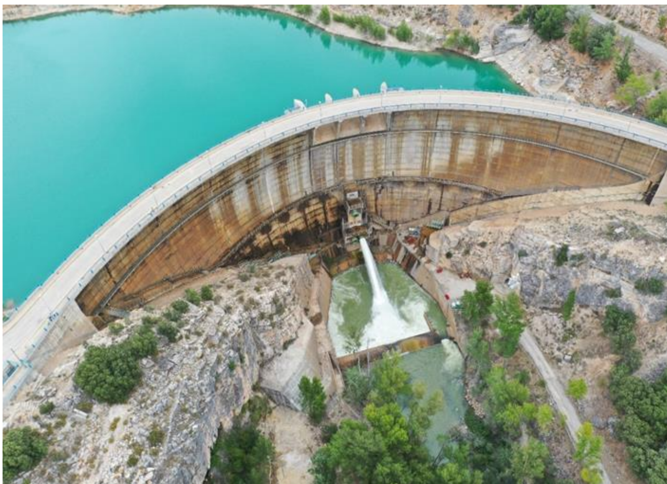
Presa de la Tajera
