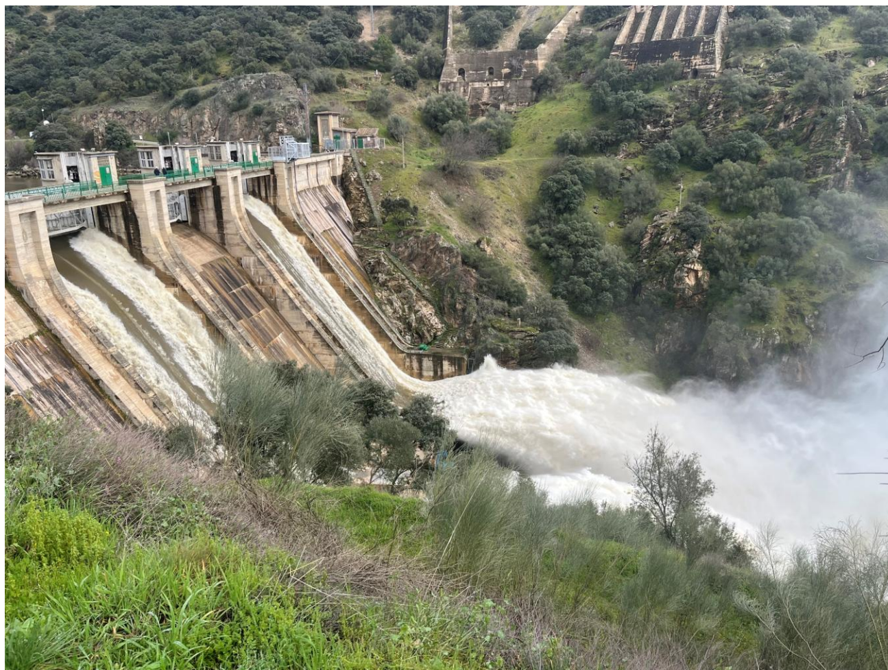
Presa de Picadas
