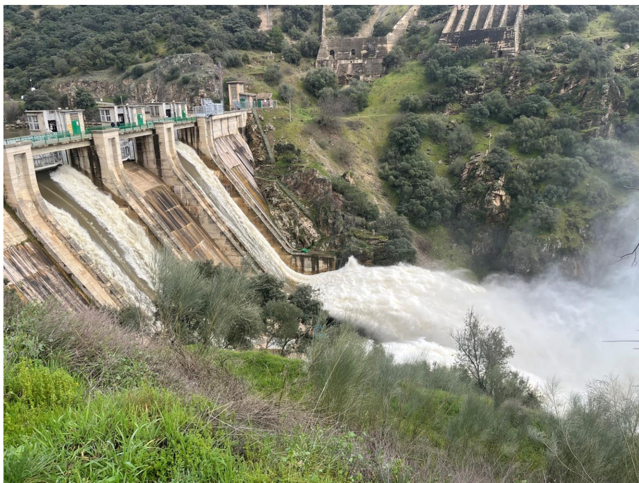
Presa de Picadas
